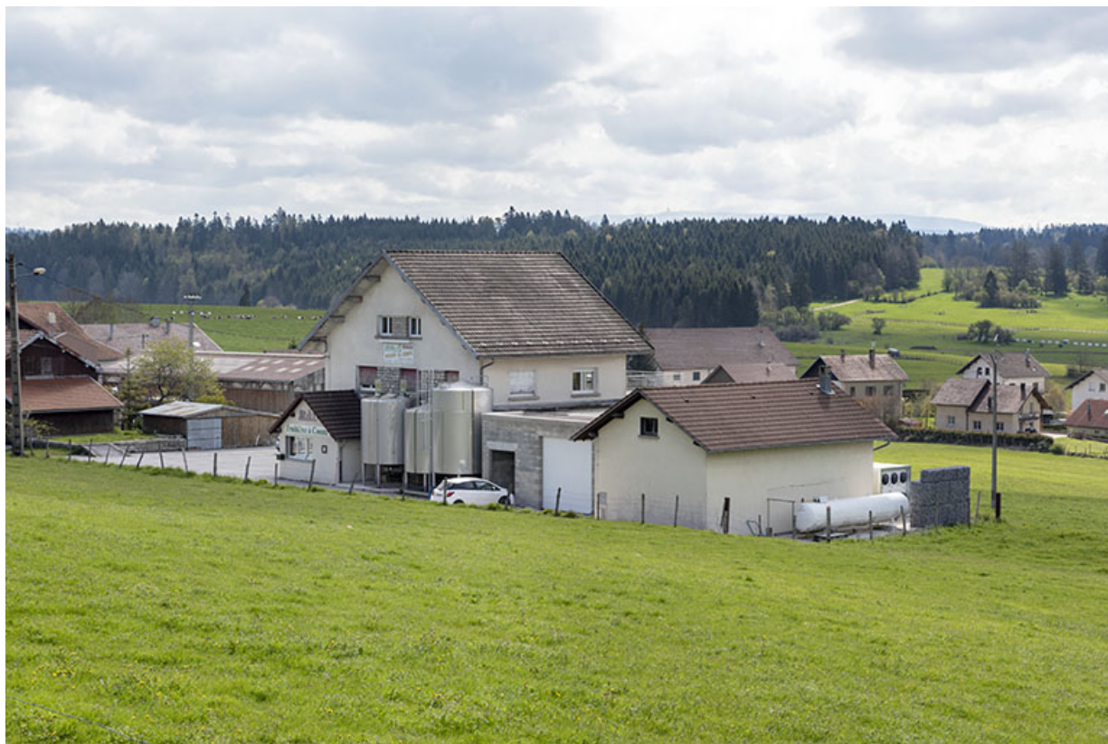
Vue d'ensemble, depuis l'ouest (façades antérieure et latérale droite). 25, Les Fontenelles, 2 rue de la Gare
