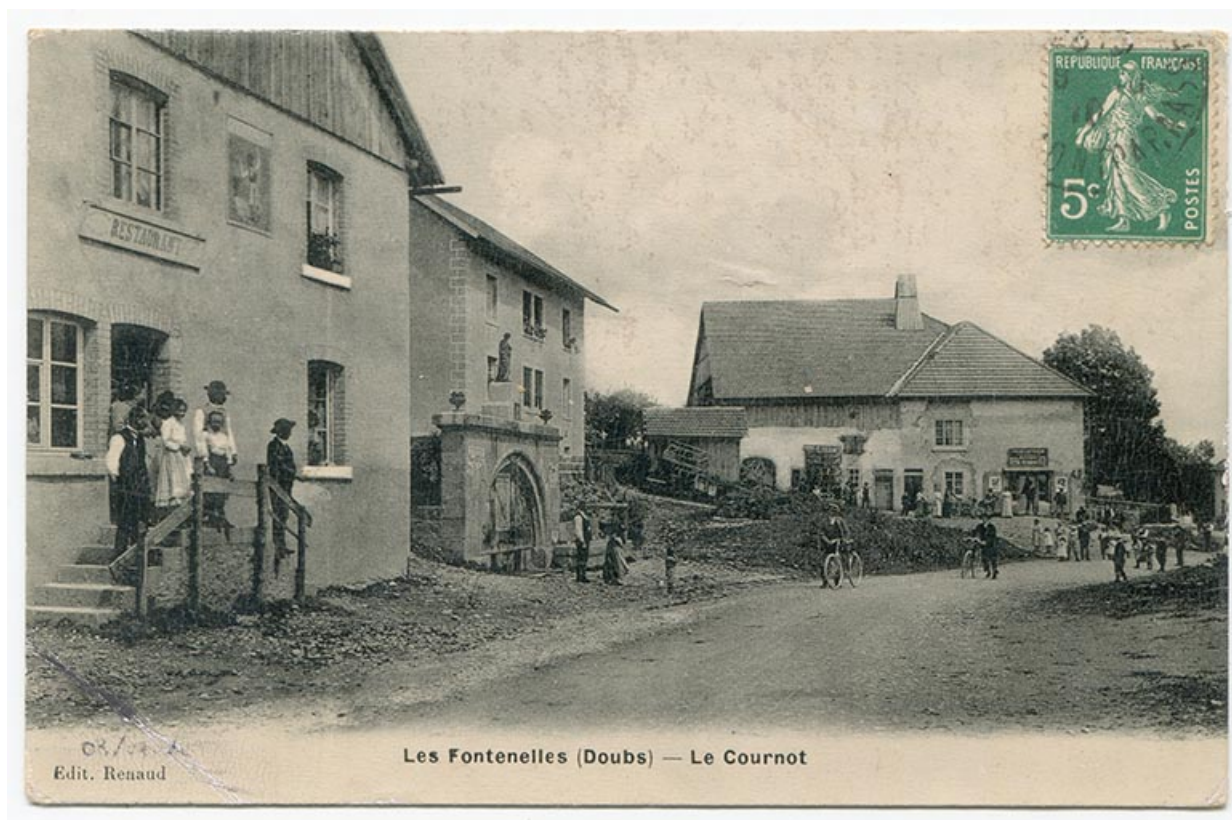
Les Fontenelles (Doubs) - Le Cournot, 1er quart 20e siècle [avant 1910 ?].
