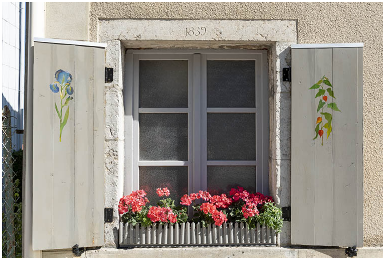
Bâtiment d'origine : linteau daté 1839. 25, Les Fontenelles, 18 rue Principale
