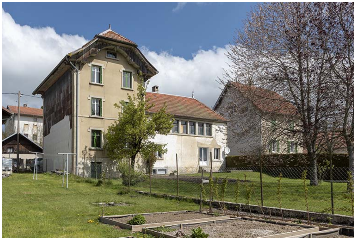
Façade postérieure, de trois quarts gauche. 25, Les Fontenelles, 18 rue Principale
