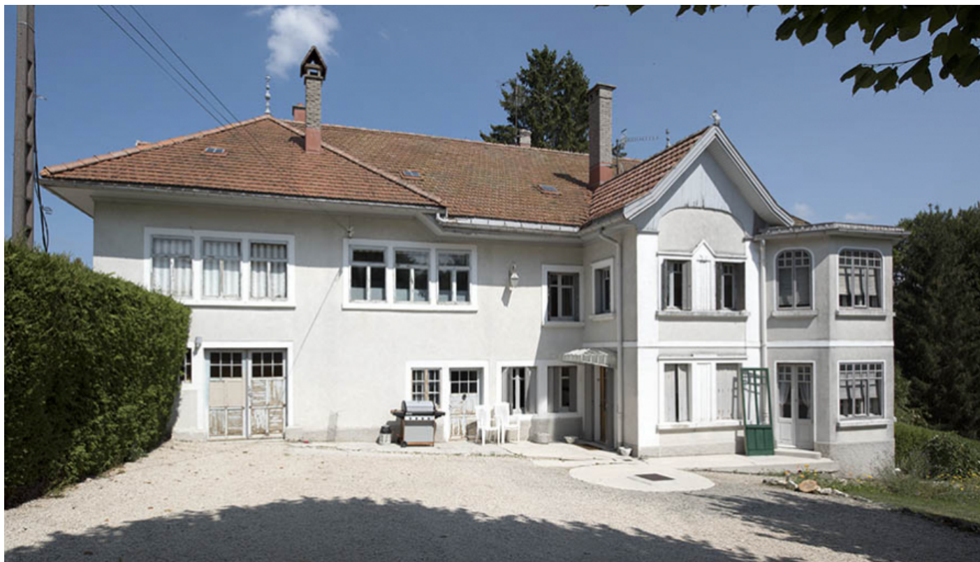
Atelier de 1920 et ancienne ferme : façade antérieure (sud), de trois quarts gauche. 25, Les Fontenelles, 12 rue Principale
