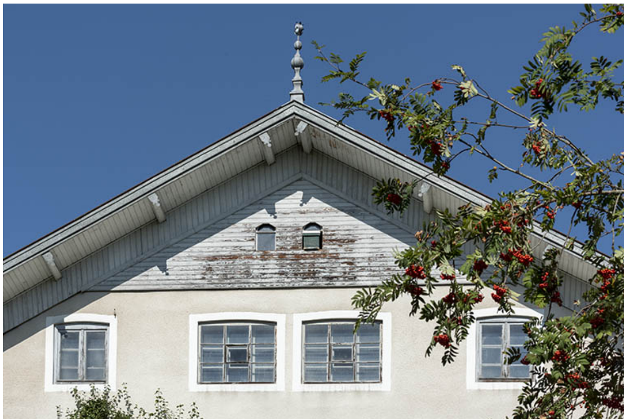
Ancienne ferme, façade latérale droite : fenêtres de l'atelier dans le comble. 25, Les Fontenelles, 12 rue Principale
