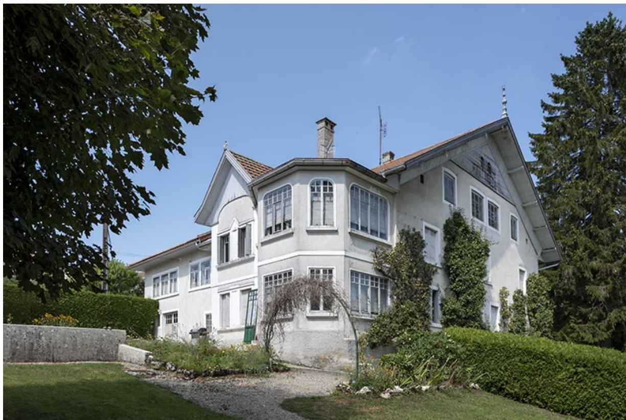
Ancienne ferme : façades antérieure et latérale droite.
