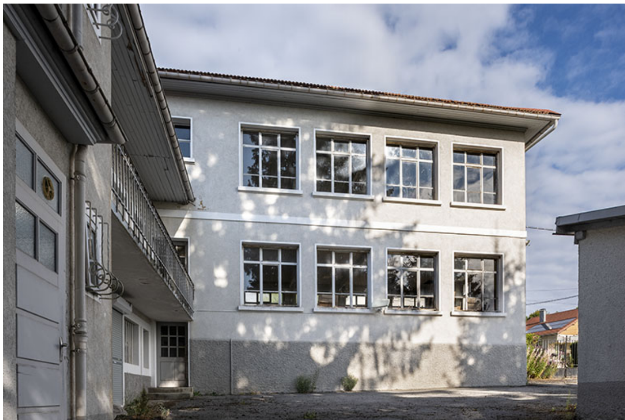
Atelier de 1930 : façade postérieure (est). 25, Les Fontenelles, 12 rue Principale
