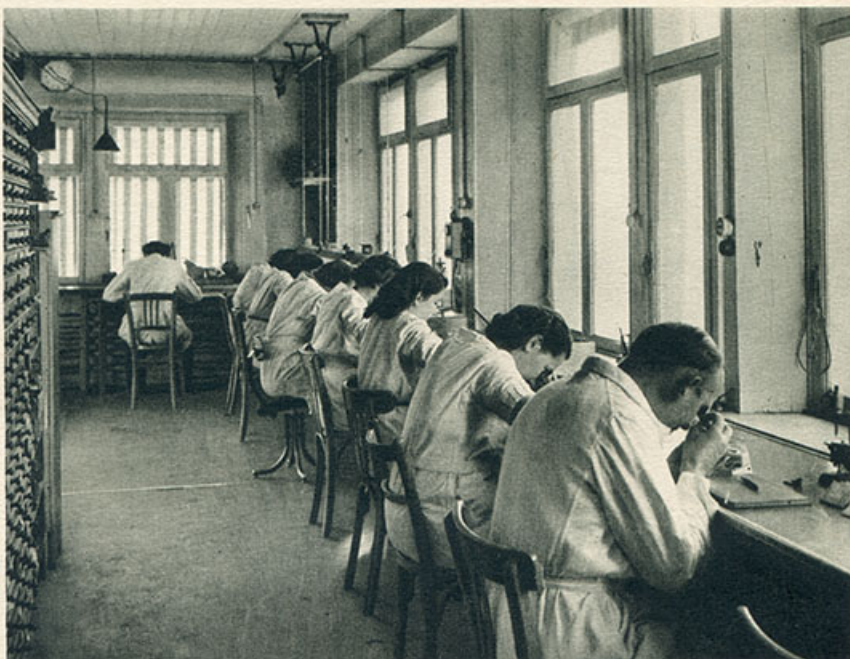
LES FONTENELLES Atelier de visitage des axes, tiges, cylindres
