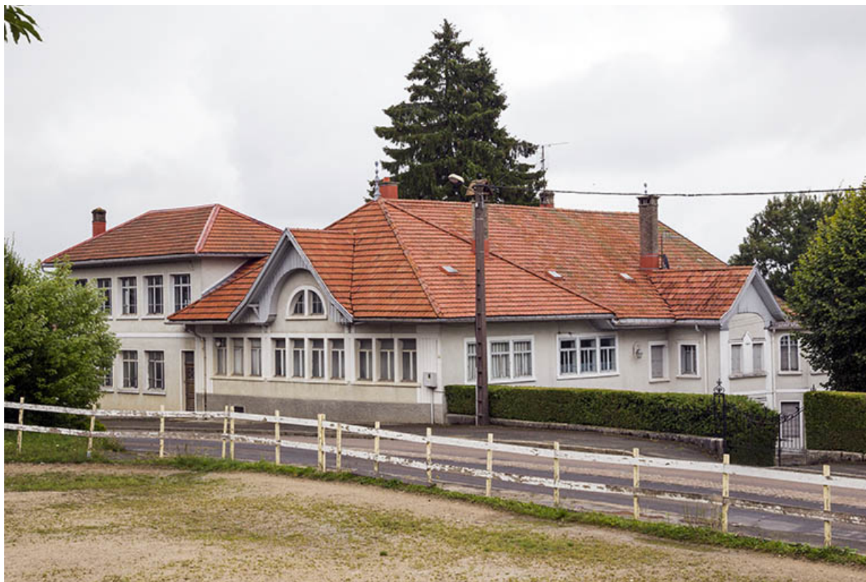
Vue plongeante sur l'ancienne ferme et l'atelier de 1920, depuis l'ouest. 25, Les Fontenelles, 12 rue Principale
