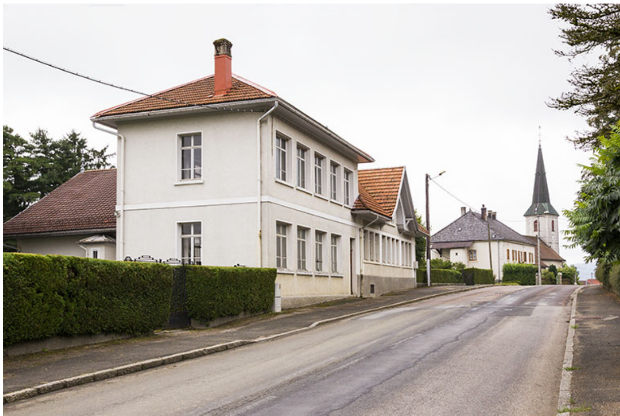
Atelier de 1930 : façades antérieure et latérale gauche.
