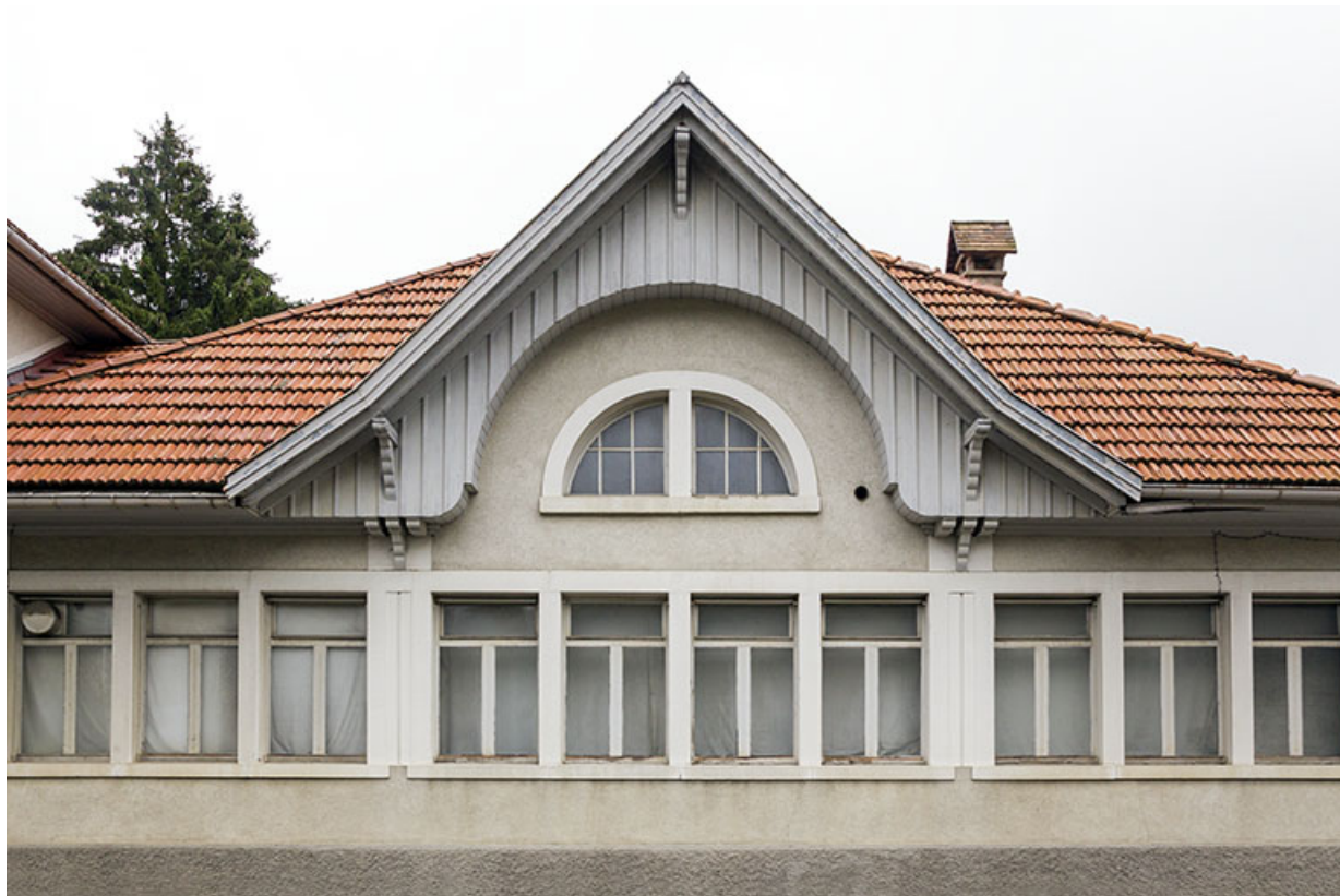
Atelier de 1920, façade latérale gauche (ouest) : fronton et fenêtres multiples. 25, Les Fontenelles, 12 rue Principale
