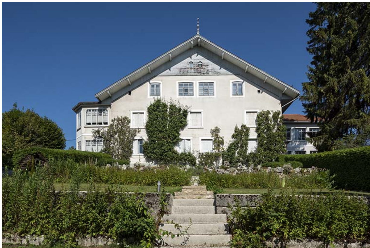
Ancienne ferme : façade latérale droite (est).
