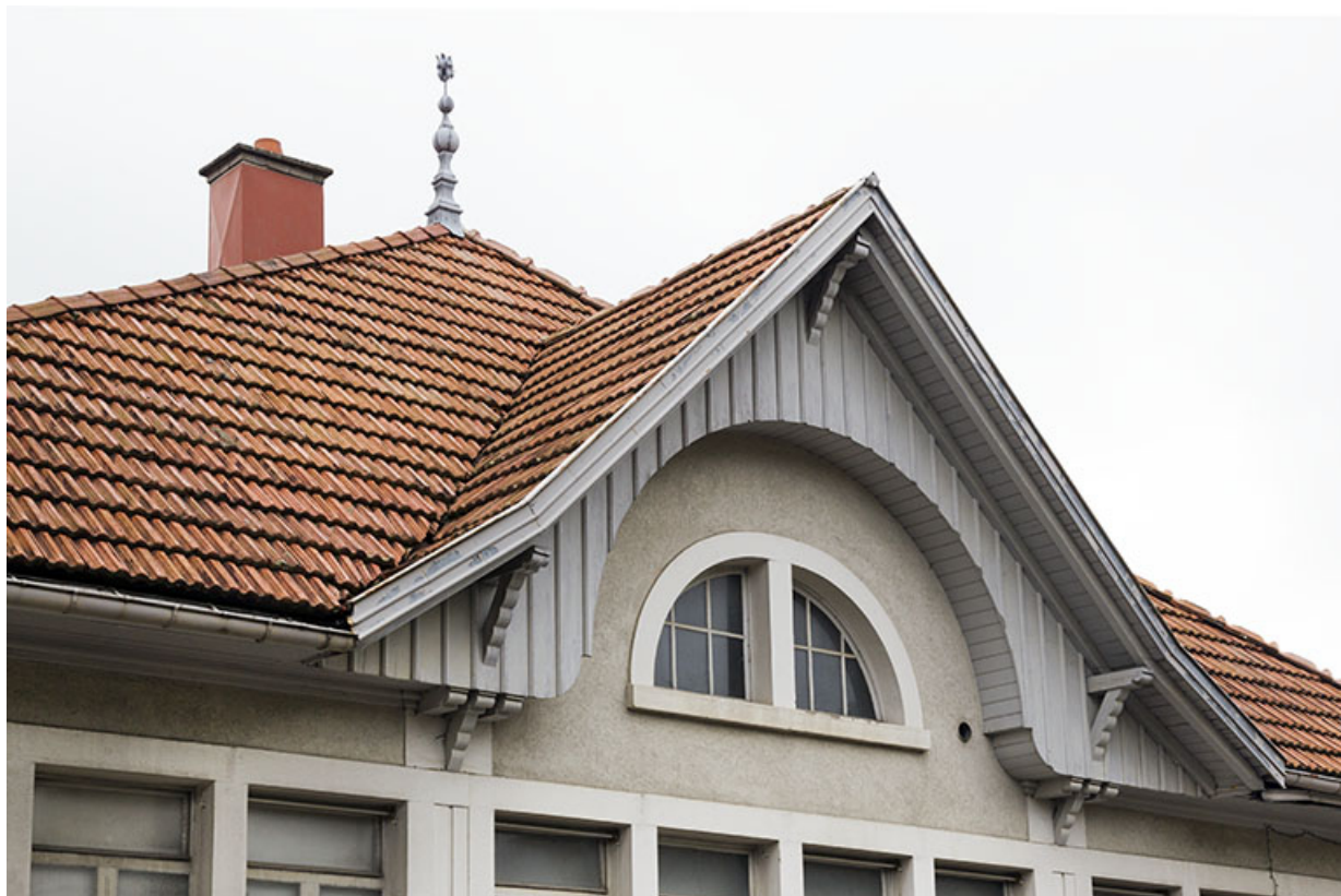
Atelier de 1920, façade latérale gauche : fronton.
