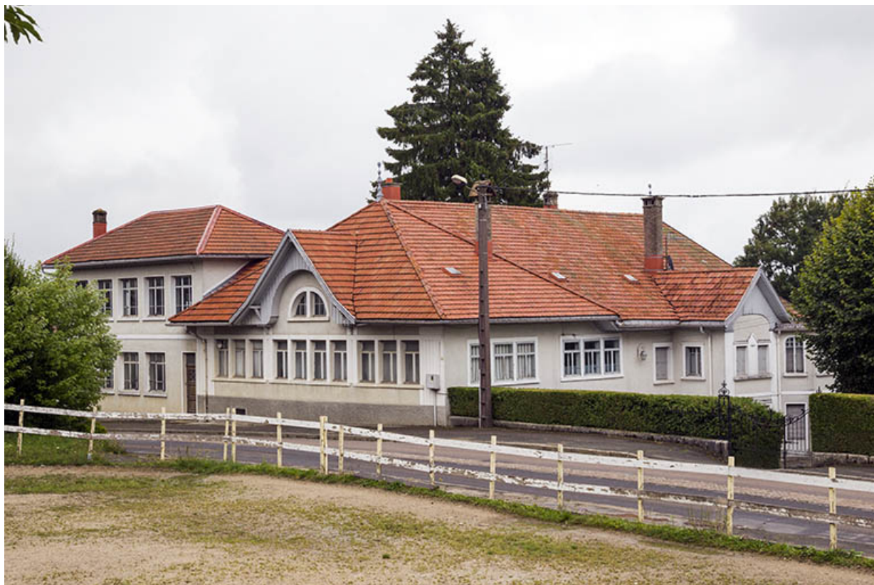
Vue plongeante sur l'ancienne ferme et l'atelier de 1920, depuis l'ouest.
