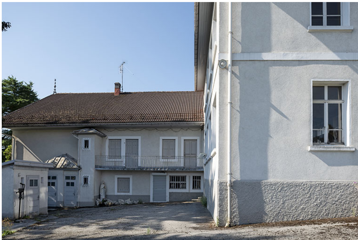
Ancienne ferme : façade postérieure (nord). 25, Les Fontenelles, 12 rue Principale
