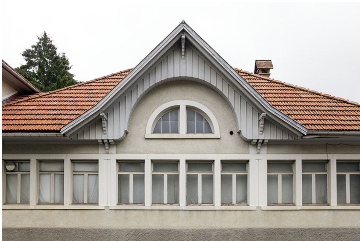
Atelier de 1920, façade latérale gauche (ouest) : fronton et fenêtres multiples. 25, Les Fontenelles, 12 rue Principale
