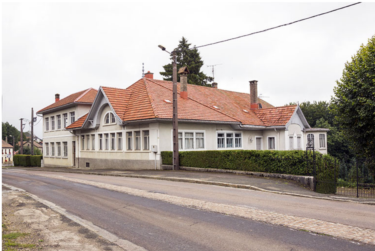
Ferme et usine de fournitures pour l'horlogerie, d'échappements à cylindre et de décolletage Cheval Frères, aux Fontenelles. 25, Les Fontenelles, 12 rue Principale
