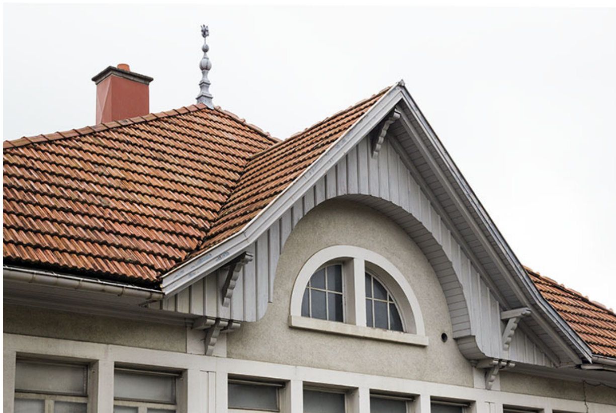
Atelier de 1920, façade latérale gauche : fronton.
