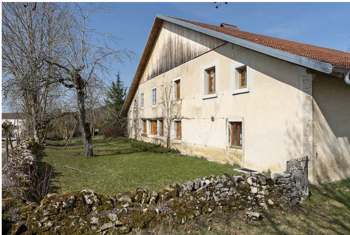
Façade sud, vue en enfilade.
