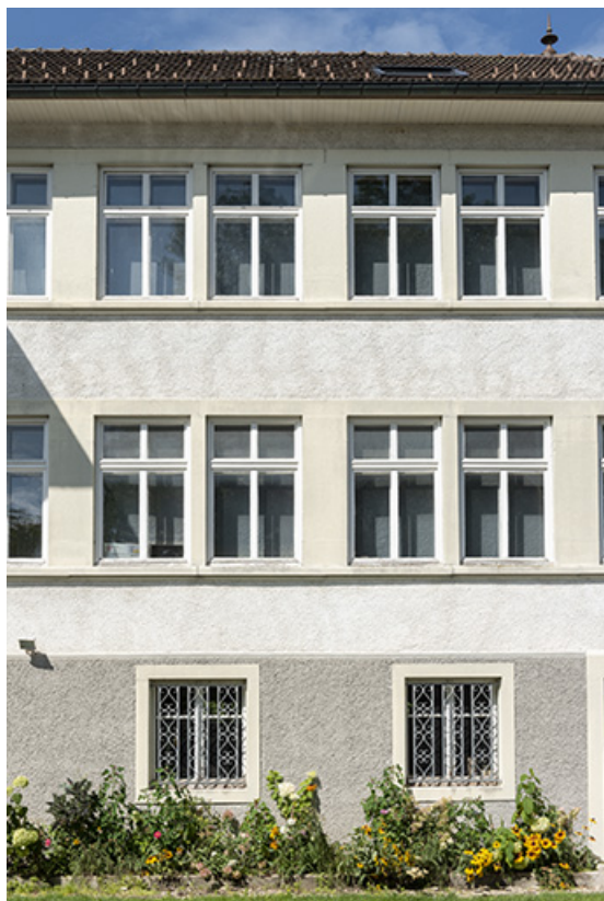
Usine : travées centrales de la façade antérieure.
