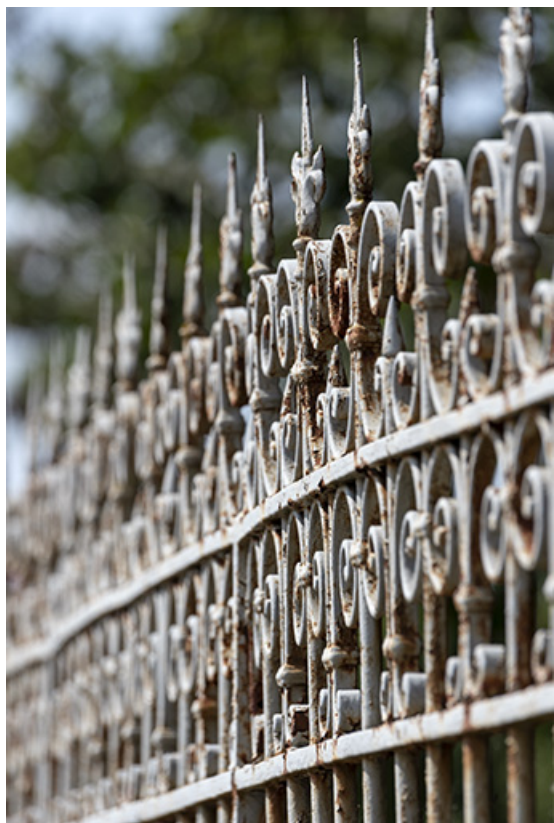
Clôture : détail de ferronnerie de la grille, vue en enfilade.
