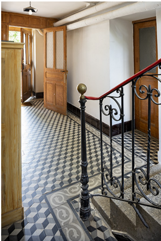
Usine : entrée et départ d'escalier.
