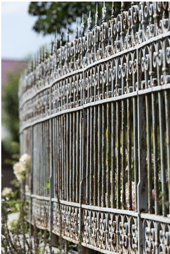
Clôture : grille, vue en enfilade.
