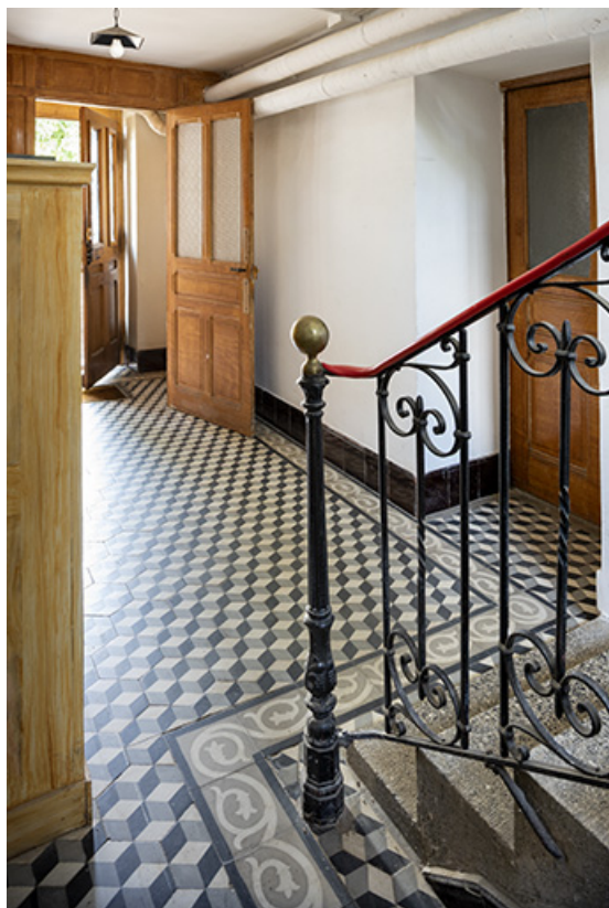
Usine : entrée et départ d'escalier.
