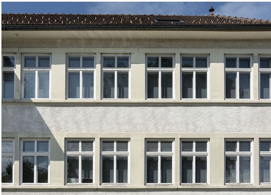
Usine : fenêtres horlogères sur la façade antérieure.
