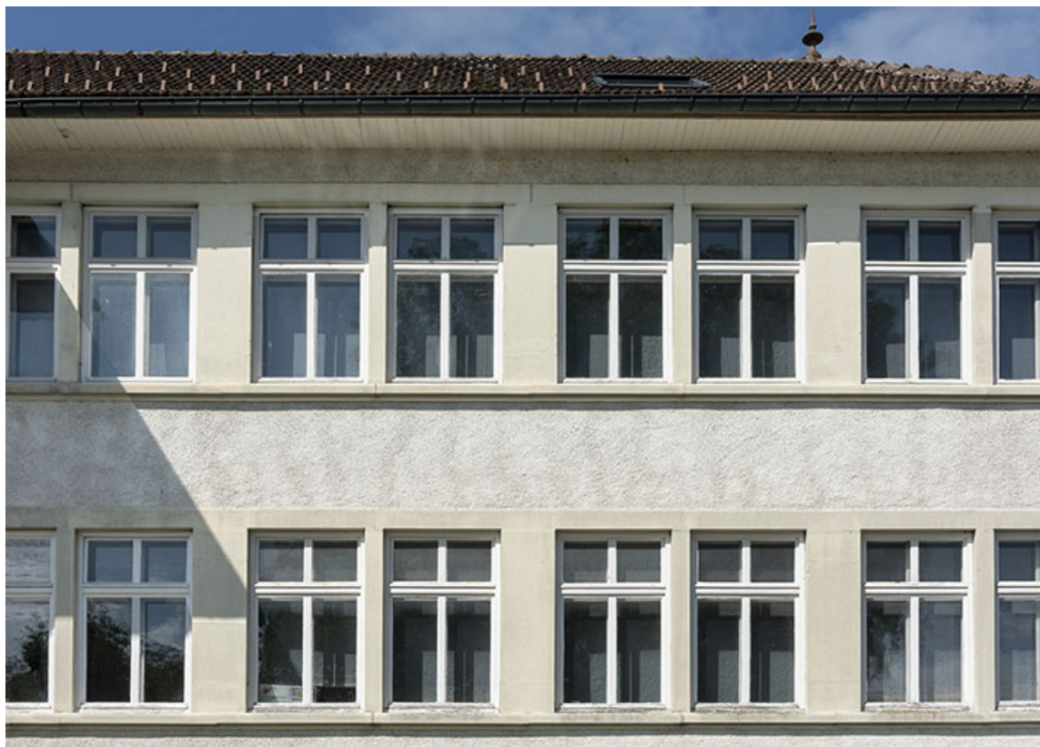
Usine : fenêtres horlogères sur la façade antérieure.
