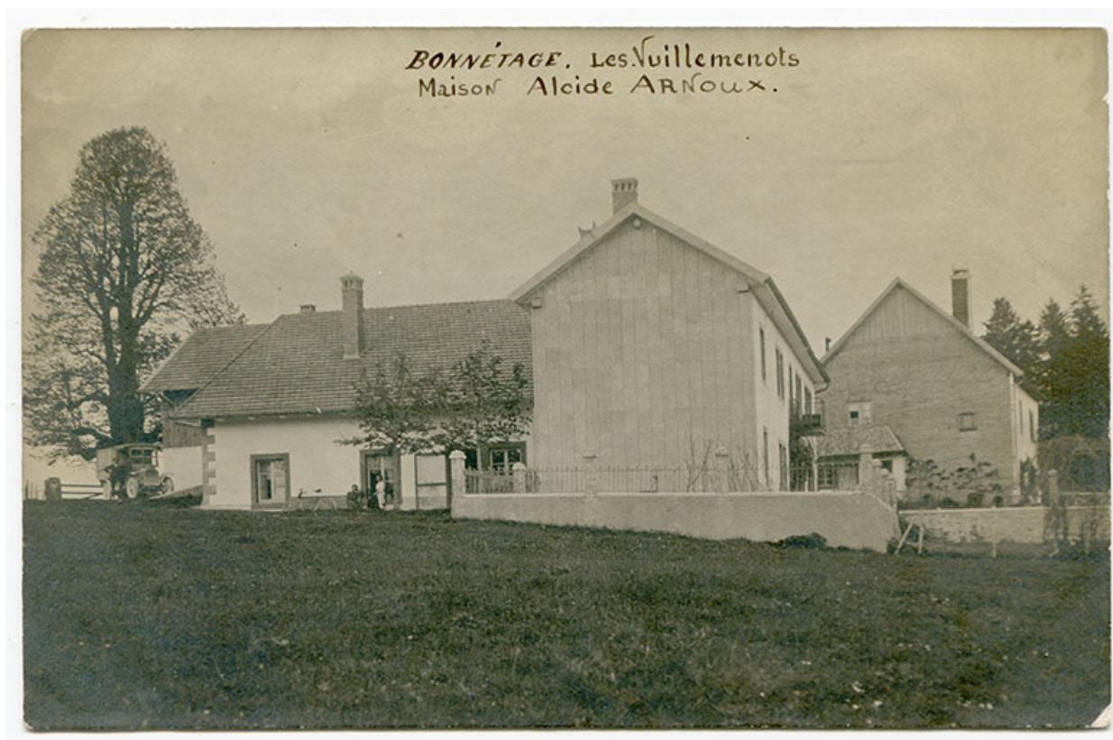
Bonnétagé. Les Vuillemenots. Maison Alcide Arnoux, 1er quart 20e siècle.
