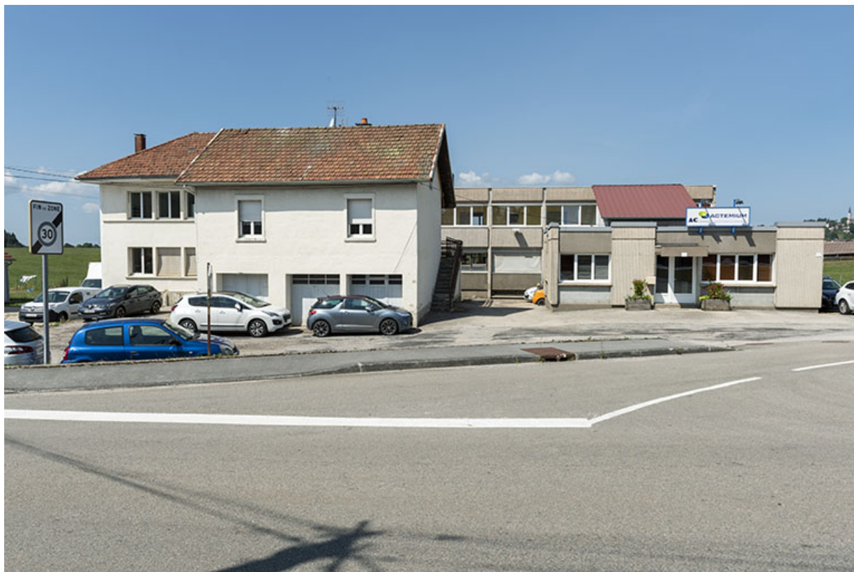
Vue d'ensemble depuis l'est : bâtiments anciens à gauche, récents à droite.
