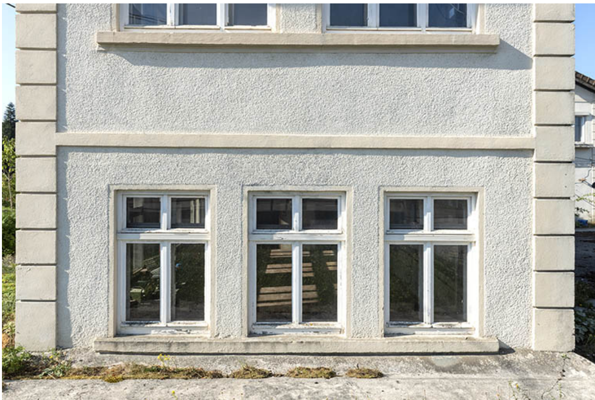
Site d'origine : fenêtres au rez-de-chaussée sur la façade latérale droite de l'usine.
