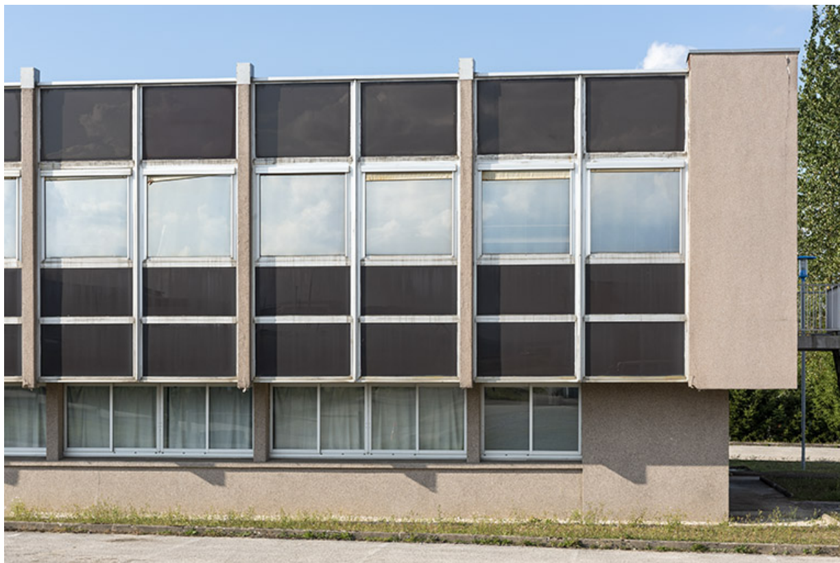
Façade antérieure : extrémité droite.
