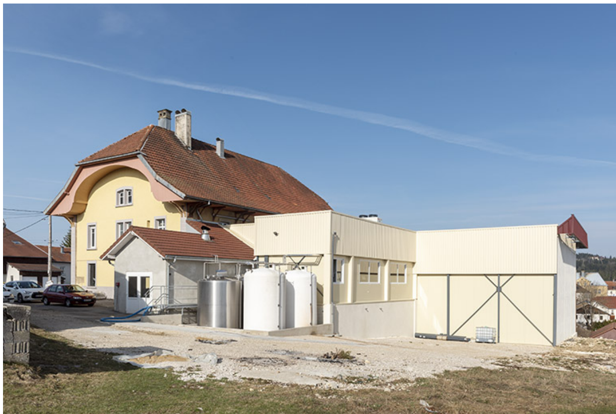
Façade latérale droite et extension, depuis l'est.
