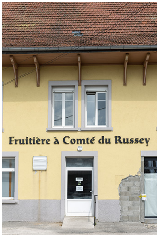
Façade antérieure : travée centrale.
