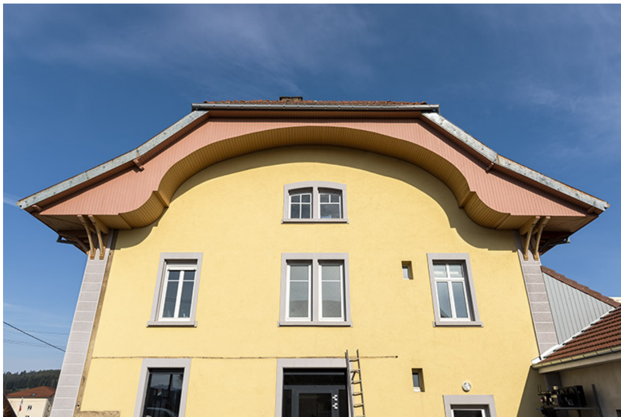
Façade latérale droite, vue en contre-plongée.
