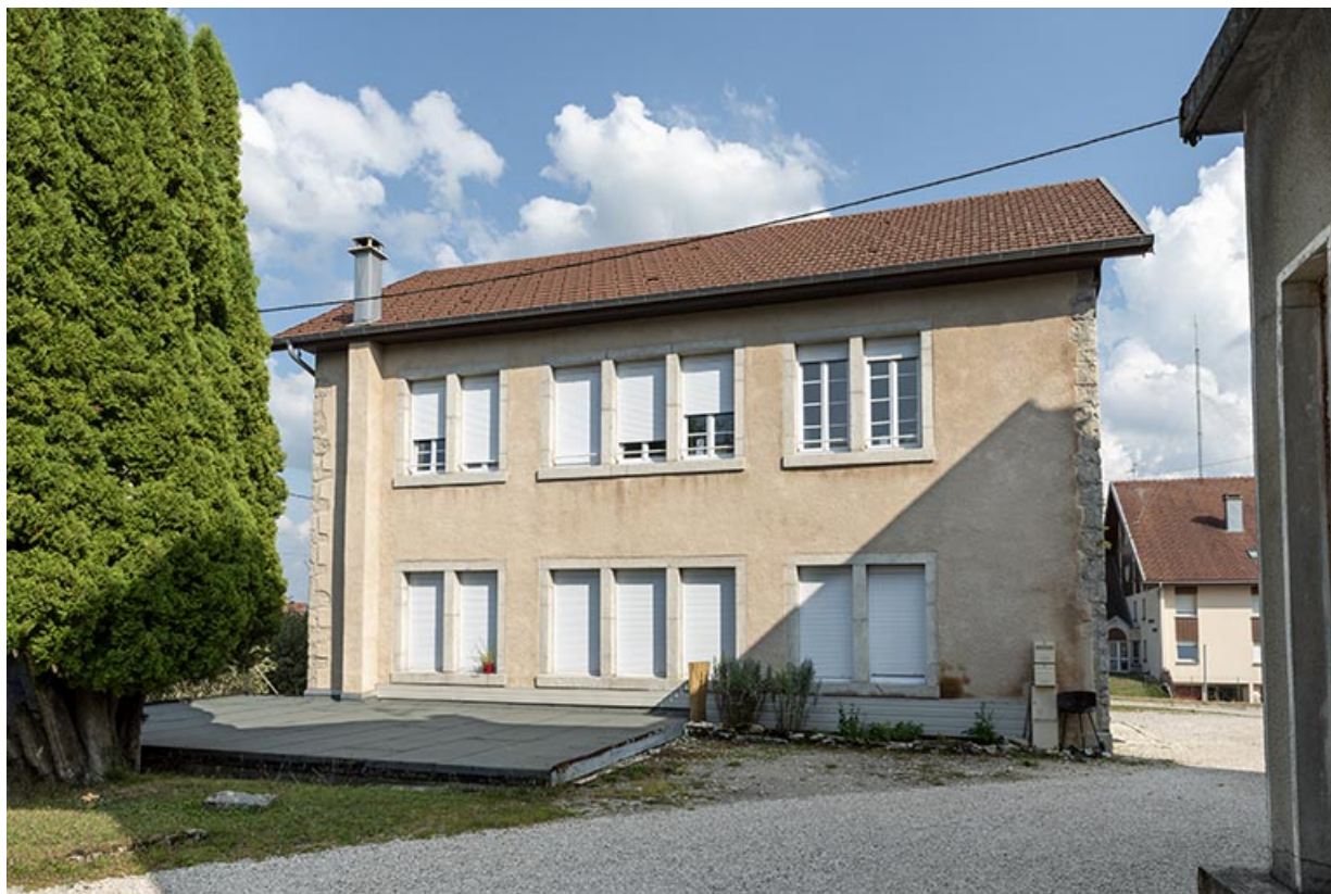
Atelier de fabrication : façade ouest.
