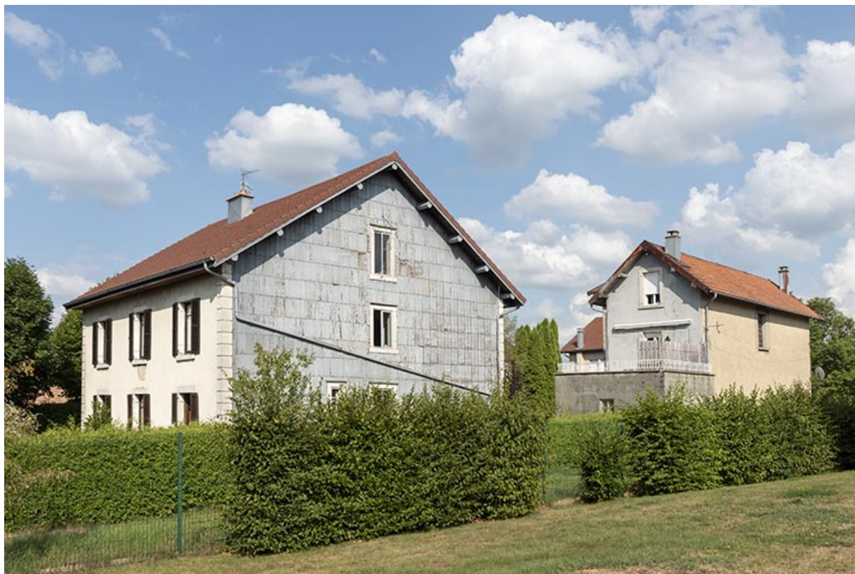
Maison et logement de contremaître, depuis le sud-ouest.
