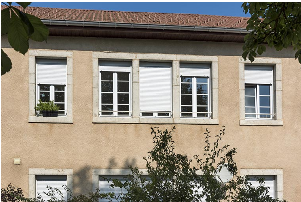
Atelier de fabrication, façade est : fenêtres multiples.
