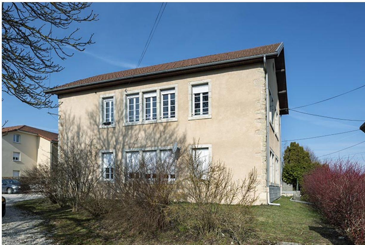
Atelier de fabrication : façade est.
