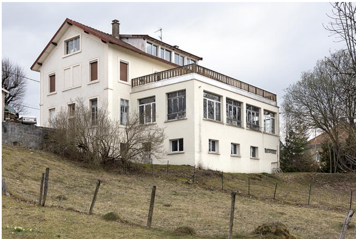
Façades postérieure et latérale droite.
