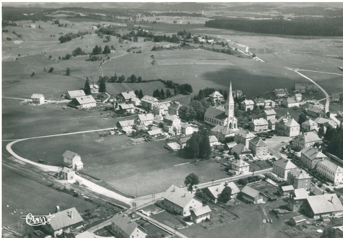
Le Russey (Doubs). 22180 - Vue panoramique aérienne [le village vu de l'ouest], milieu 20e siècle. Le bâtiment est visible à gauche, derrière la gare.
