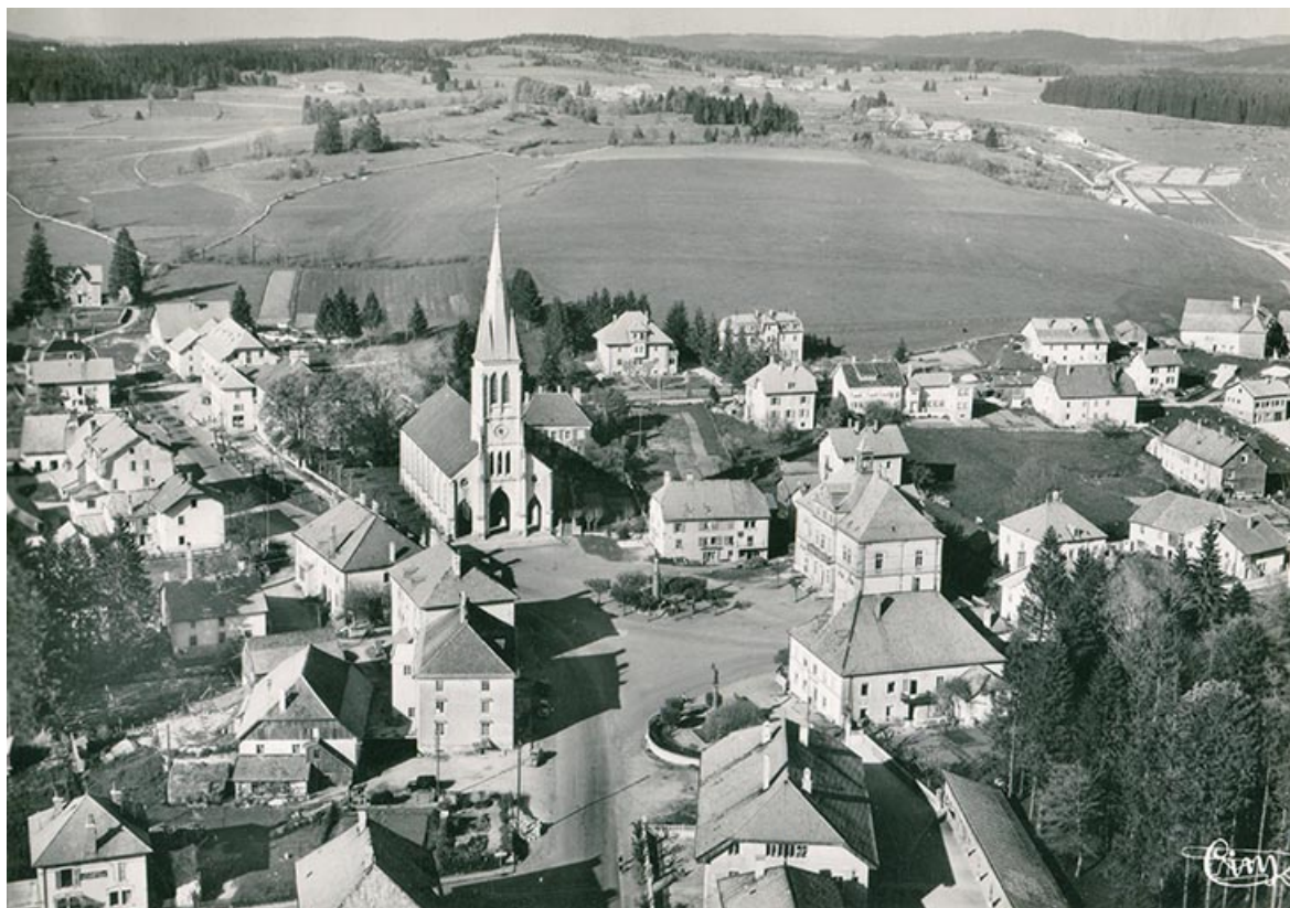
Le Russey (Doubs). 37727 - Vue panoramique aérienne [le centre du village vu du sud-ouest], 3e quart 20e siècle [avant 1966]. 25, Le Russey, 4 rue des Ecoles
