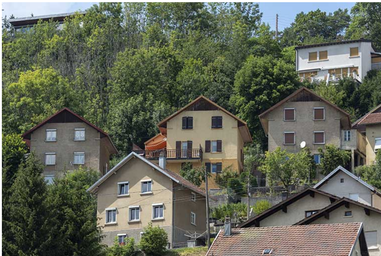
Vue d'ensemble depuis le sud-est (côté vallée) : maison à droite au deuxième plan.
