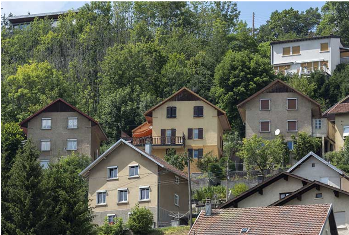
Vue d'ensemble depuis le sud-est (côté vallée) : maison à droite au deuxième plan. 25, Morteau, 46 rue de la Côte
