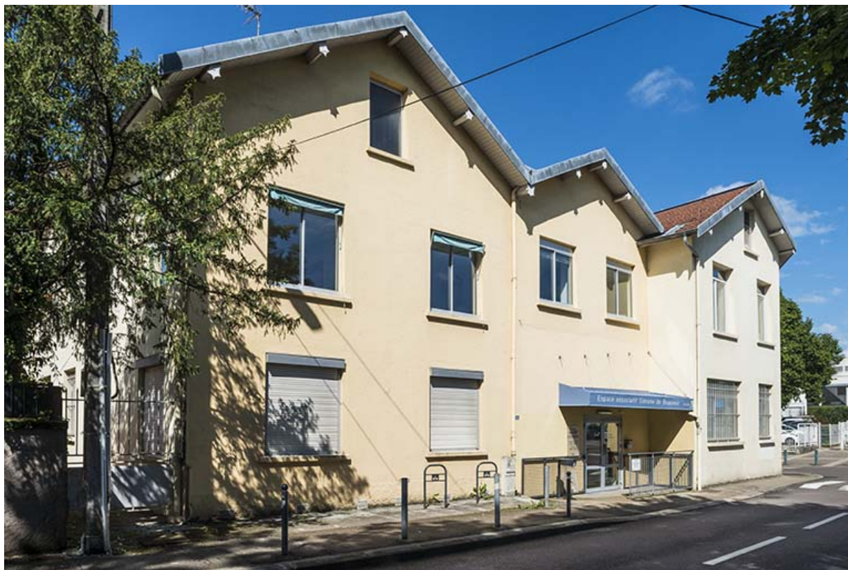
Murs-pignons sur la rue Violet. Vue de trois quarts.
