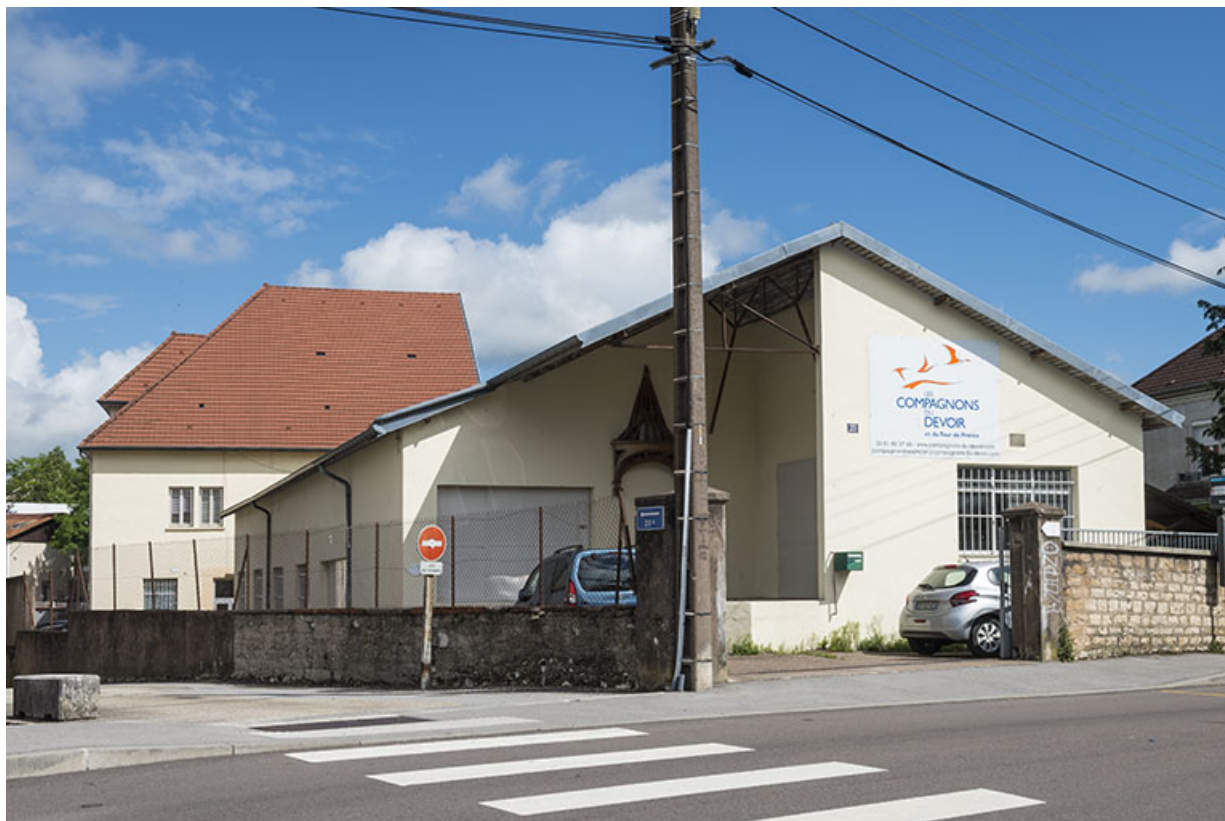
Extension (fin des années 1940). Vue depuis le sud. 25, Besançon, 3 rue Violet
