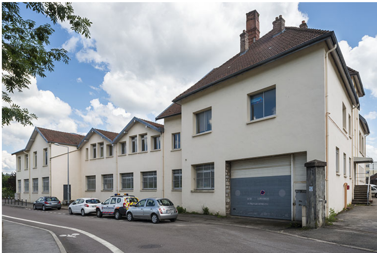
Façades sur la rue Violet. Vue de trois quarts droite.
