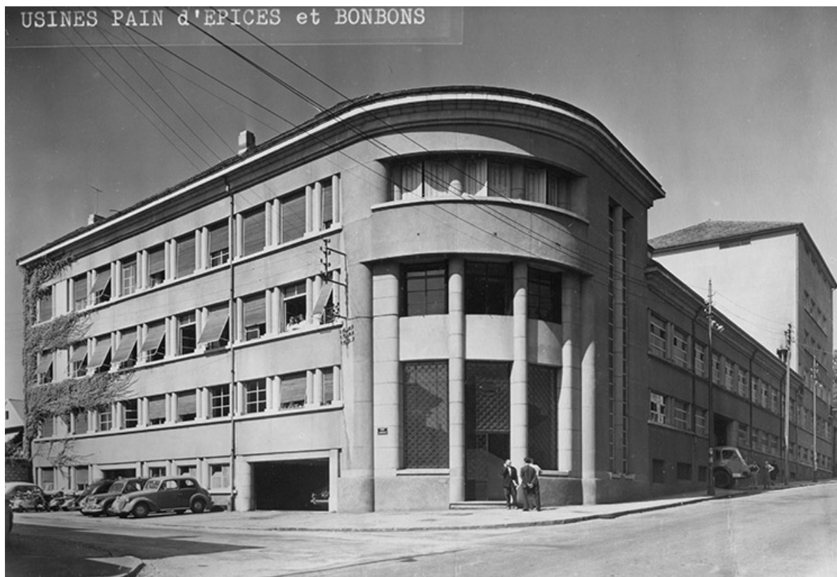
Vue d'ensemble de l'usine depuis la rue de Vesoul, s.d. [vers 1960].
