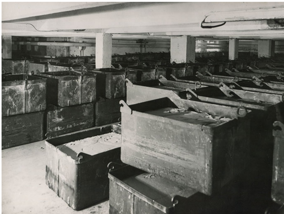
Stockage des matières premières à l'étage de soubassement, s.d. [vers 1960]. 25, Besançon, 33, 35 rue de Vesoul
