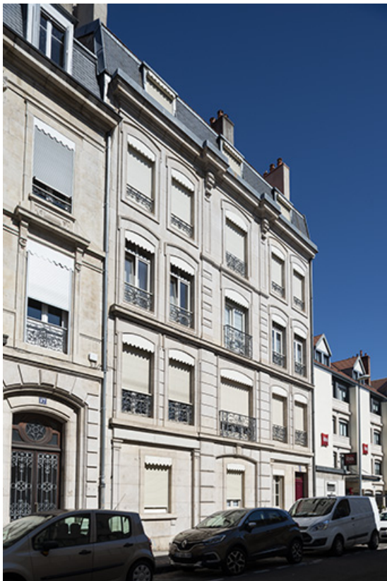
Façade vue de trois quarts (n°19). 25, Besançon, 17-19 rue Gambetta
