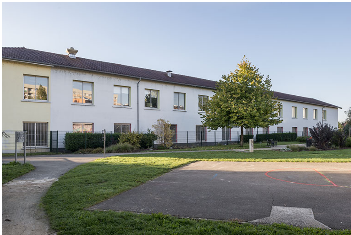
Façade nord de l'agrandissement (milieu 20e siècle).
