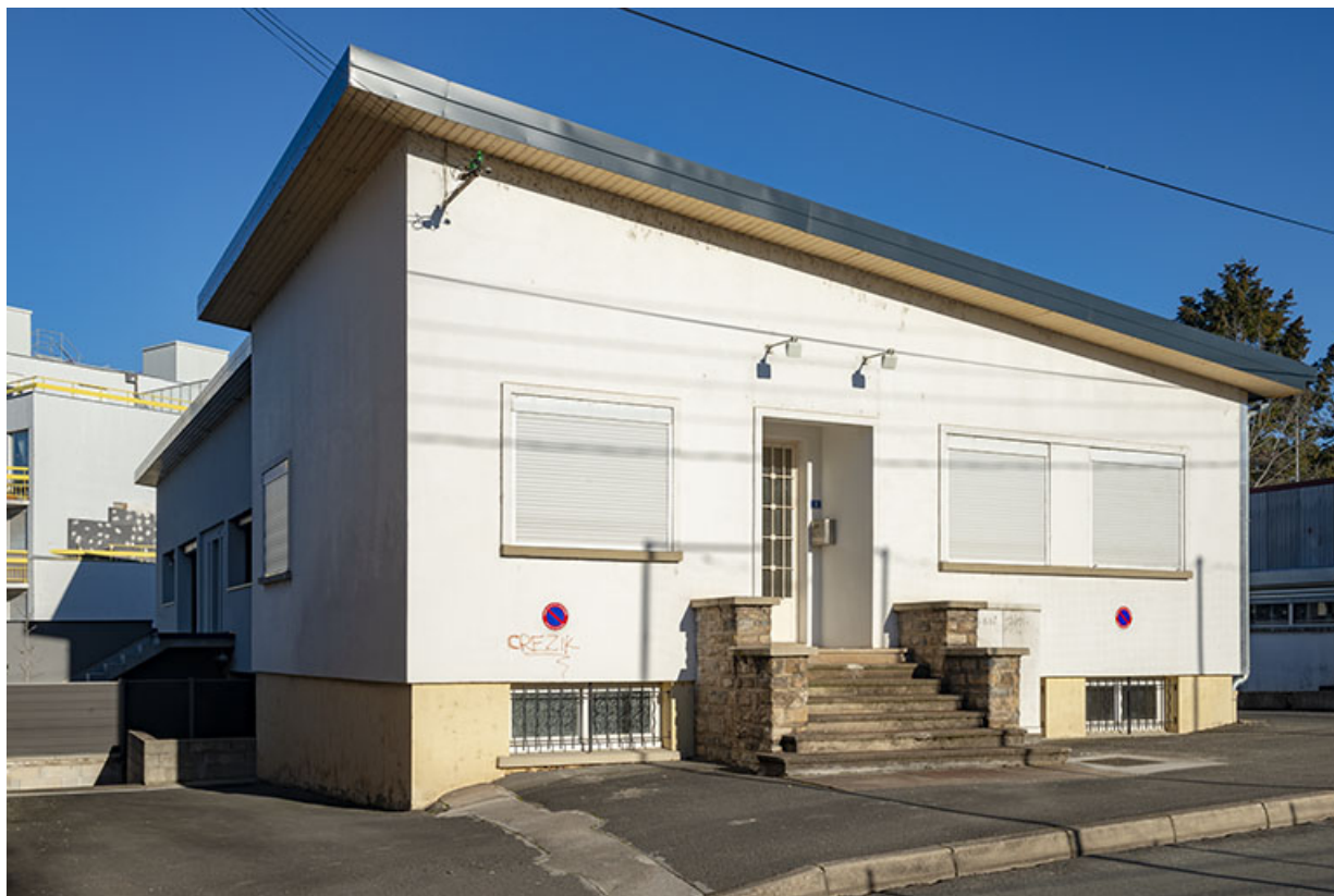
Façade antérieure (bureau) vue de trois quarts gauche.
