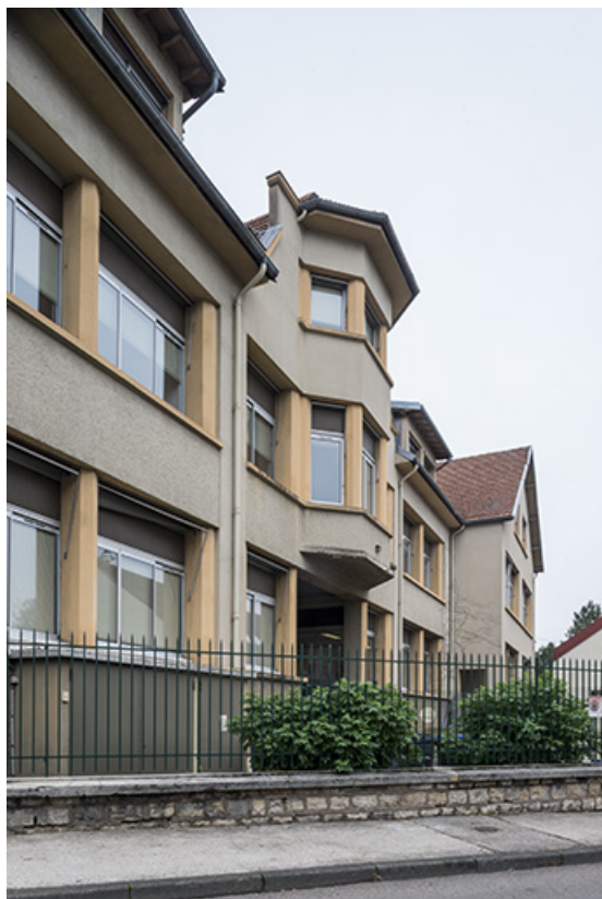
Façade antérieure vue de trois quarts gauche. 25, Besançon, 48 avenue Georges Clemenceau
