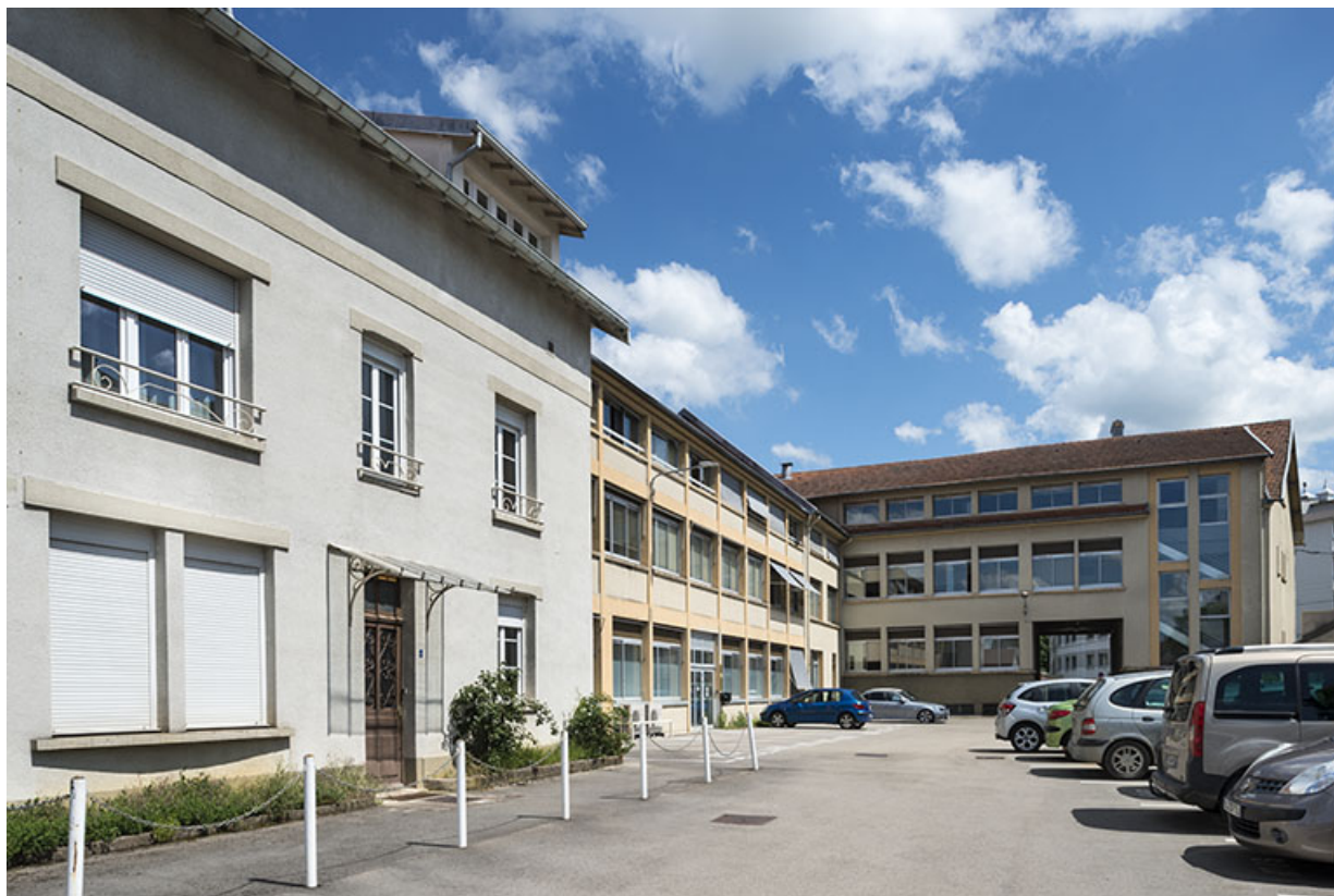
Vue d'ensemble depuis le nord-ouest de la cour.
