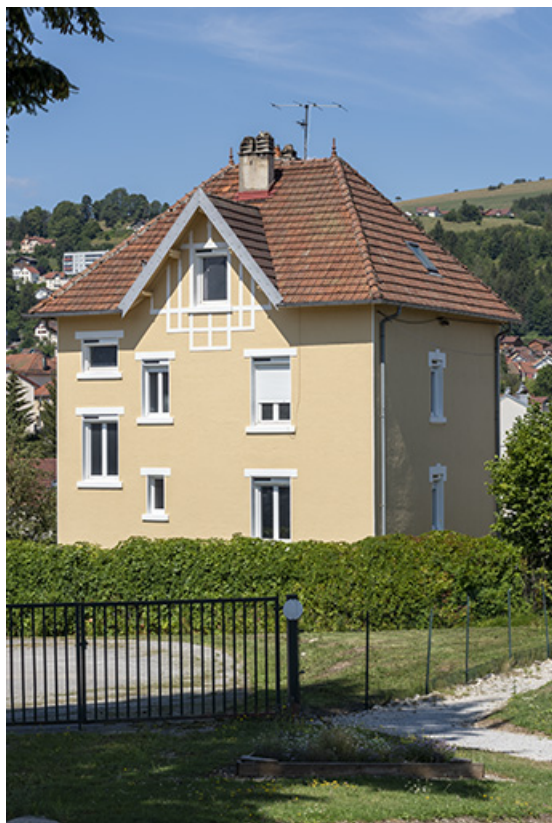
Façades postérieure et latérale gauche.
