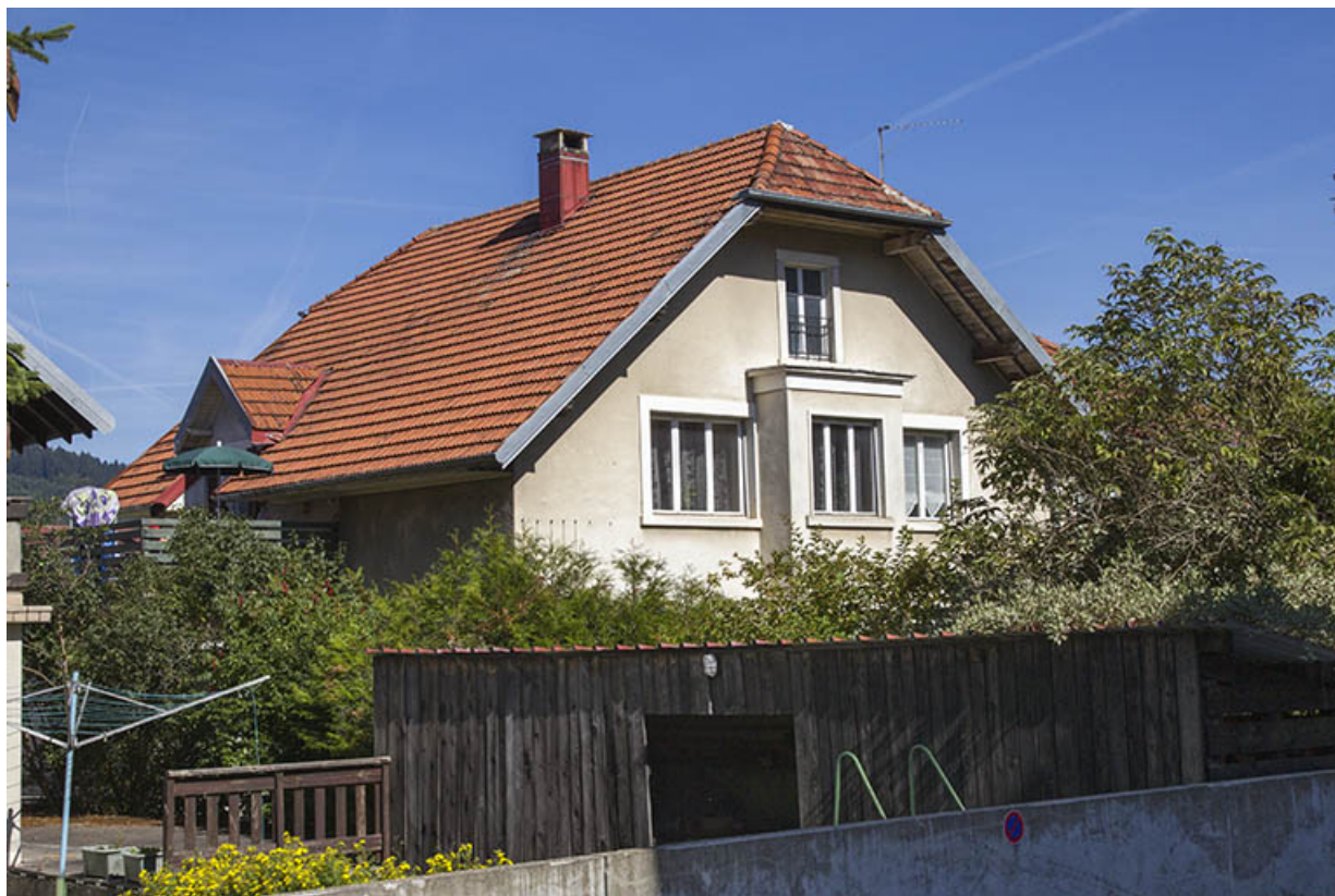
Maison : façade postérieure, de trois quarts gauche.
