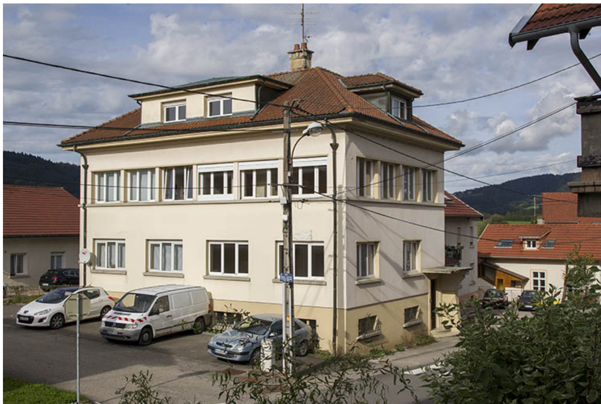
Usine : façades antérieure et latérale gauche. 25, Morteau, 15 rue Victor Hugo
