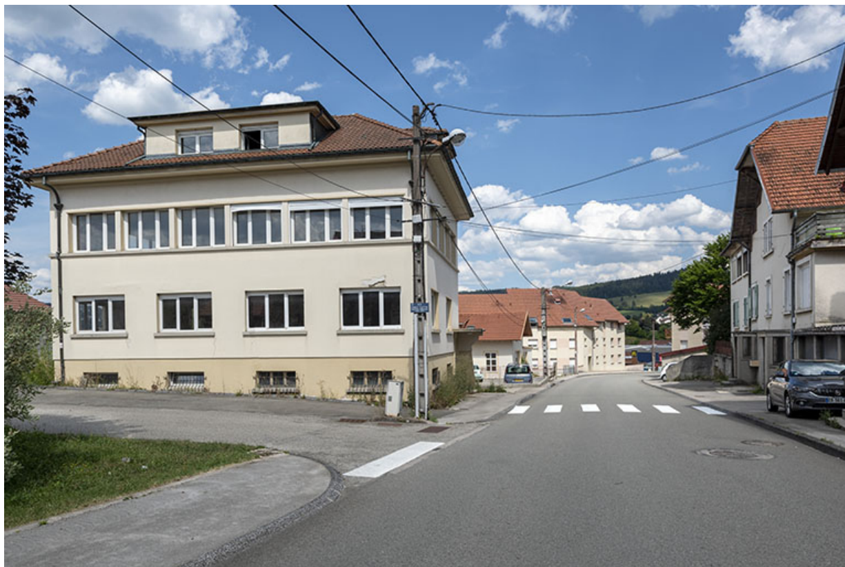
Maison et usine d'horlogerie Fernand Girardet et Fils, 15 rue Victor Hugo. 25, Morteau
