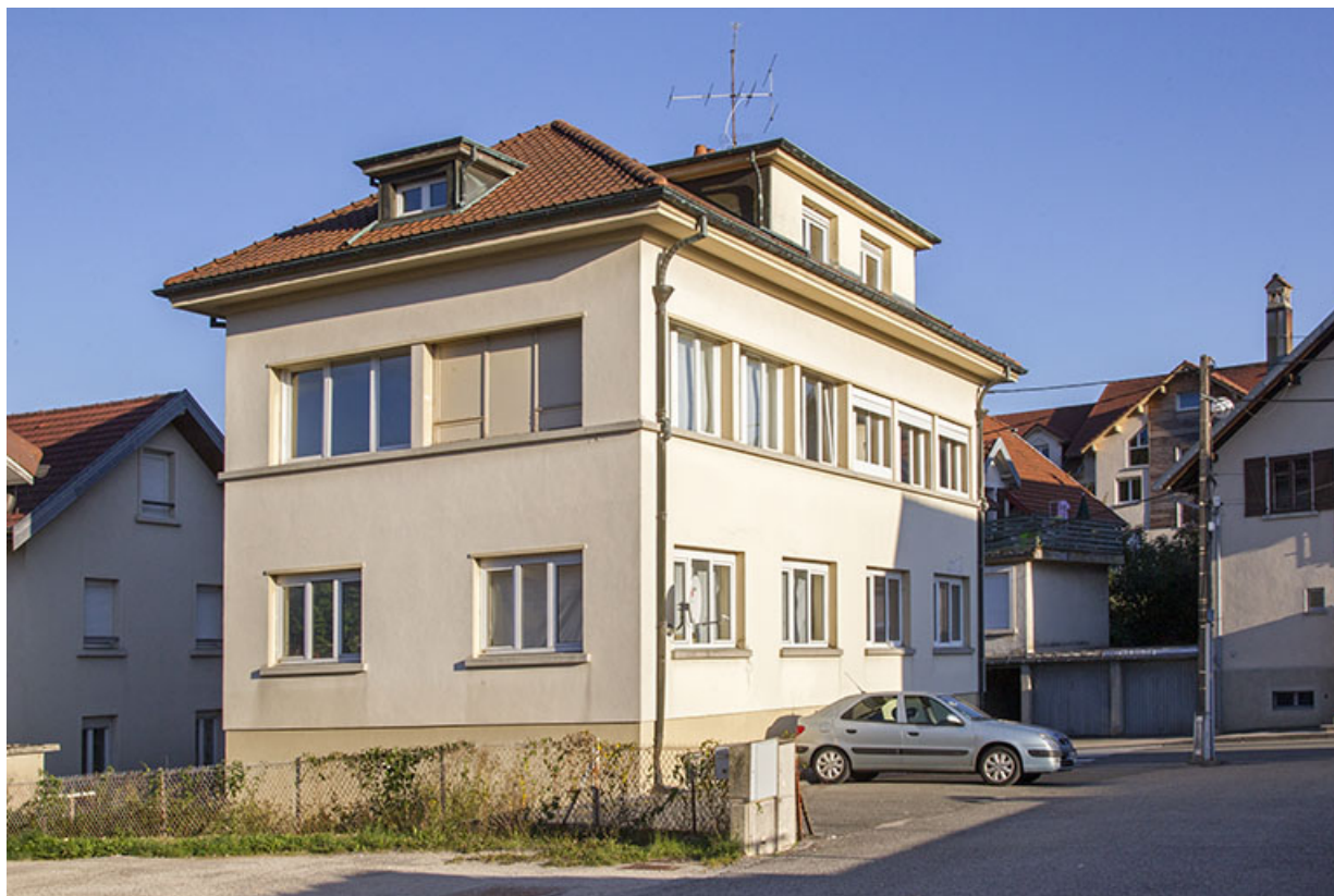
Usine : façades postérieure et latérale gauche.
