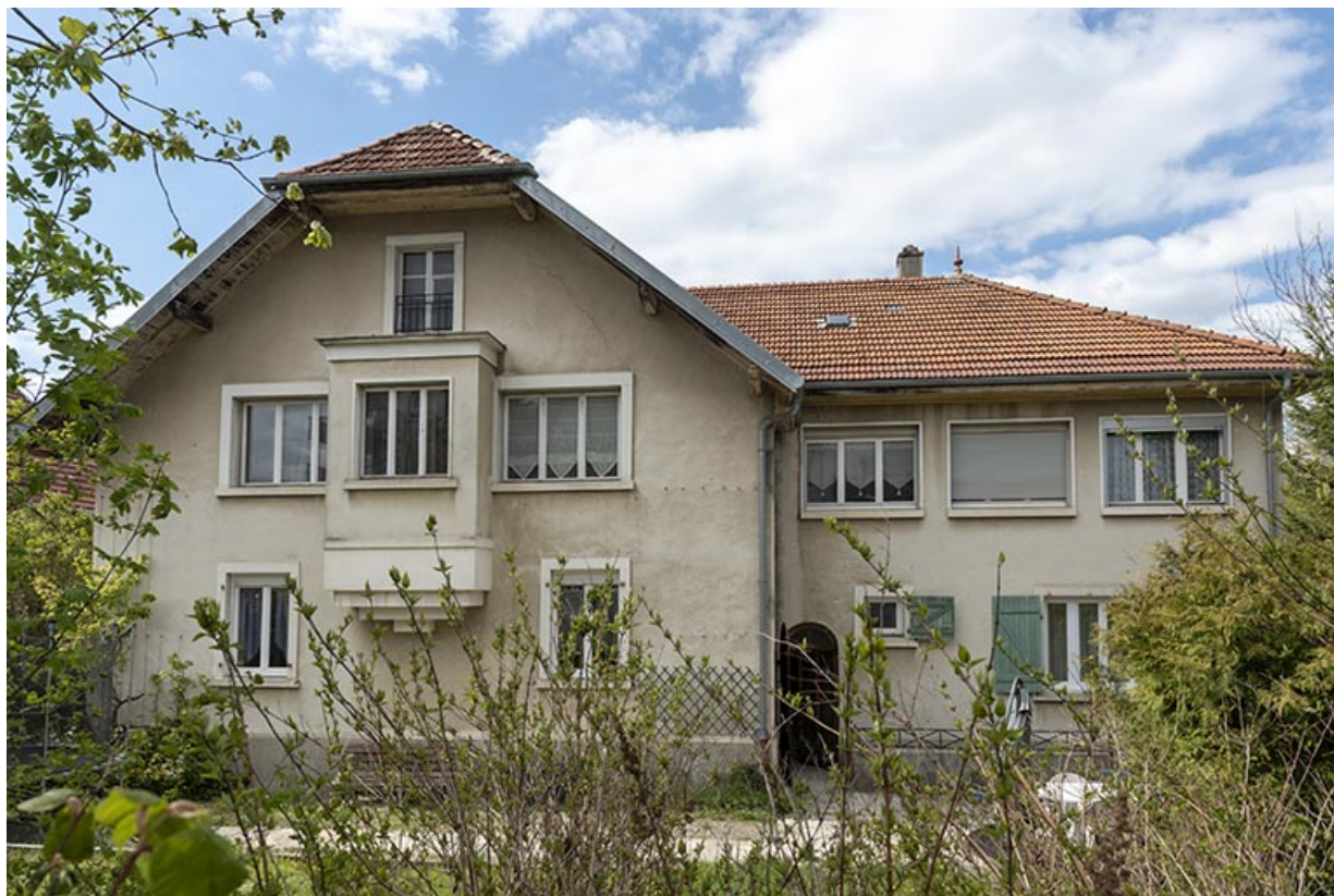
Maison et atelier de fabrication : façade postérieure.
