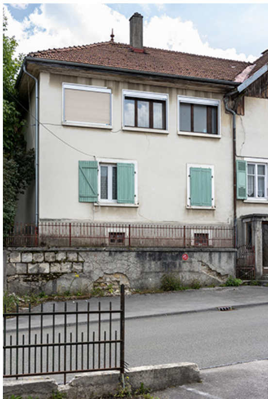
Maison : atelier de fabrication dans l'extension.
