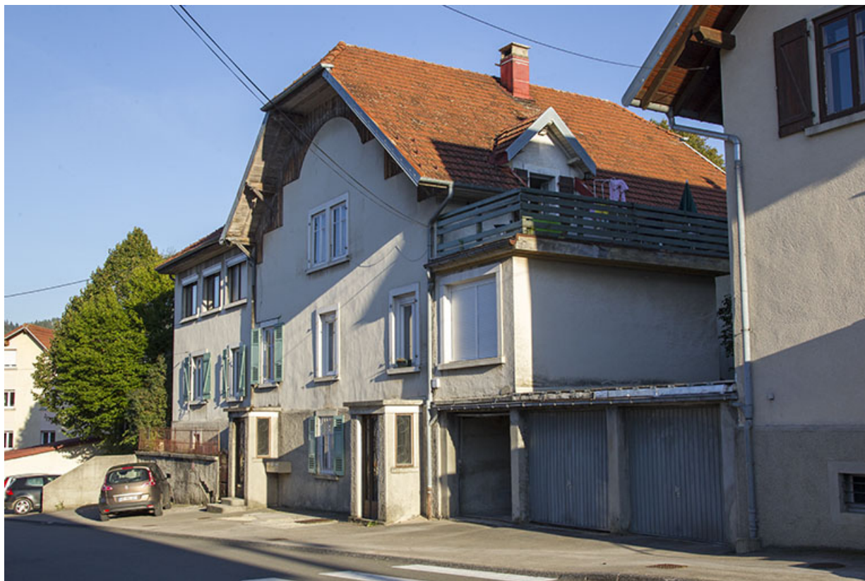
Maison : façade antérieure, vue en enfilade. 25, Morteau, 15 rue Victor Hugo
