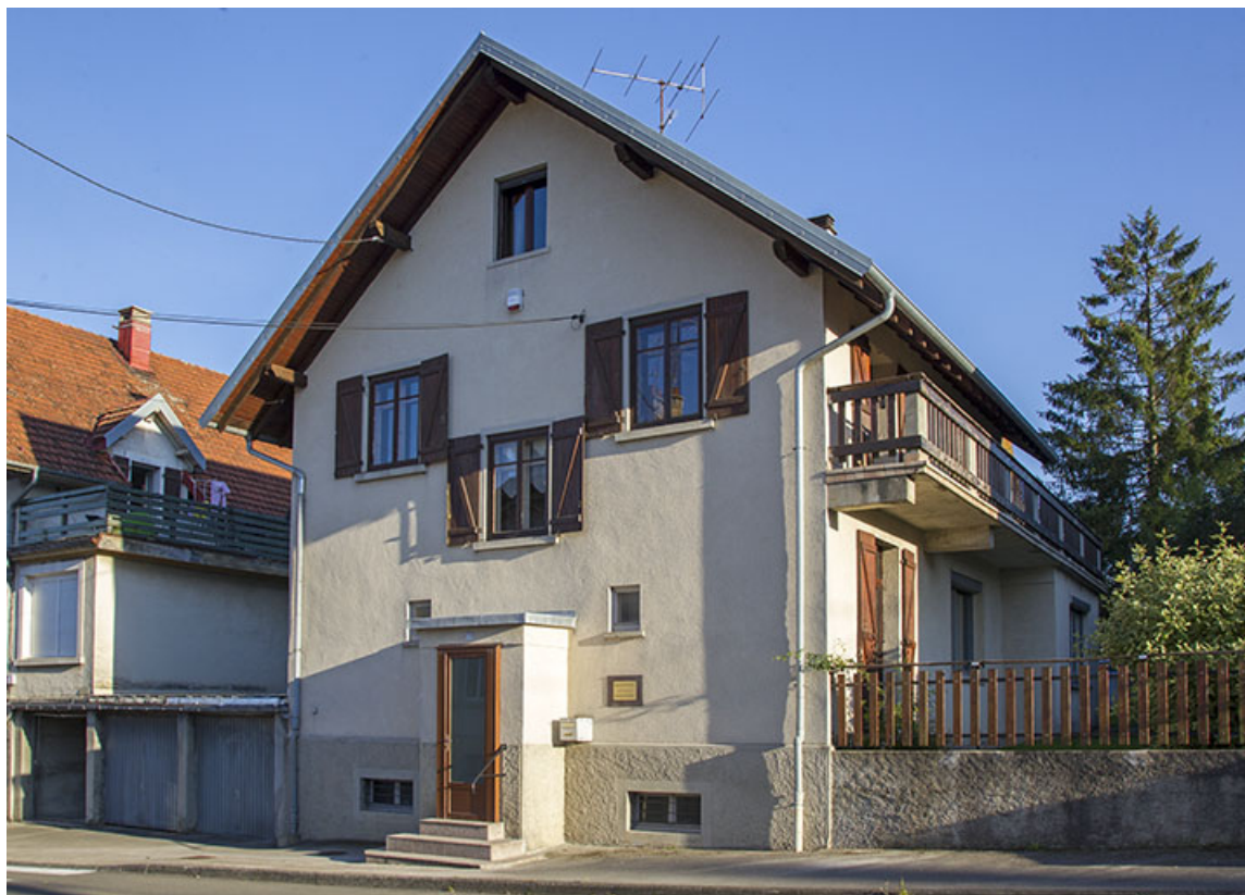
Façades antérieure et latérale droite.
