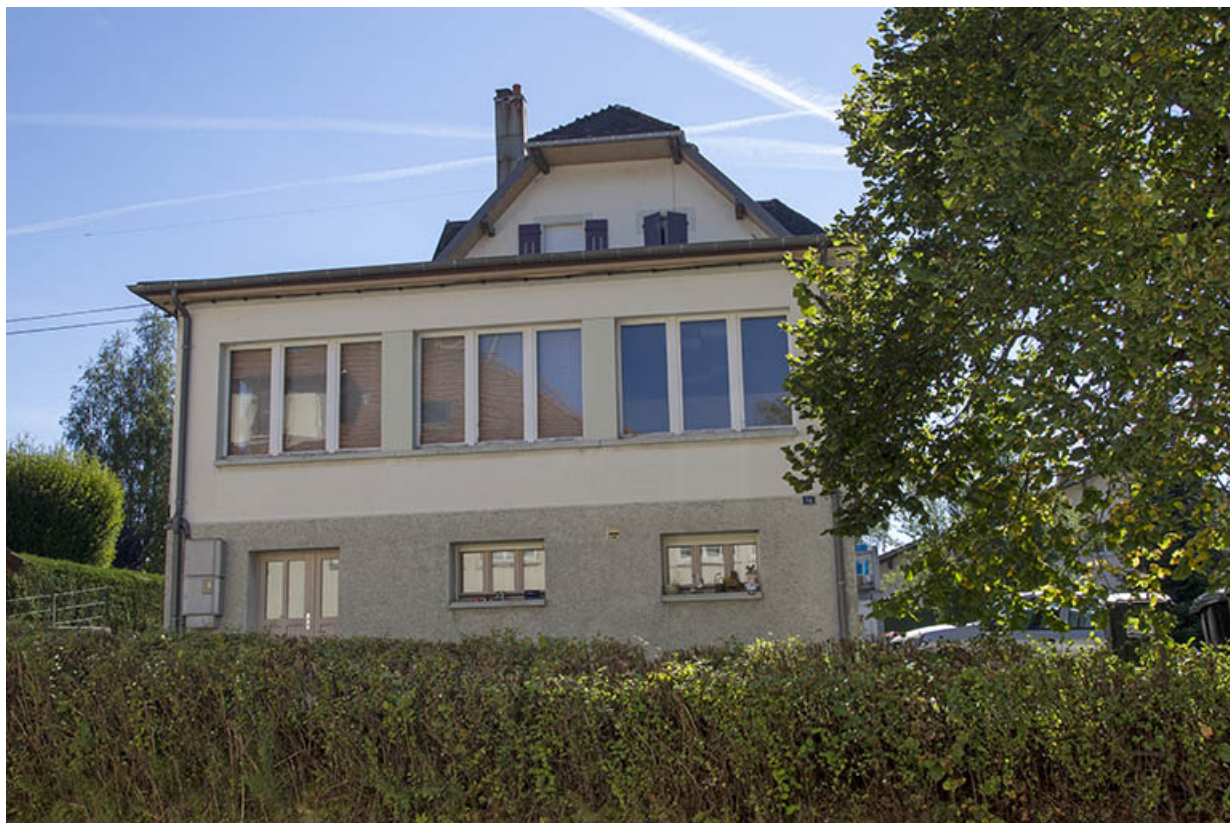
Uisne : façade latérale gauche.
