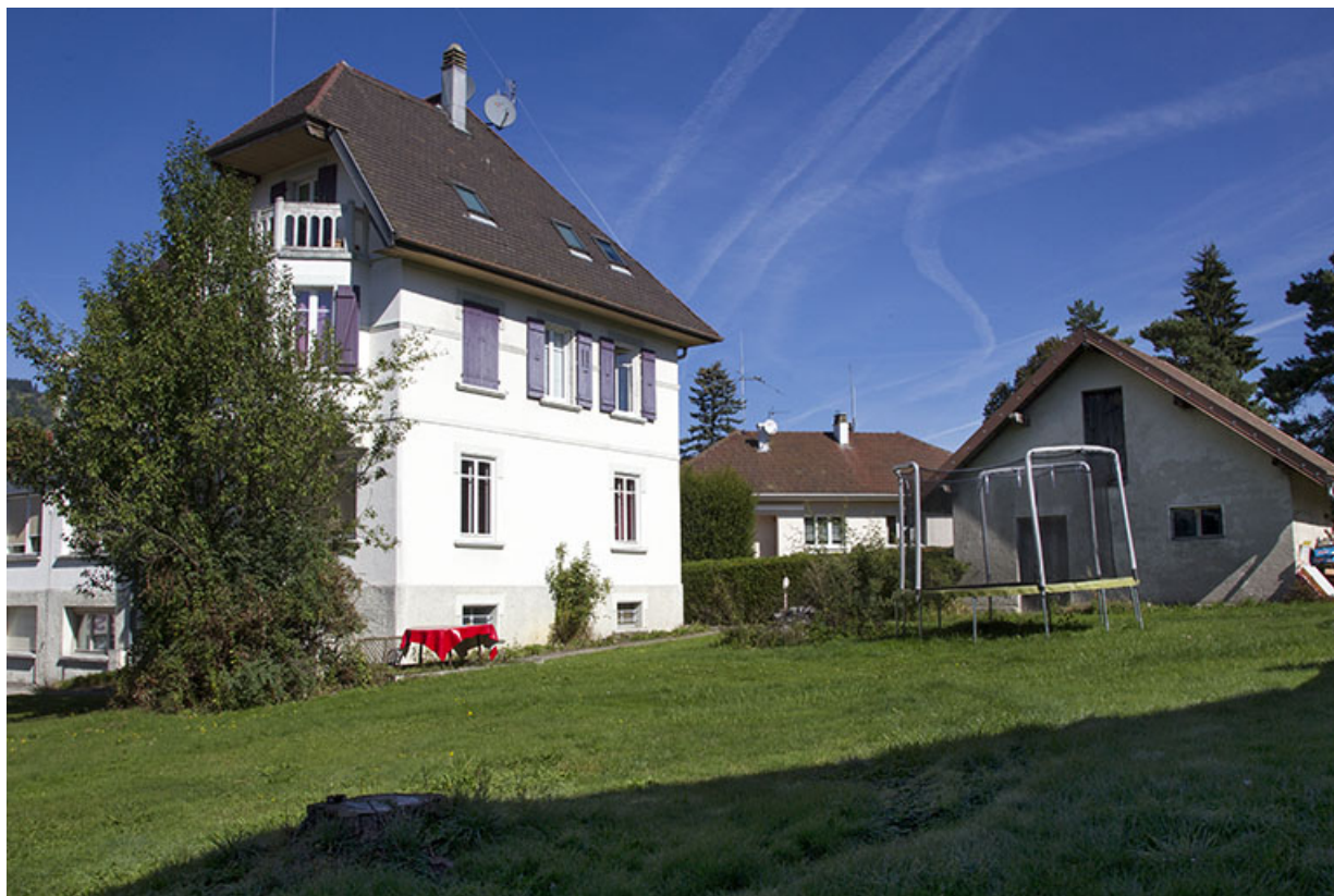
Maison (façade latérale droite) et garage.
