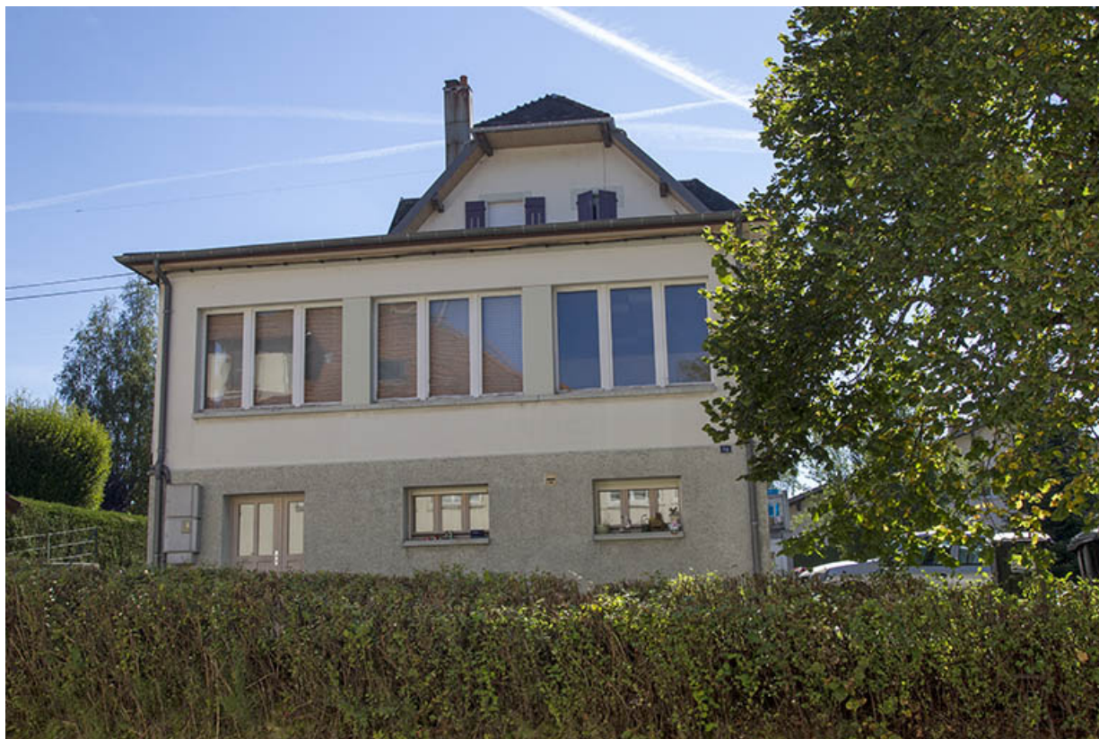
Uisne : façade latérale gauche.
