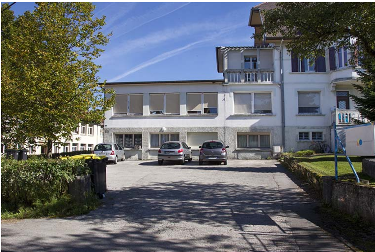
Usine : façade antérieure.
