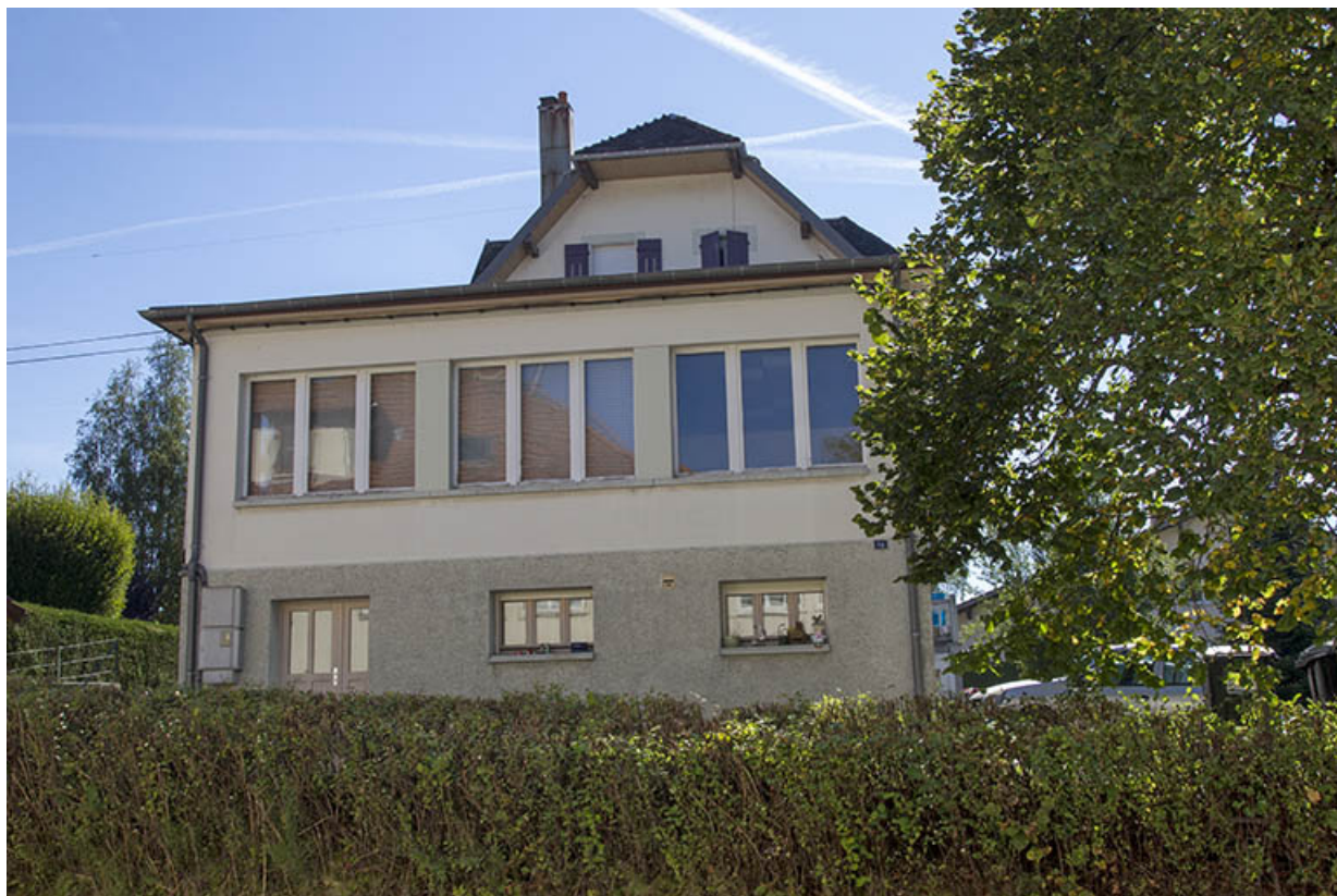
Uisne : façade latérale gauche.
