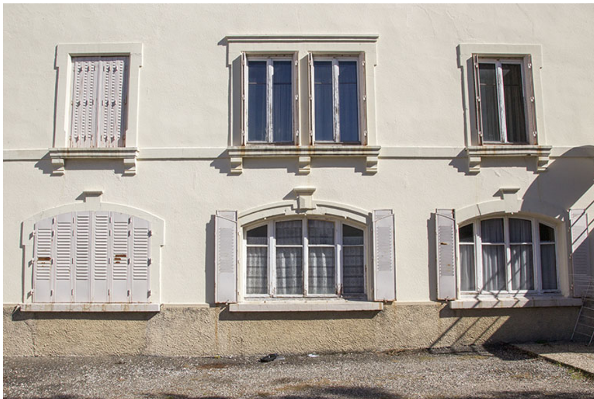
Façade antérieure : fenêtres du rez-de-chaussée et du premier étage.
