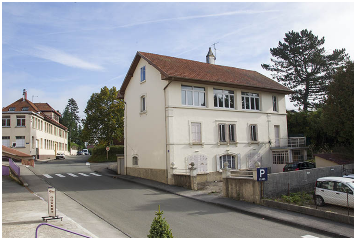
Façades antérieure et latérale gauche. 25, Morteau, 12 rue Victor Hugo
