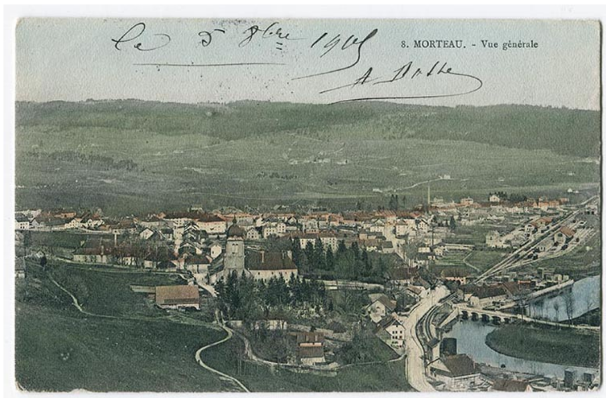
8. Morteau. - Vue générale [depuis la Table du Roi, à l'ouest], 4e quart 19e siècle [après 1895].
