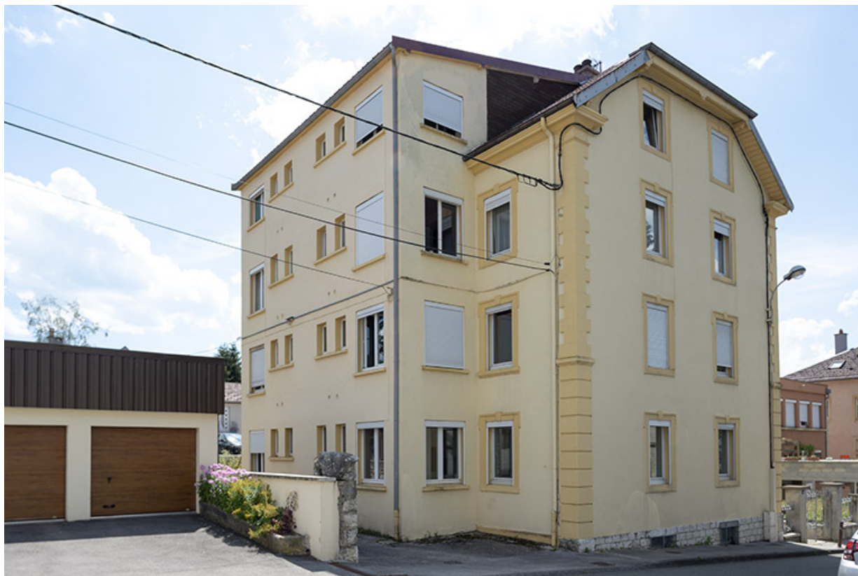
Façades postérieure et latérale gauche.
