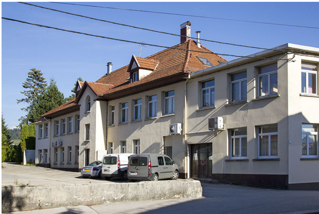
Usine : façade postérieure, de trois quarts droite. 25, Morteau, 5 rue Victor Hugo
