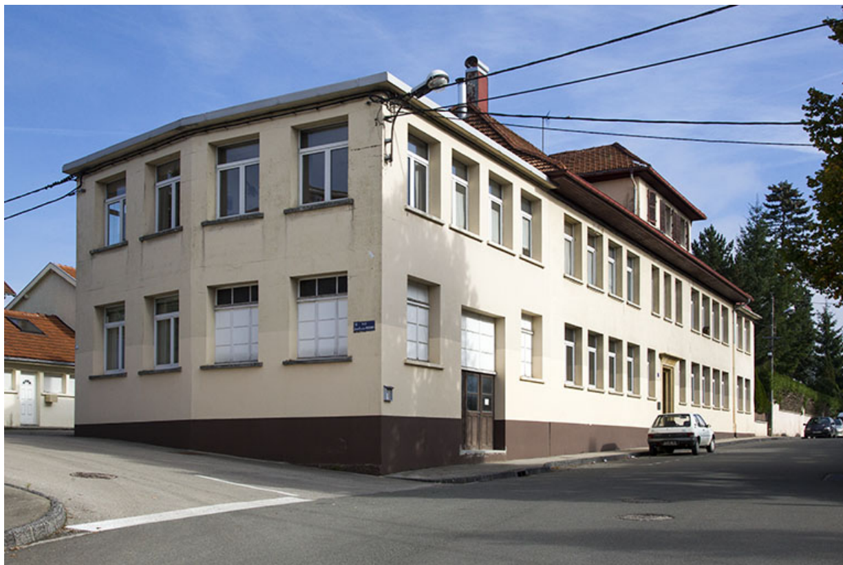
Usine : façade antérieure, de trois quarts gauche.
