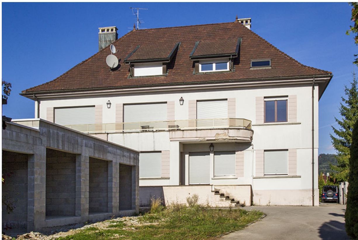
Maison : façade côté usine.
