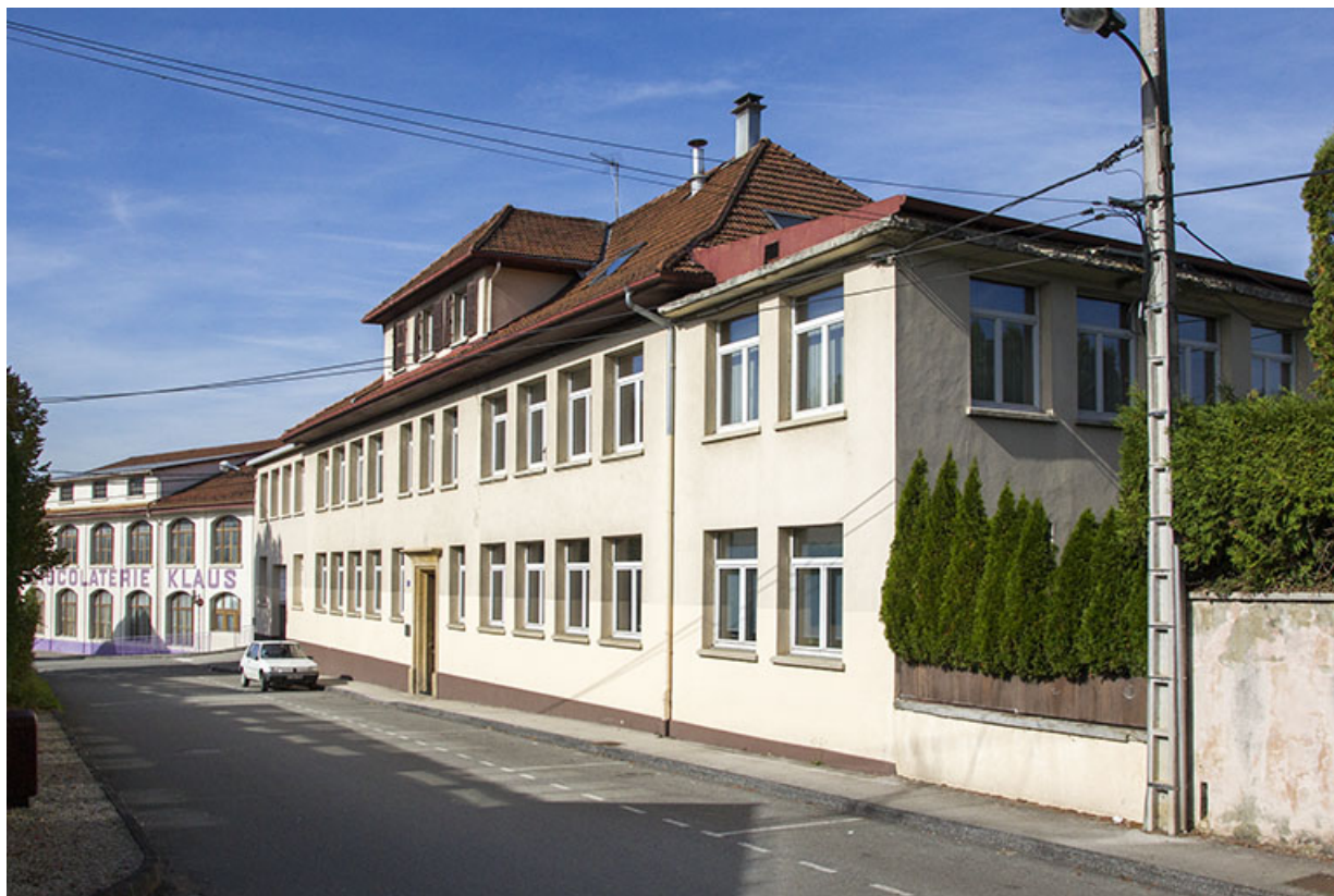
Usine : façade antérieure, de trois quarts droite. 25, Morteau
