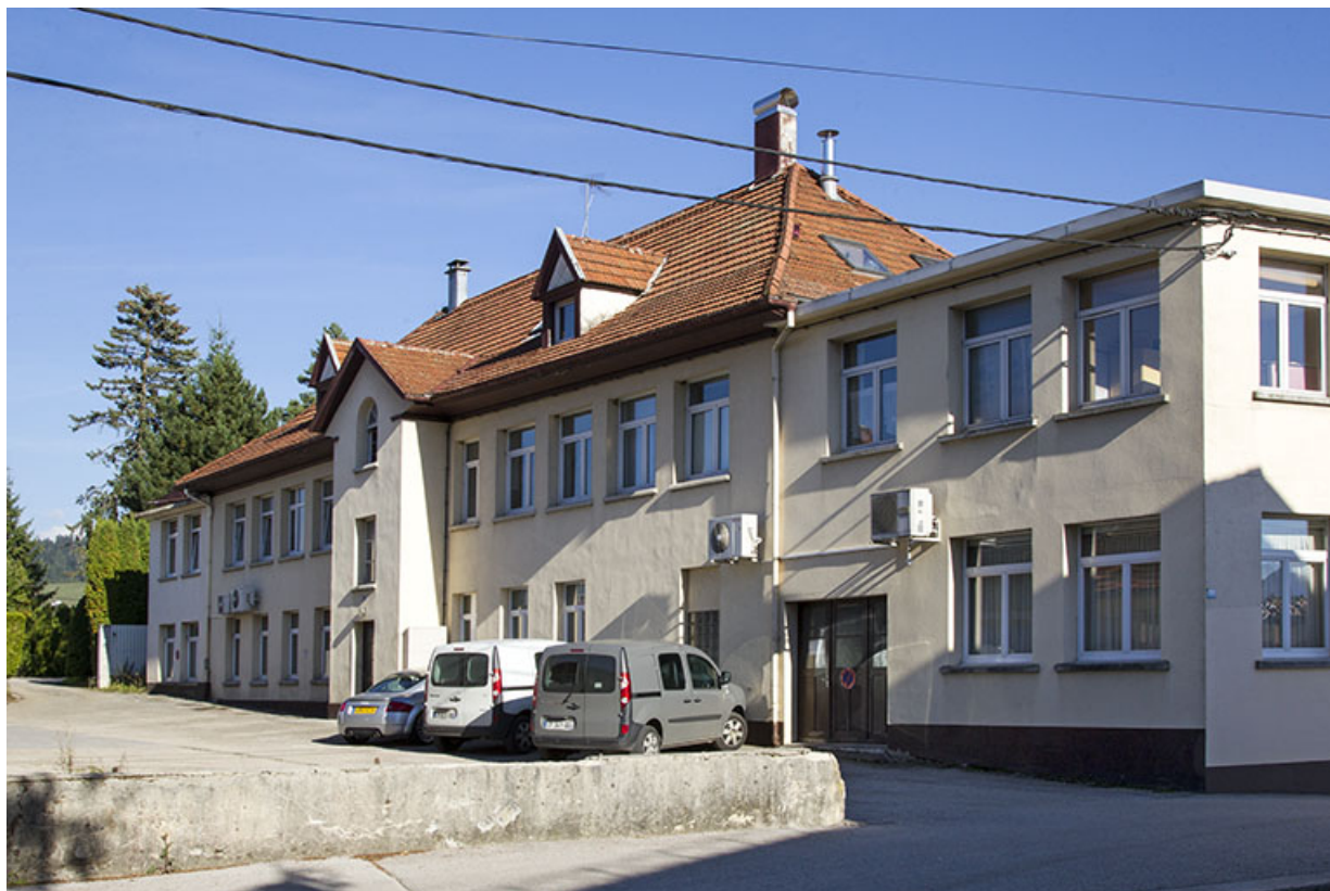
Usine : façade postérieure, de trois quarts droite.
