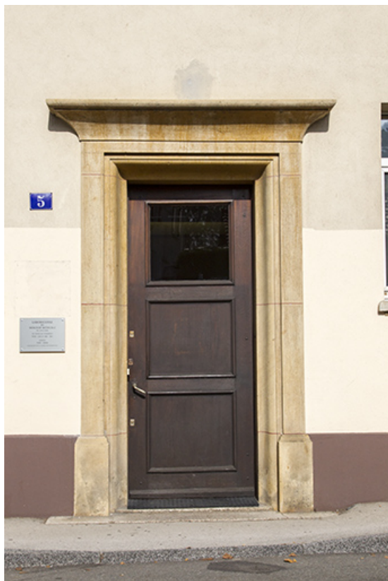
Usine : façade antérieure, porte principale. 25, Morteau, 5 rue Victor Hugo
