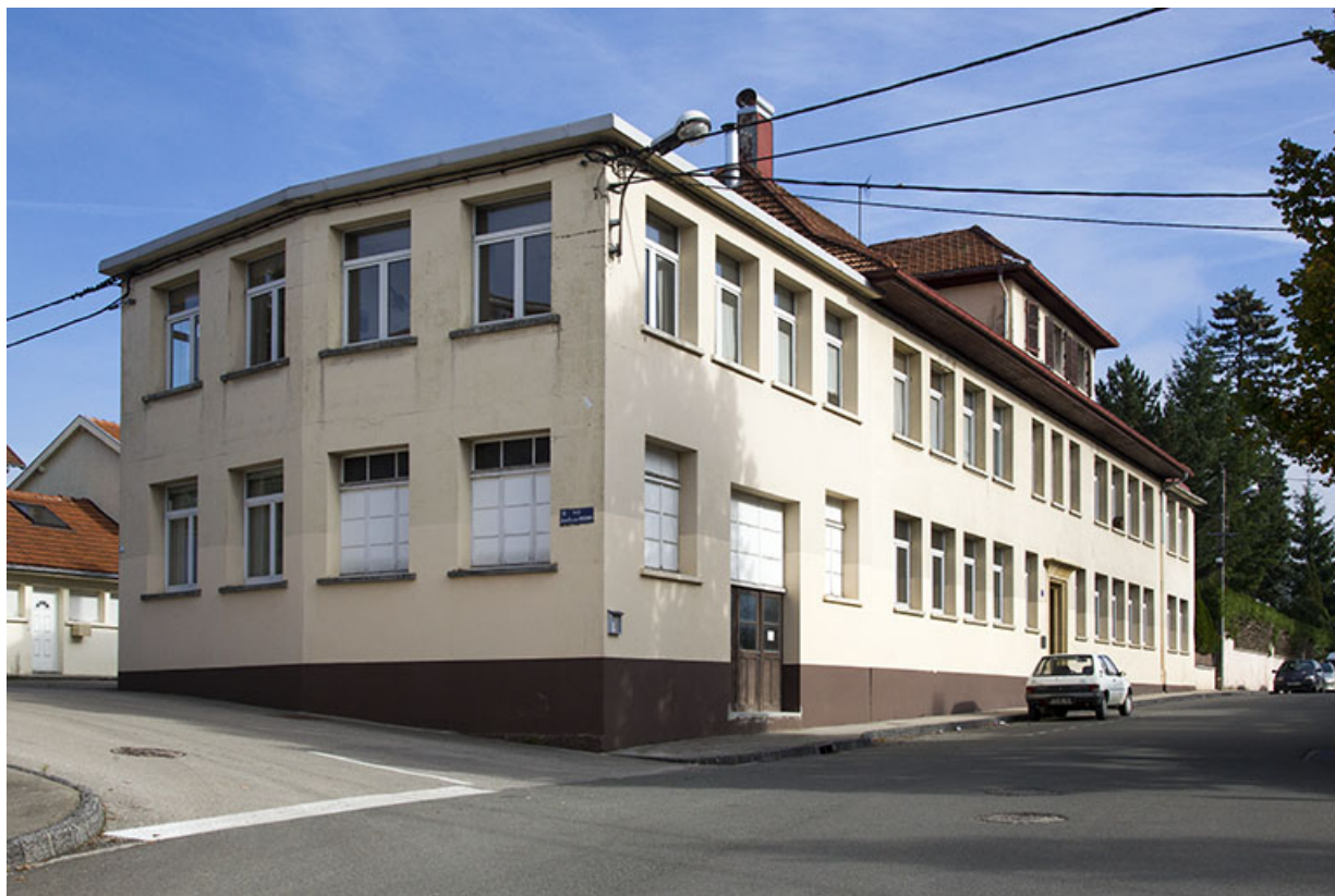
Usine : façade antérieure, de trois quarts gauche.
