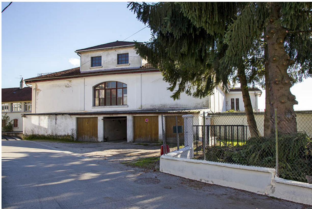
Bâtiment nord : façade latérale droite.
