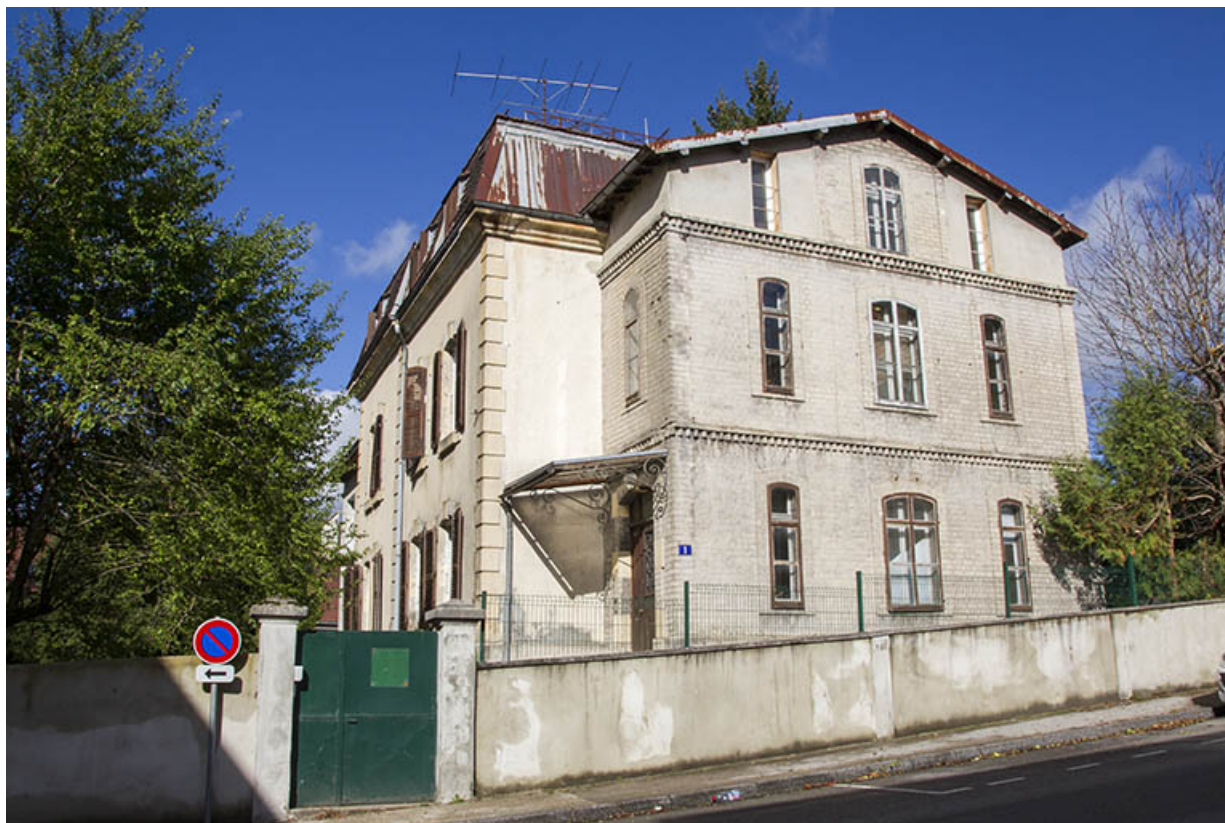
Logement patronal, de trois quarts depuis le sud-est.
