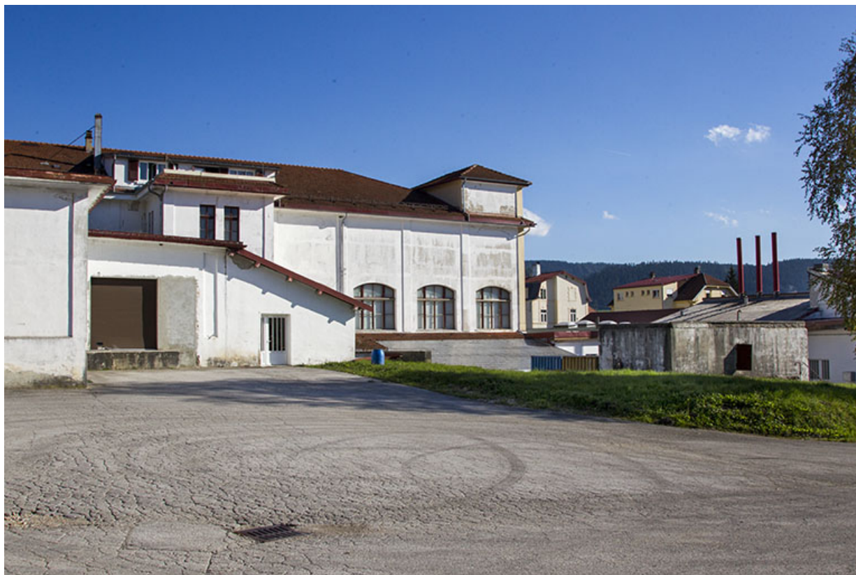
Bâtiments nord et sud : jonction vue depuis le nord.
