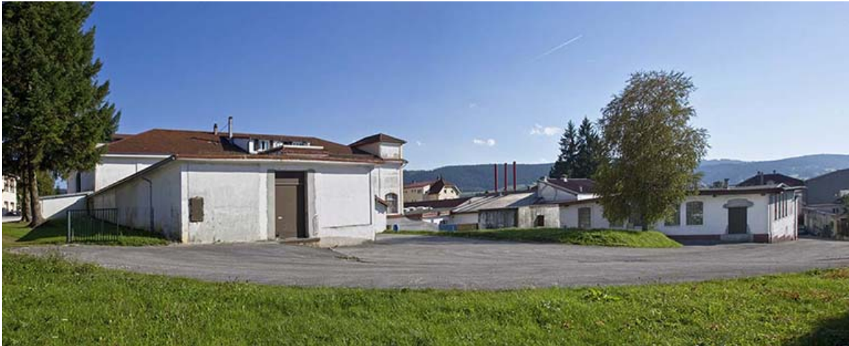
Bâtiments nord et sud : façade postérieure, depuis le nord.
