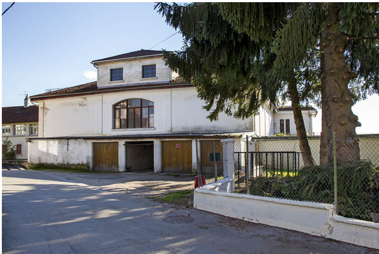
Bâtiment nord : façade latérale droite.
