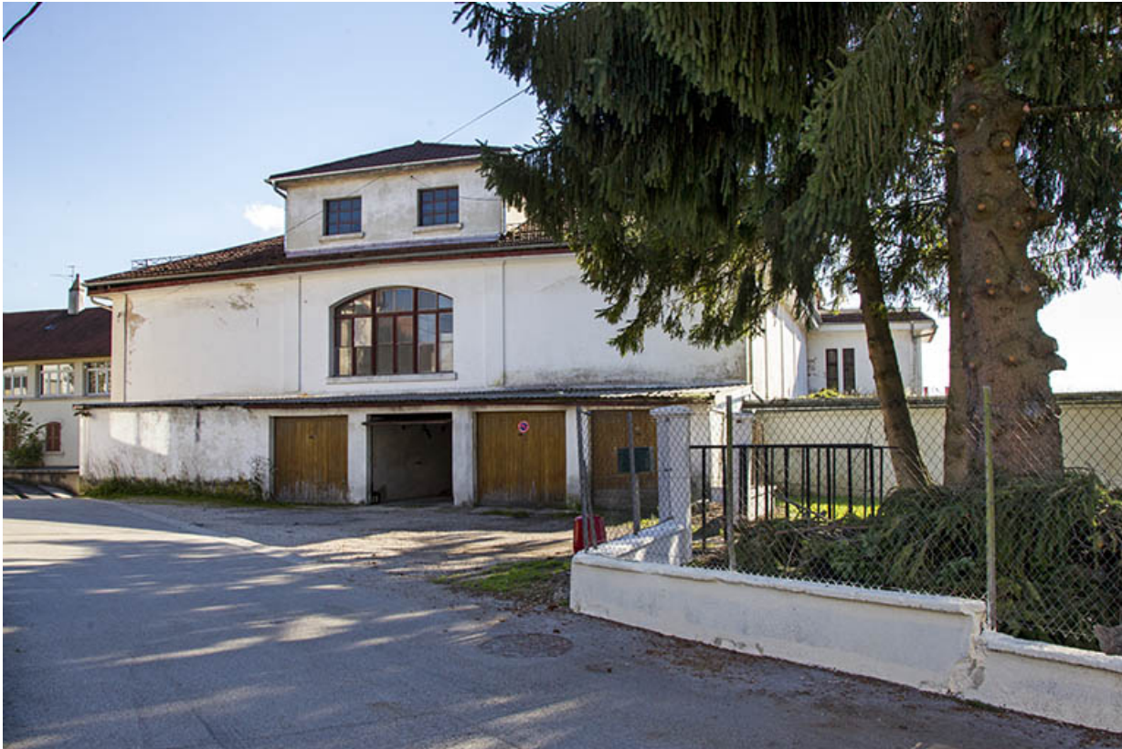
Bâtiment nord : façade latérale droite.
