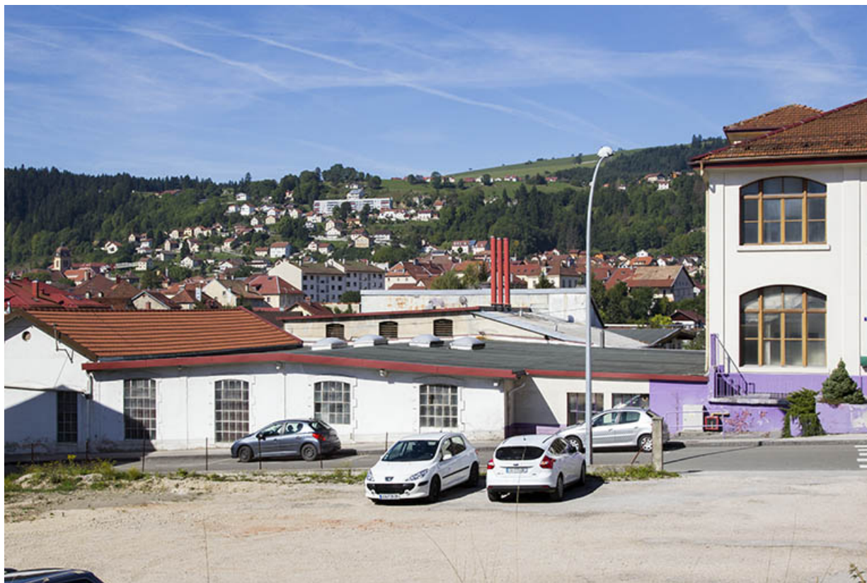
Bâtiments sud : façade antérieure, de trois quarts droite. 25, Morteau, 3 rue Victor Hugo
