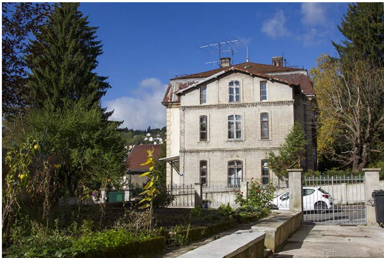
Logement patronal, vu de l'est.
