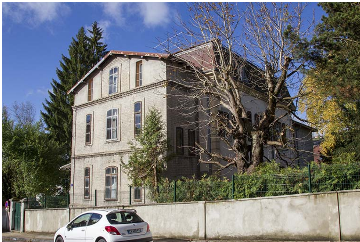
Logement patronal, de trois quarts depuis le nord-est. 25, Morteau, 3 rue Victor Hugo
