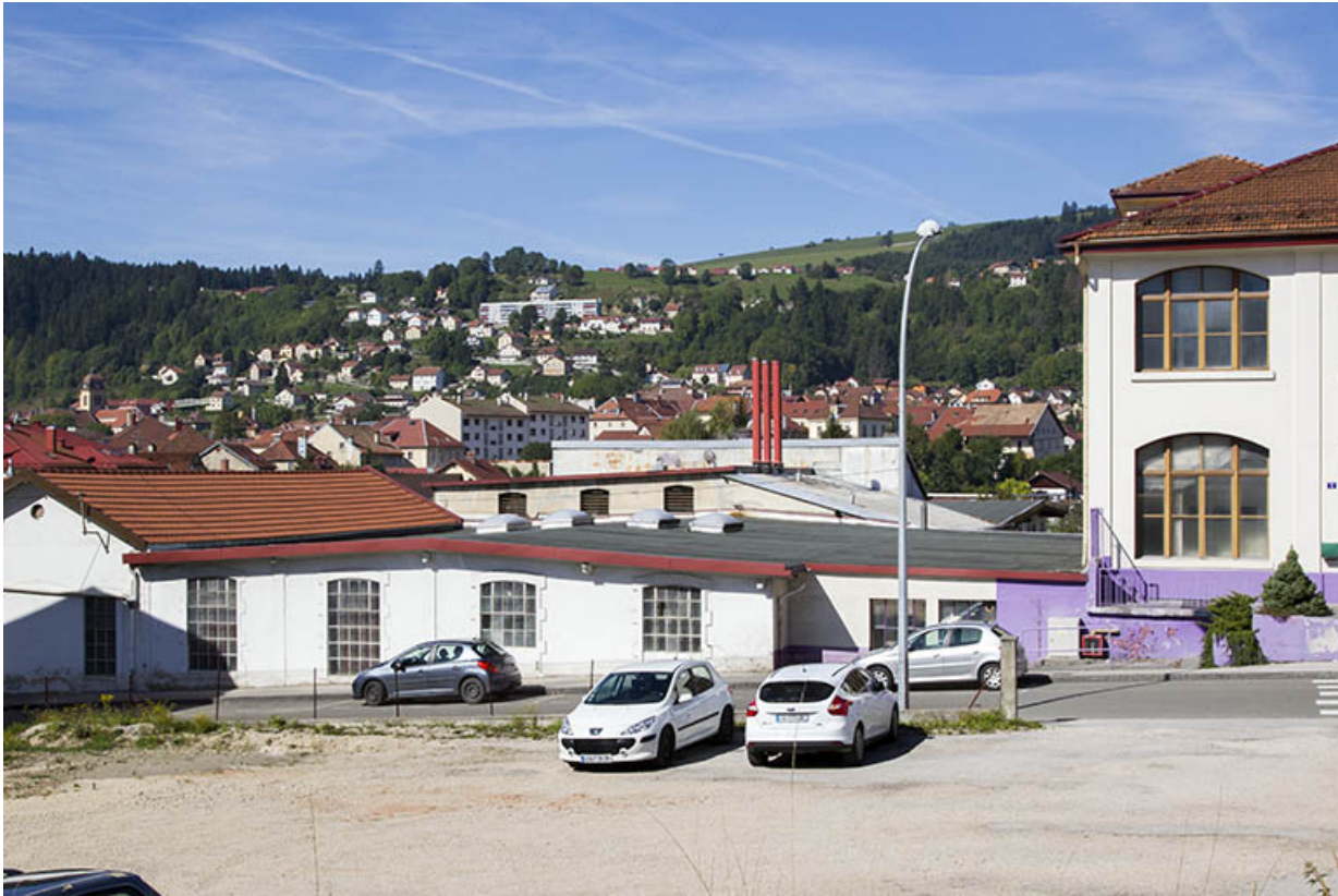
Bâtiments sud : façade antérieure, de trois quarts droite. 25, Morteau, 3 rue Victor Hugo
