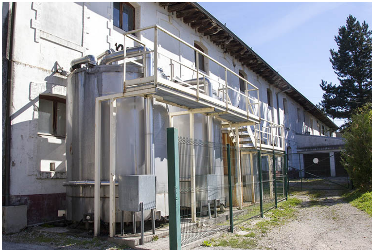
Bâtiments sud : façade latérale gauche, vue en enfilade. 25, Morteau, 3 rue Victor Hugo
