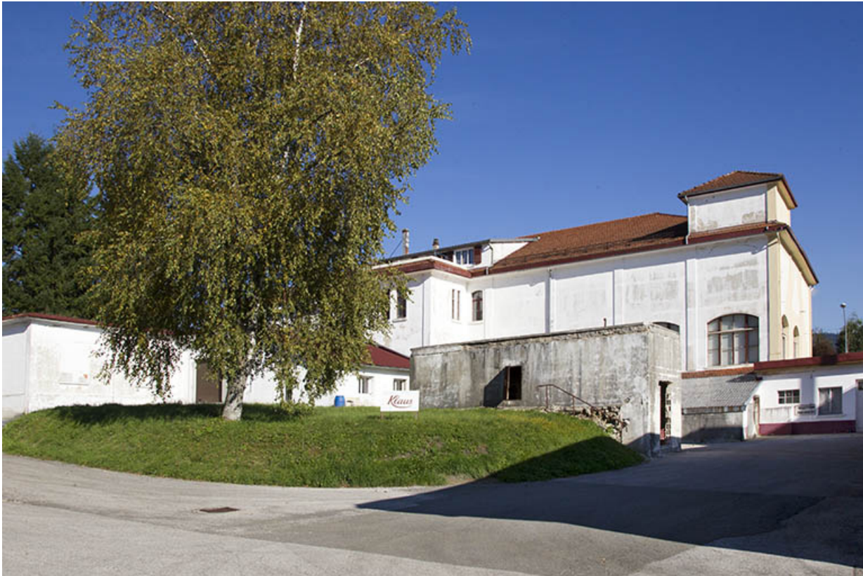
Bâtiments nord : façade postérieure, de trois quarts droite.
