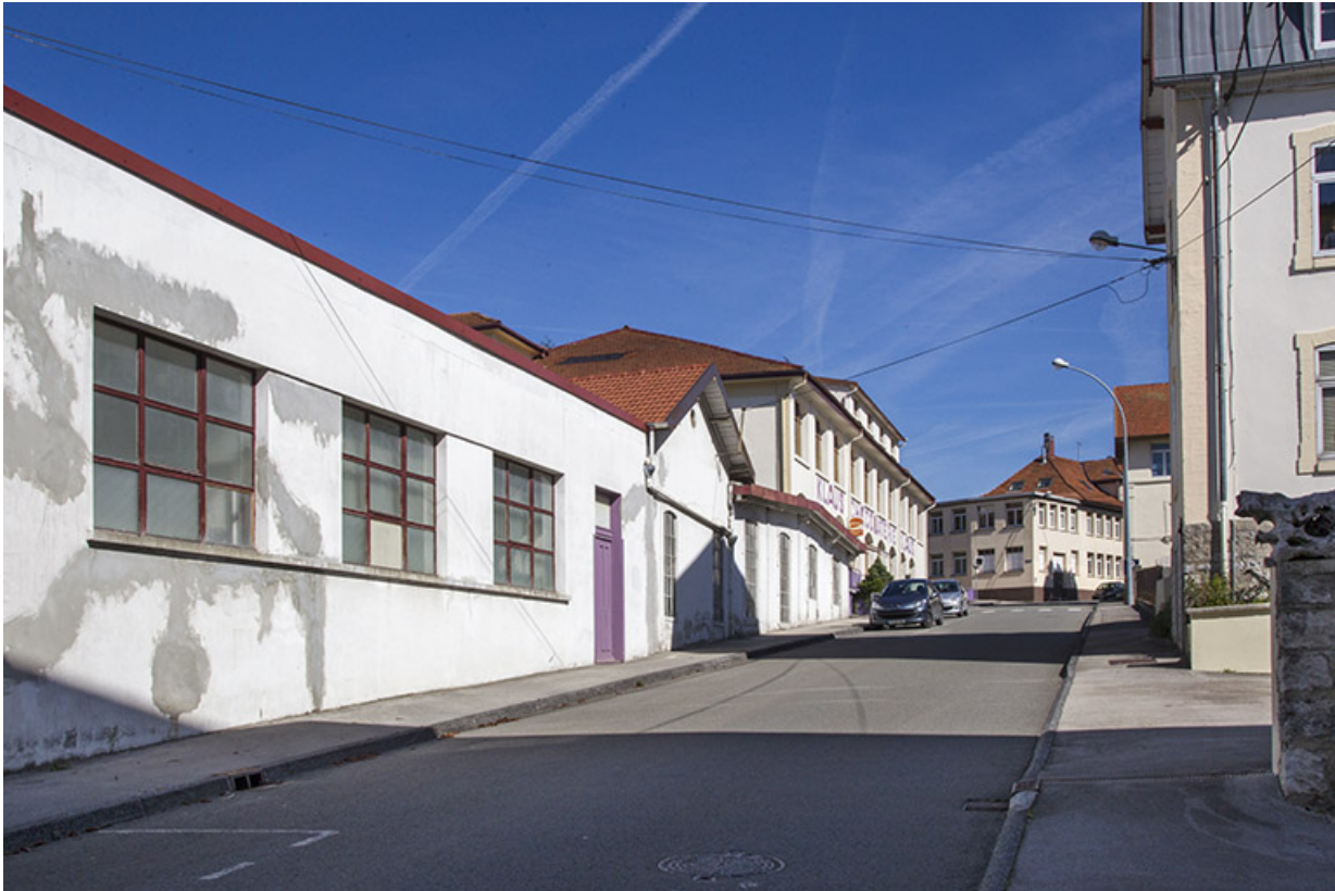
Bâtiments sud : façade antérieure, de trois quarts gauche. 25, Morteau, 3 rue Victor Hugo
