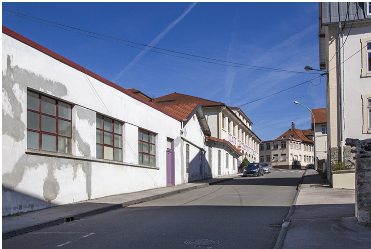
Bâtiments sud : façade antérieure, de trois quarts gauche.
