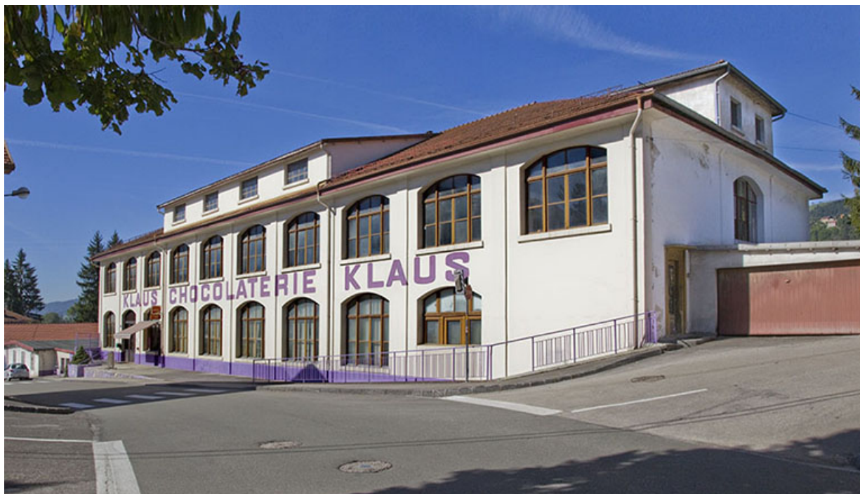
Bâtiment nord : façade antérieure, de trois quarts droite.
