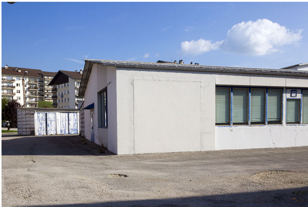
Bâtiment en rez-de-chaussée : extrémité occidentale.
