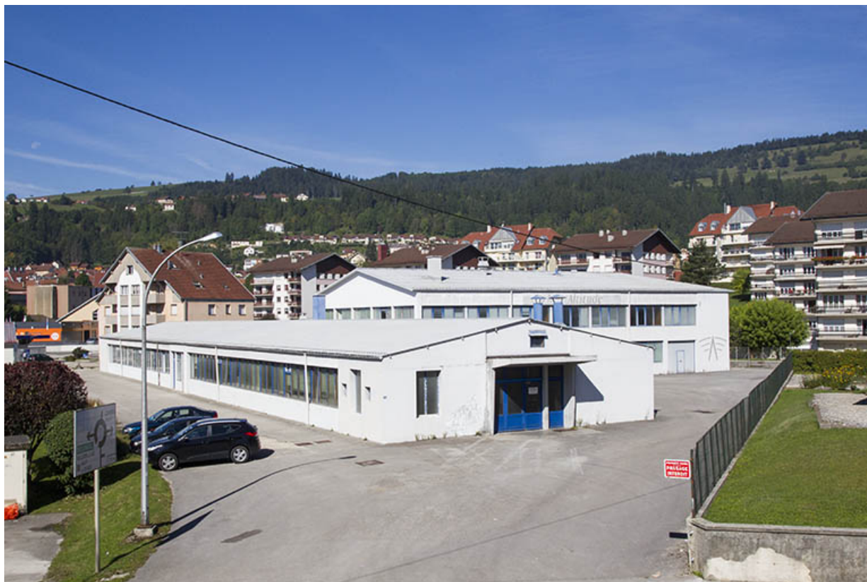
Vue d'ensemble, depuis l'avenue Charles de Gaulle à l'est. 25, Morteau, 9 rue du Clos jeune
