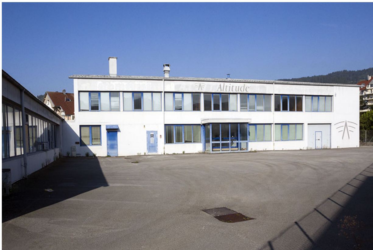
Bâtiment à étage : façade orientale.
