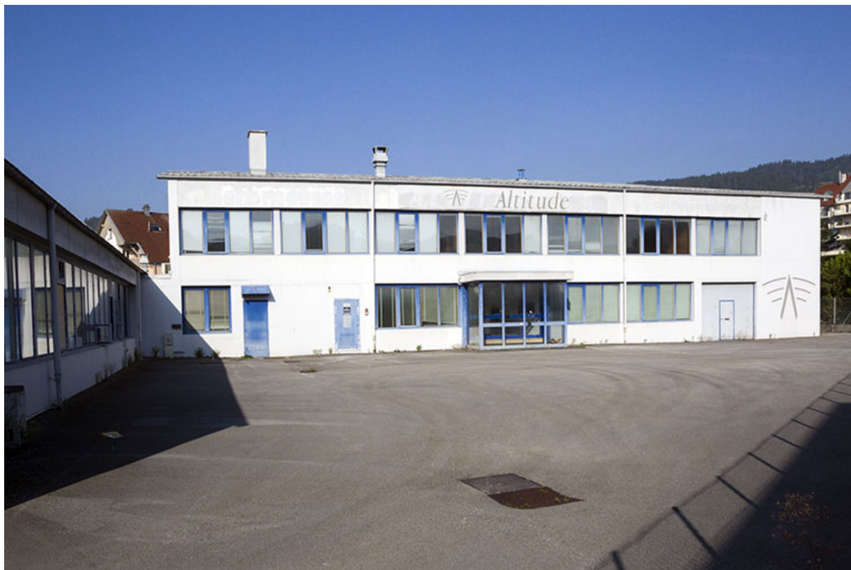
Bâtiment à étage : façade orientale.
