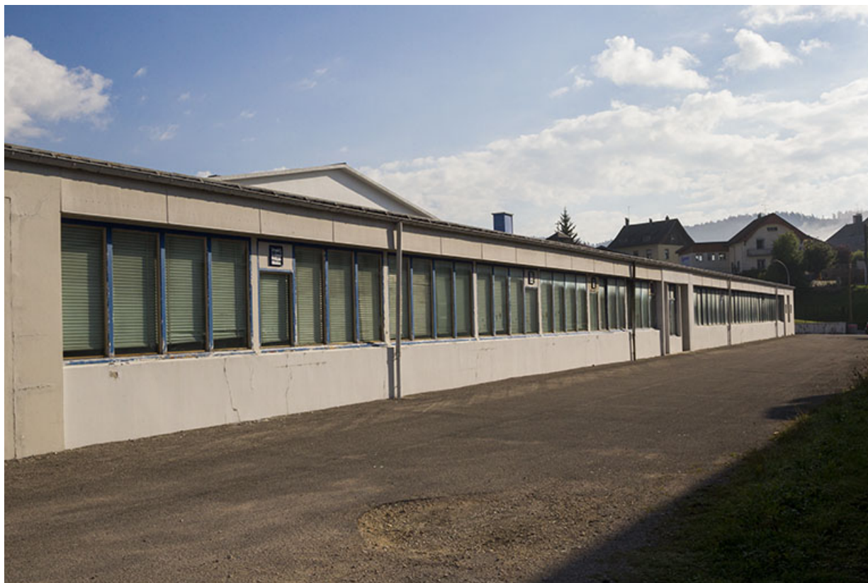
Bâtiment en rez-de-chaussée : façade méridionale.
