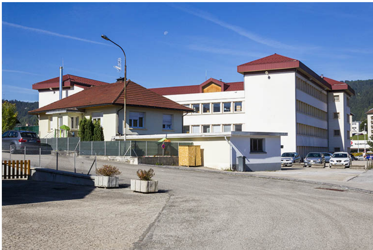
Vue d'ensemble, depuis la rue Emile Cattin au sud-est (maison et arrière de l'usine). 25, Morteau, 8 avenue Charles de Gaulle
