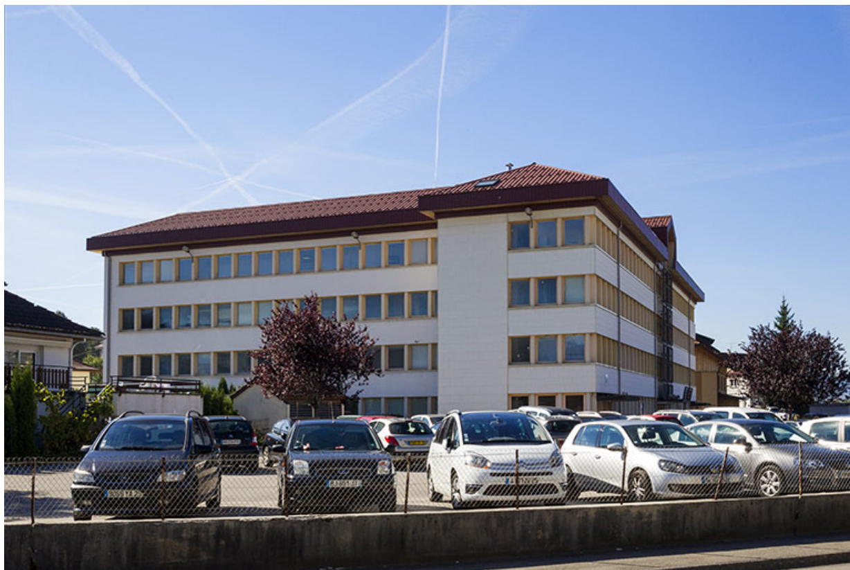
Usine : façade latérale gauche, de trois quarts. 25, Morteau, 8 avenue Charles de Gaulle
