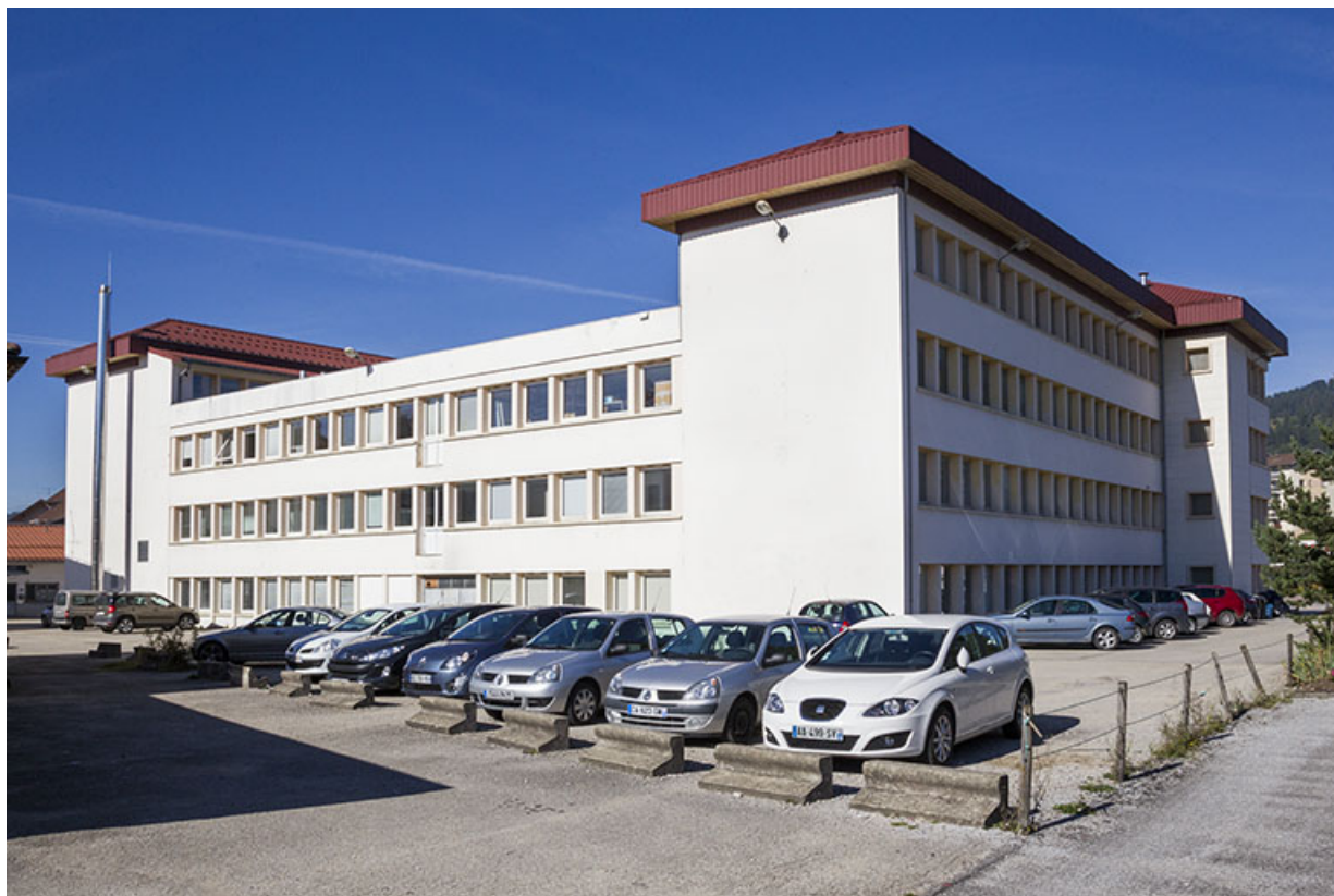
Usine : façades postérieure et latérale gauche. 25, Morteau, 8 avenue Charles de Gaulle
