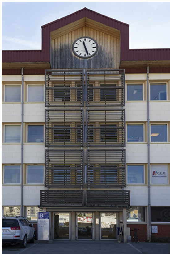
Usine : travées centrales de la façade antérieure.
