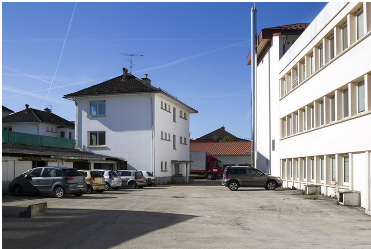
Maison au n° 3 rue Emile Cattin : façade côté usine. 25, Morteau, 8 avenue Charles de Gaulle
