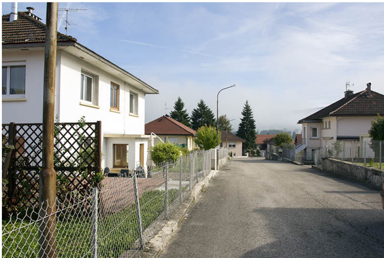
Vue d'ensemble de la rue Emile Cattin, depuis le sud-ouest (avec la maison au n° 3 au premier plan à gauche). 25, Morteau, 8 avenue Charles de Gaulle
