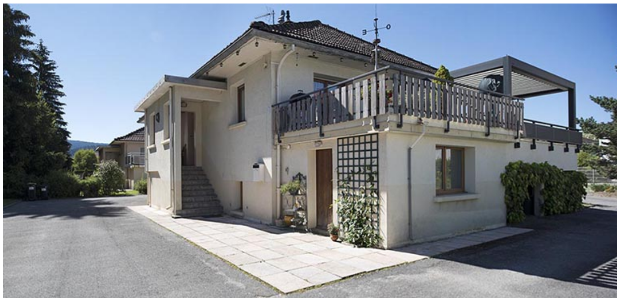
Maison au n° 9 rue Emile Cattin : façades postérieure et latérale gauche. 25, Morteau, 8 avenue Charles de Gaulle
