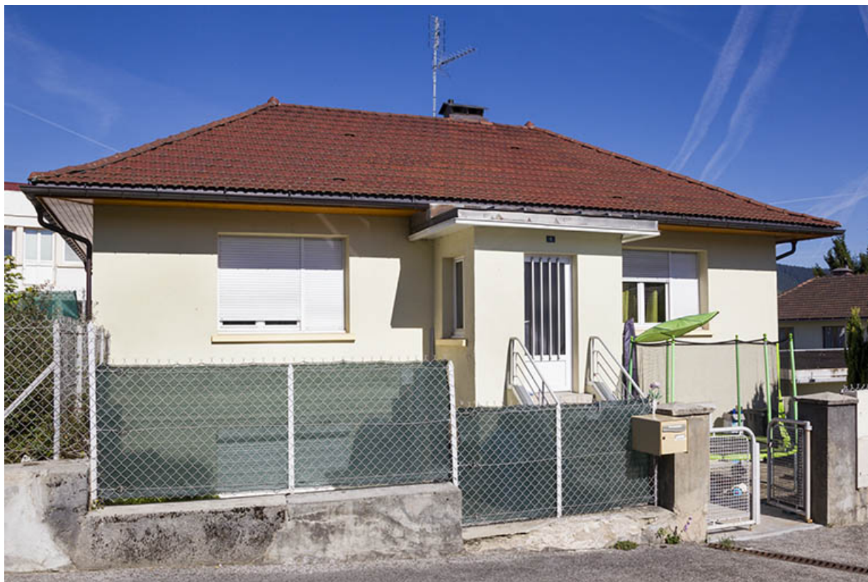
Maison au n° 5 rue Emile Cattin, de trois quarts gauche. 25, Morteau, 8 avenue Charles de Gaulle
