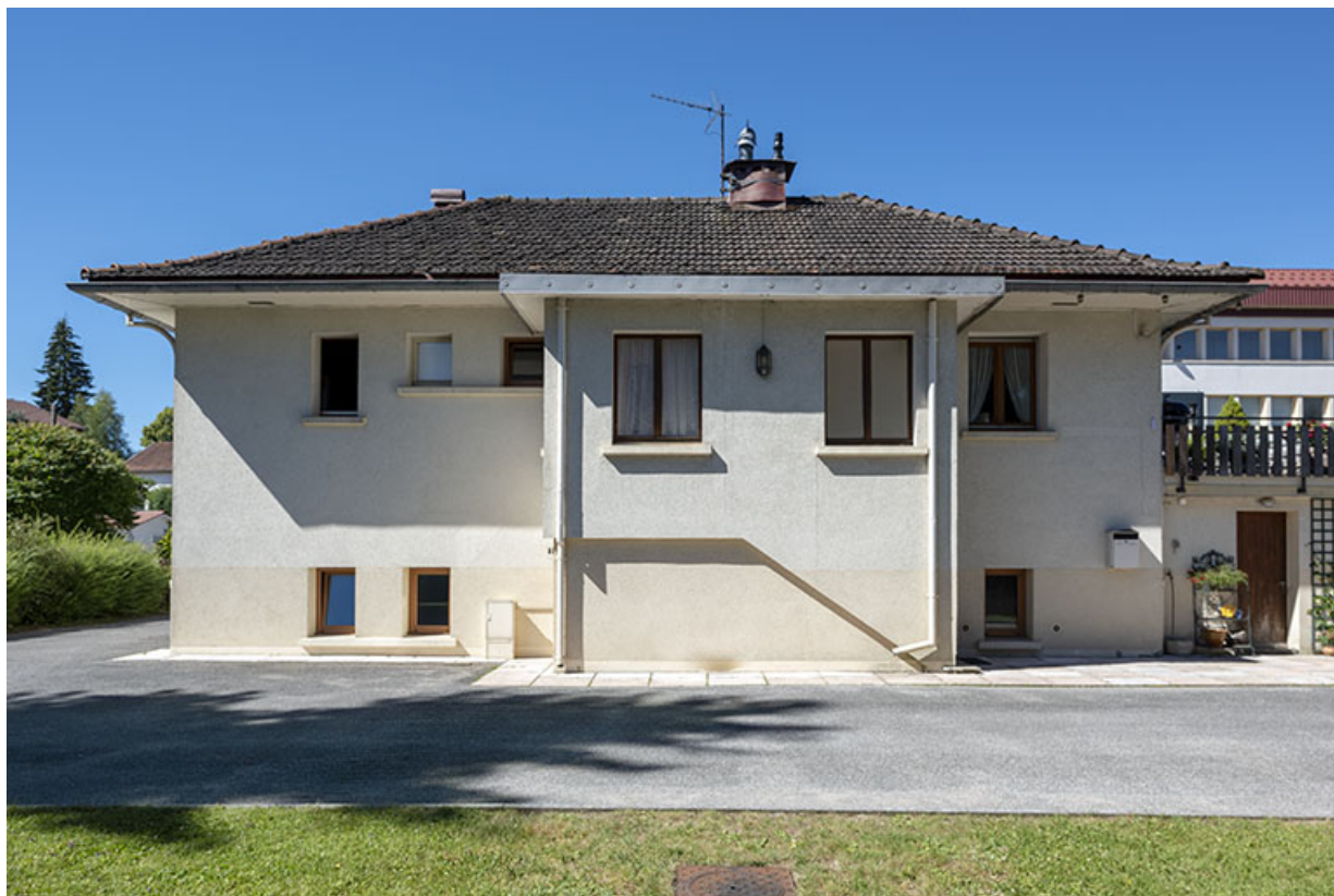
Maison au n° 9 rue Emile Cattin : façade postérieure. 25, Morteau, 8 avenue Charles de Gaulle
