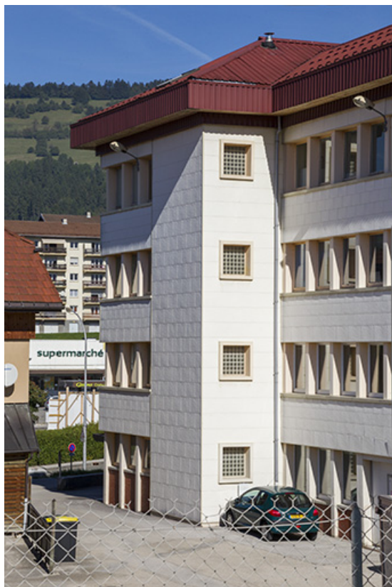
Usine : façade latérale droite et extrémité du corps principal. 25, Morteau, 8 avenue Charles de Gaulle
