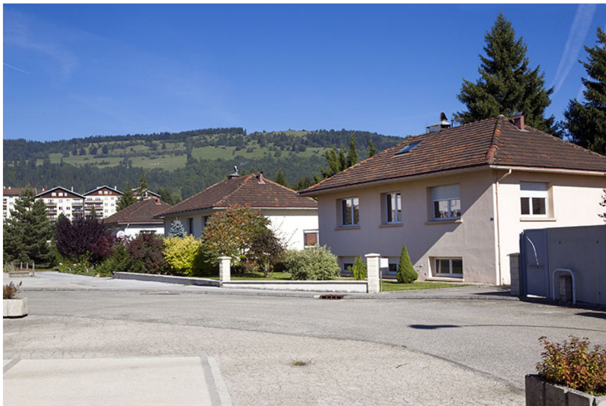
Maisons aux n° 7 (à gauche), 9 et 11 (à droite) rue Emile Cattin. 25, Morteau, 8 avenue Charles de Gaulle
