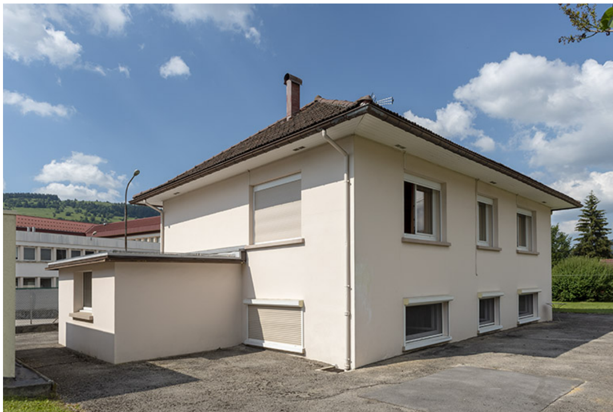
Maison au n° 10 rue Emile Cattin : façade postérieure, de trois quarts gauche. 25, Morteau, 8 avenue Charles de Gaulle
