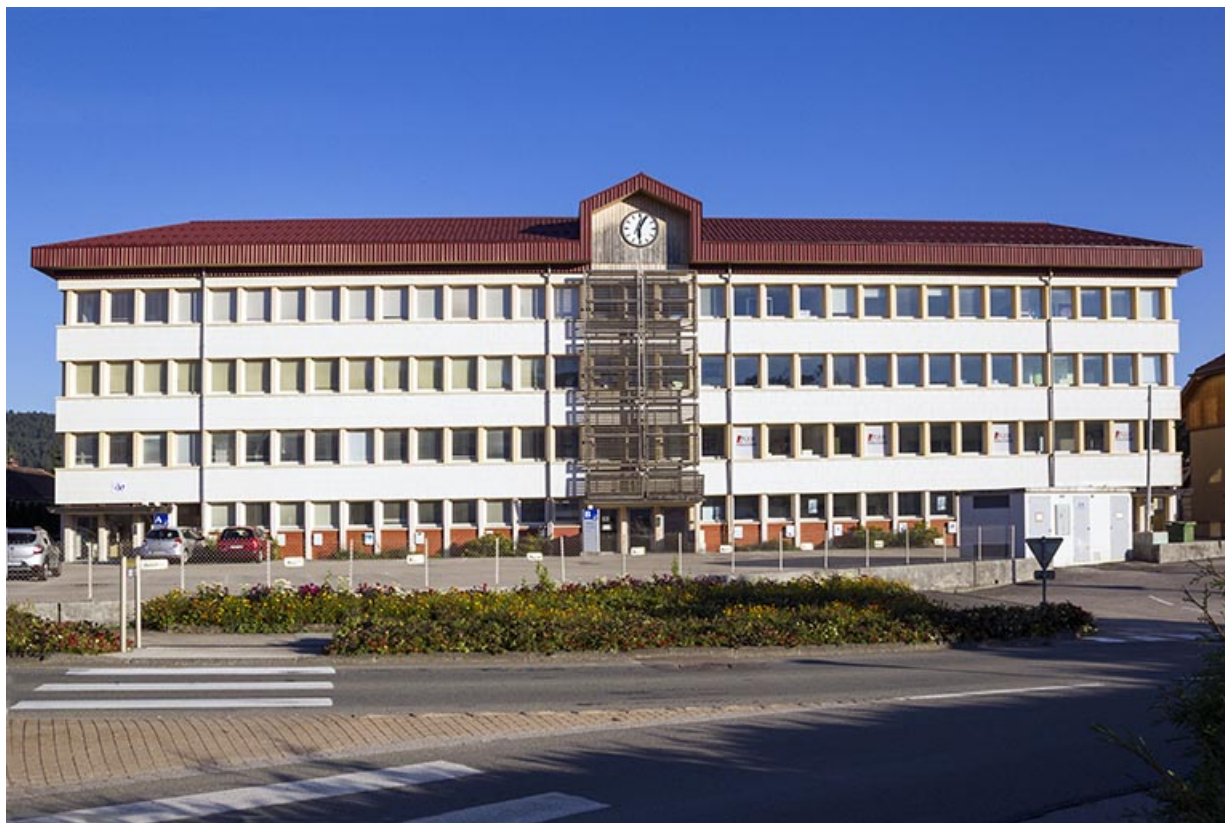
Usine : façade antérieure. 25, Morteau
