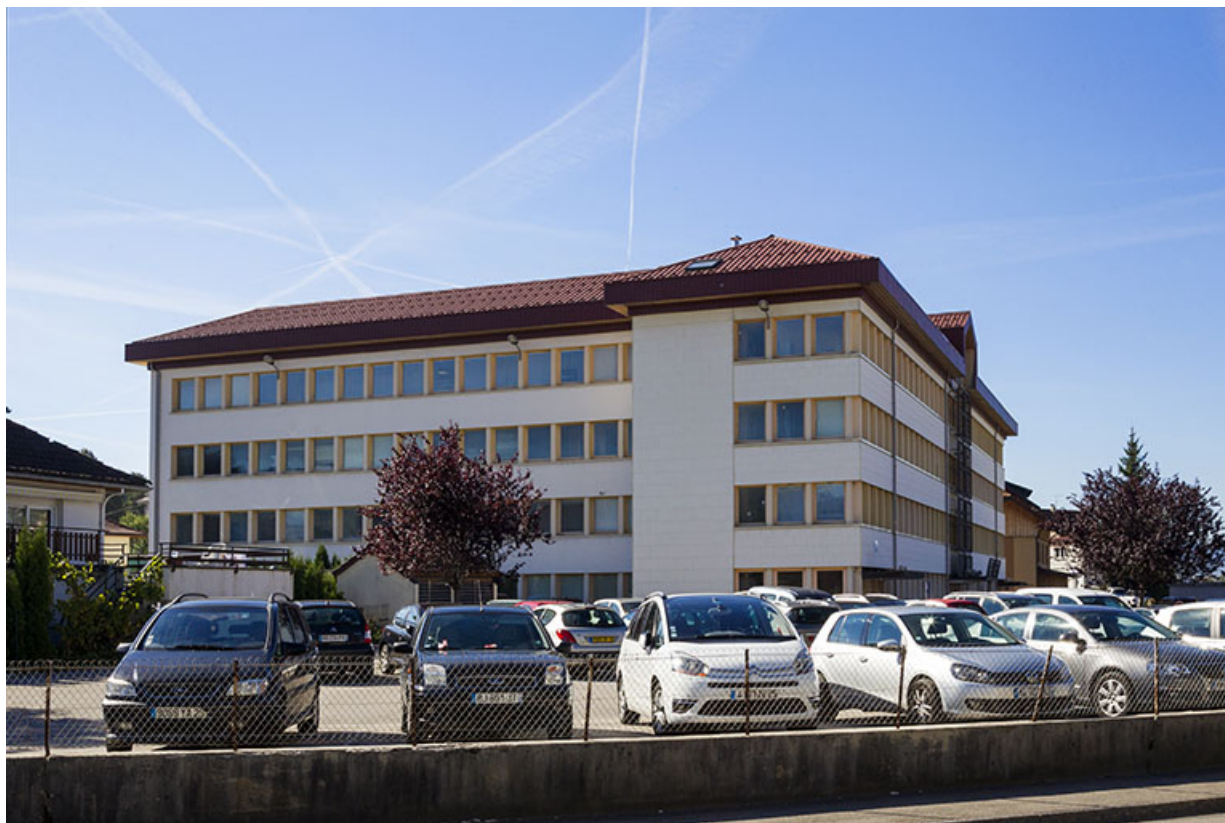
Usine : façade latérale gauche, de trois quarts. 25, Morteau, 8 avenue Charles de Gaulle
