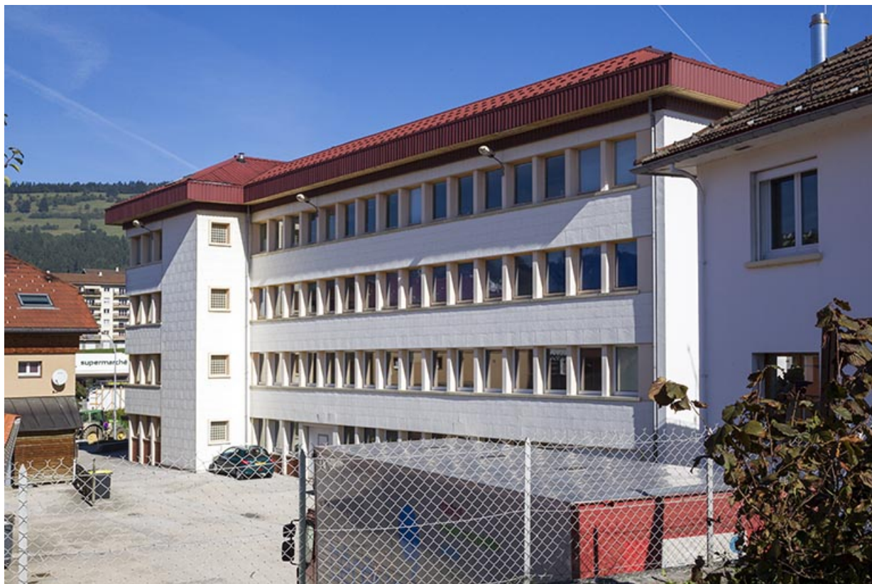
Usine : façade latérale droite, vue en enfilade.
