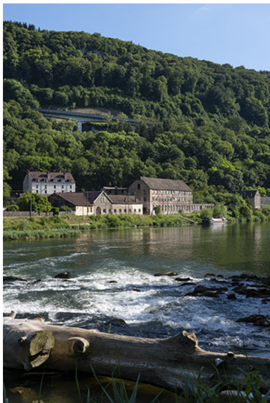
Vue d'ensemble depuis le nord-est (cadrage vertical).
