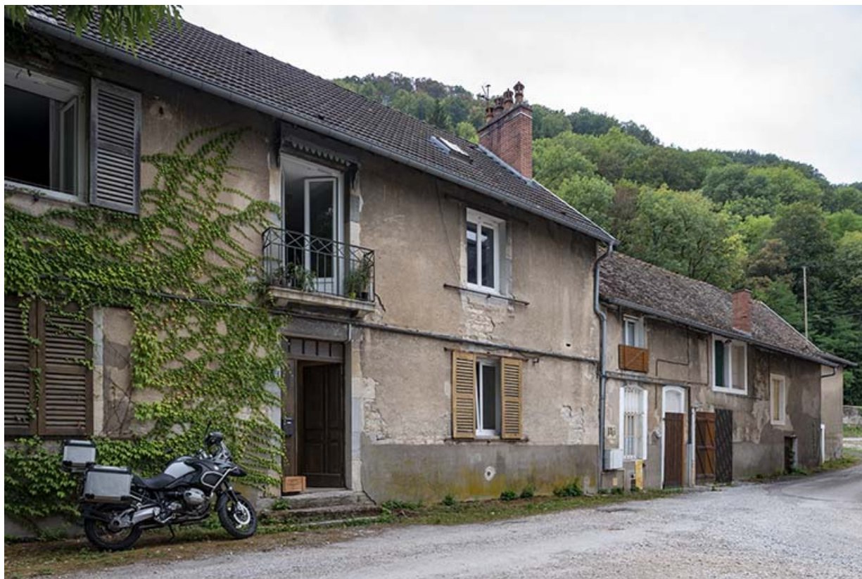
Façade antérieure d'un logement et du bâtiment des écuries et remises.
