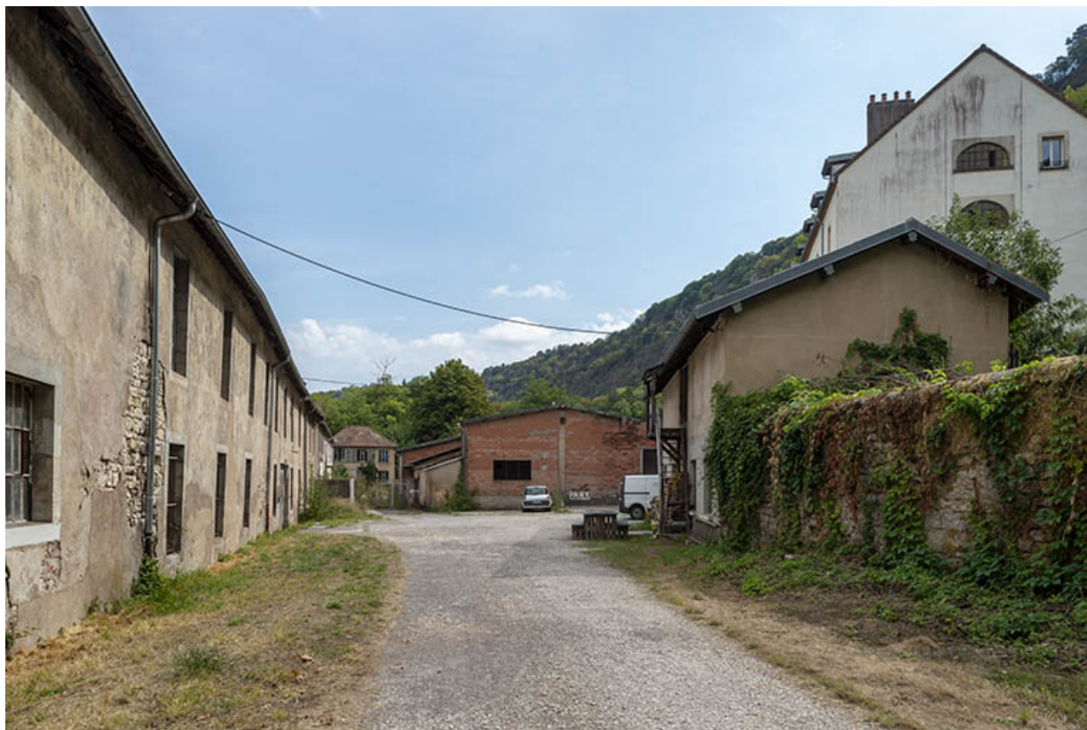
Cour sud. Fonderie à gauche et logement à droite.
