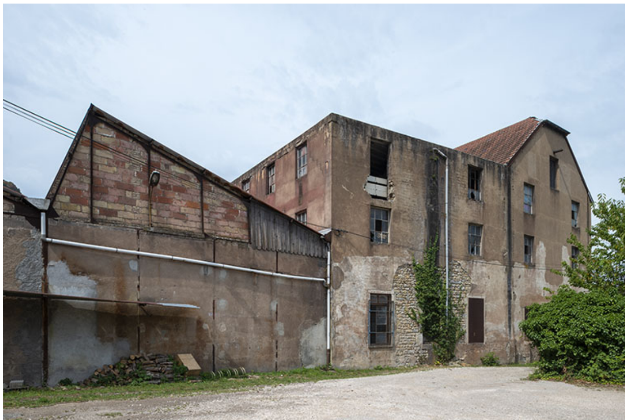
Murs-pignons des ateliers, depuis la cour de la faïencerie.
