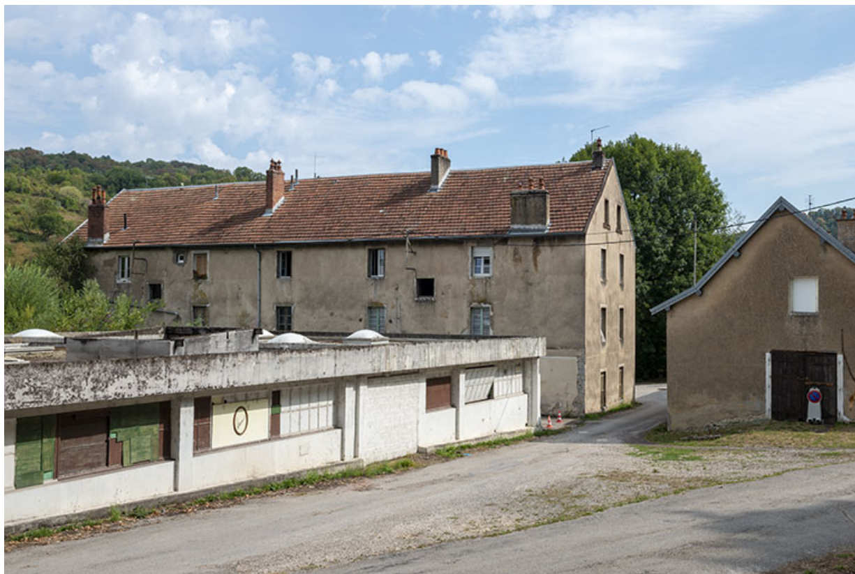
Atelier (3e quart 20e siècle) et logement ouvrier, depuis le sud-ouest.
