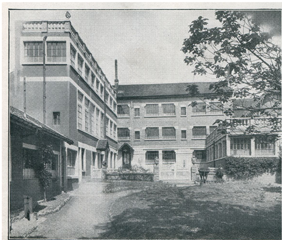
Vue de l'Usine ATO de Besançon.
