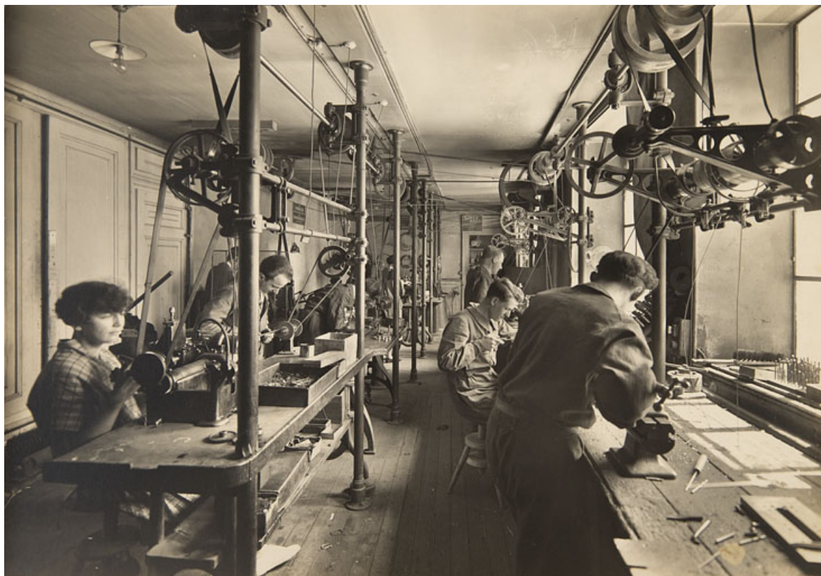
Un des ateliers de mécanique pour la fabrication de l'outillage, 1933.
