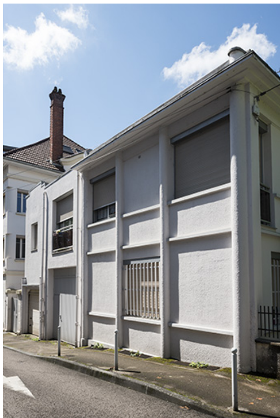
Façade antérieure vue de trois quarts droite. 25, Besançon, 15 rue Klein
