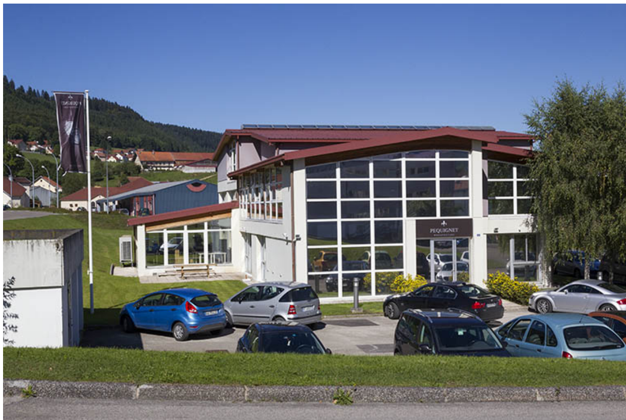
Vue d'ensemble, depuis le sud (façade antérieure).
