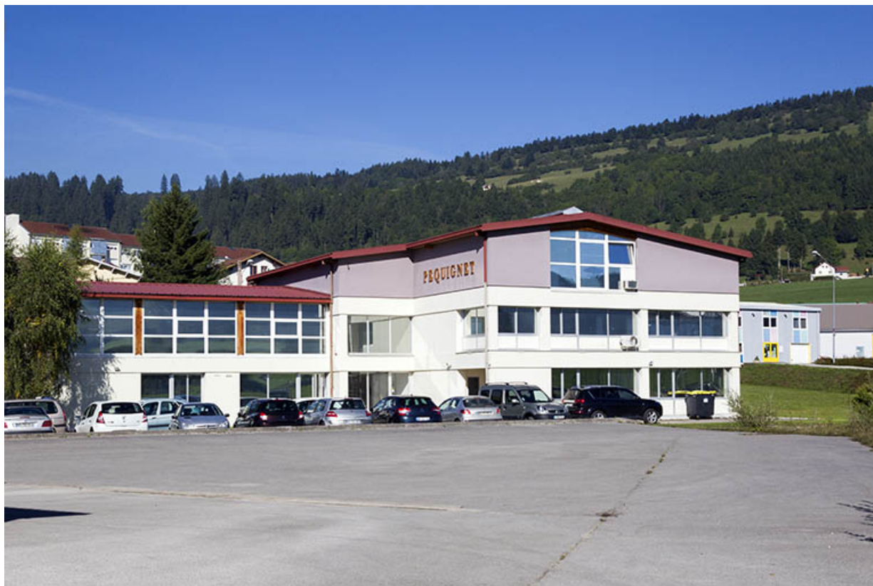
Façade latérale droite, de trois quarts gauche.
