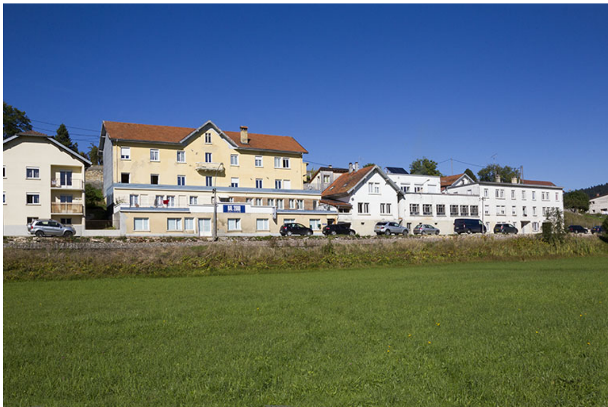
Vue d'ensemble, depuis le sud. De gauche à droite : l'ancien hôtel, la maison et les deux ateliers. 25, Morteau, 49-55 rue de l' Helvétie
