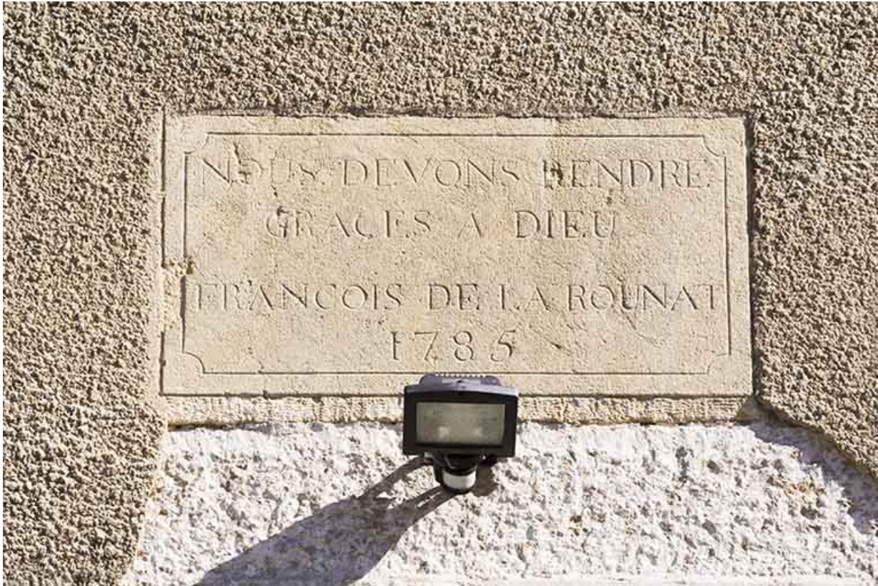
Façade latérale gauche : inscription et date 1785.
