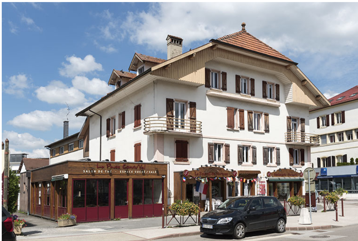
Vue d'ensemble, de trois quarts gauche. 25, Morteau, 15 rue de l' Helvétie
