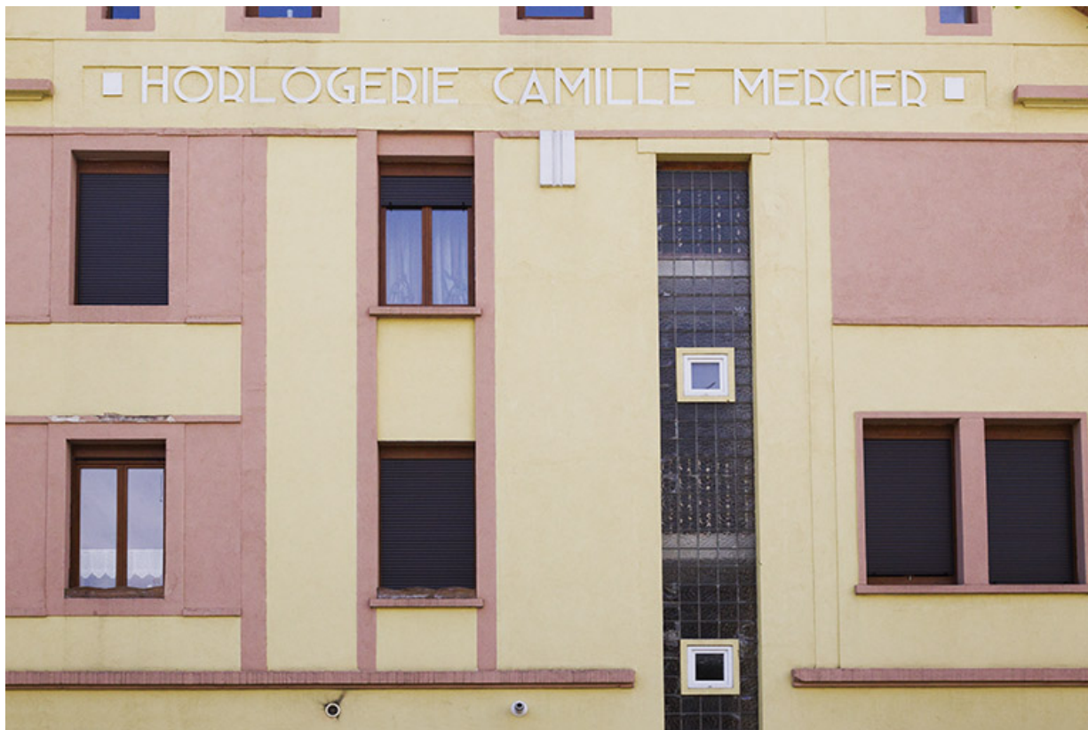
Immeuble : façade latérale droite (étages). 25, Morteau
