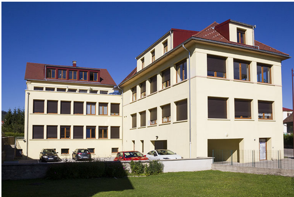
Vue d'ensemble, depuis le sud (extension et atelier).
