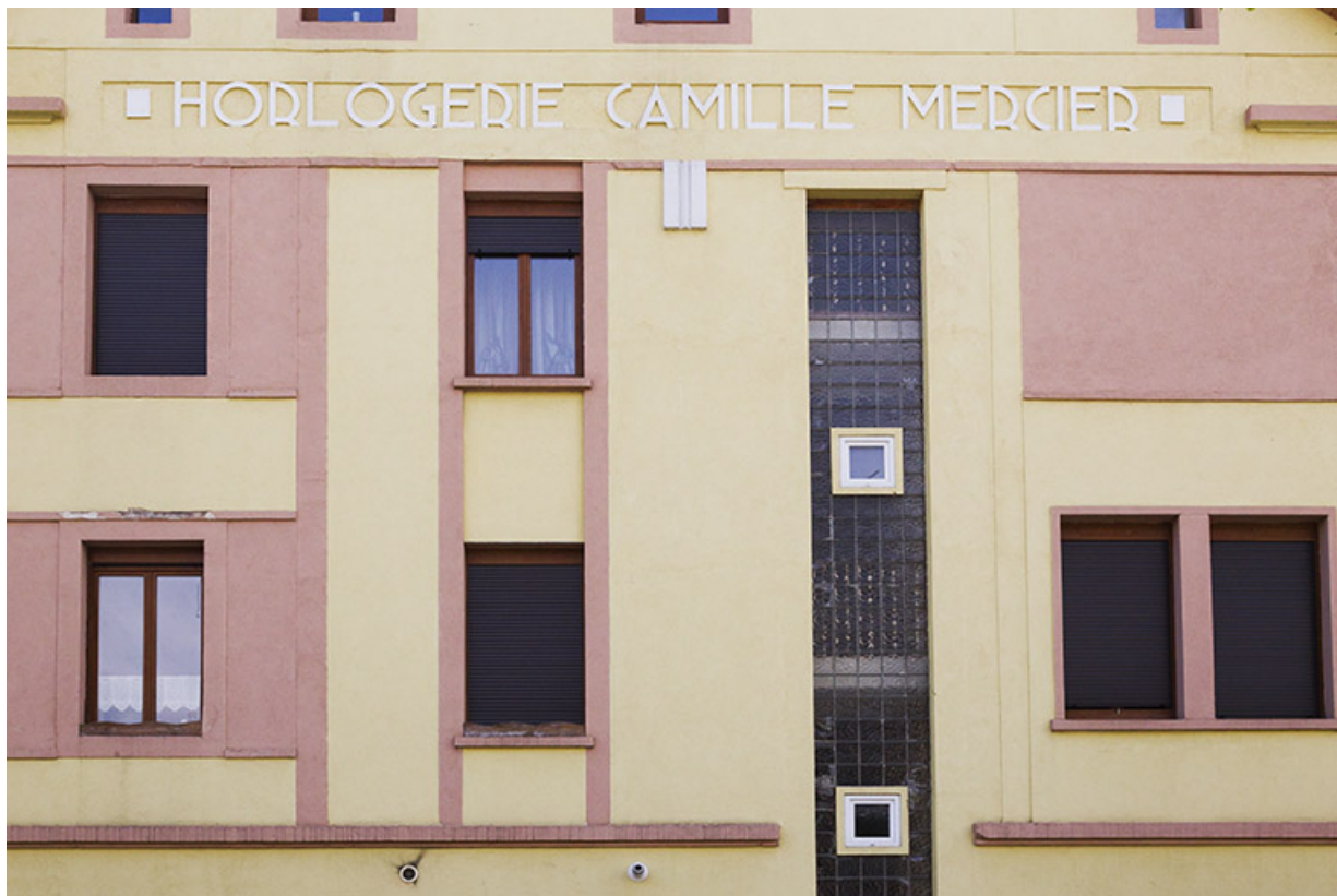
Immeuble : façade latérale droite (étages). 25, Morteau
