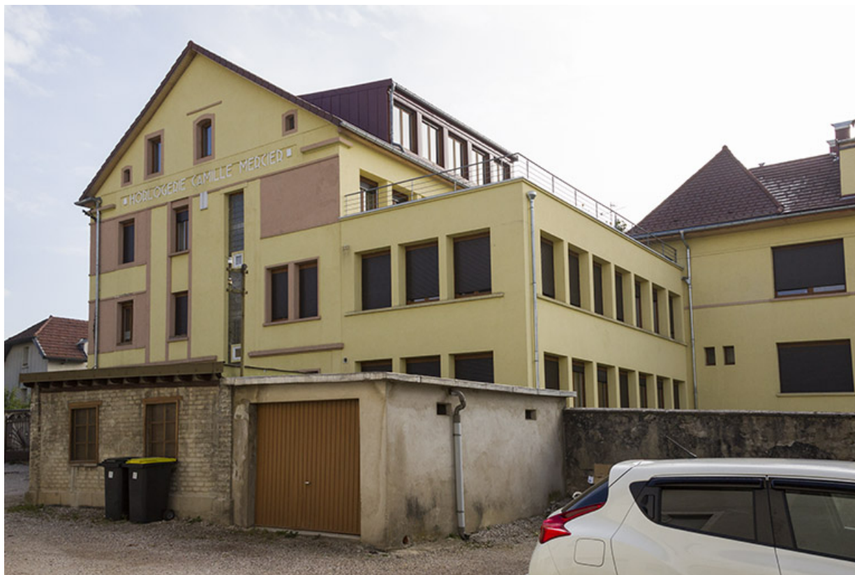
Immeuble et extension, depuis le sud-ouest. 25, Morteau, 8 rue de l' Helvétie
