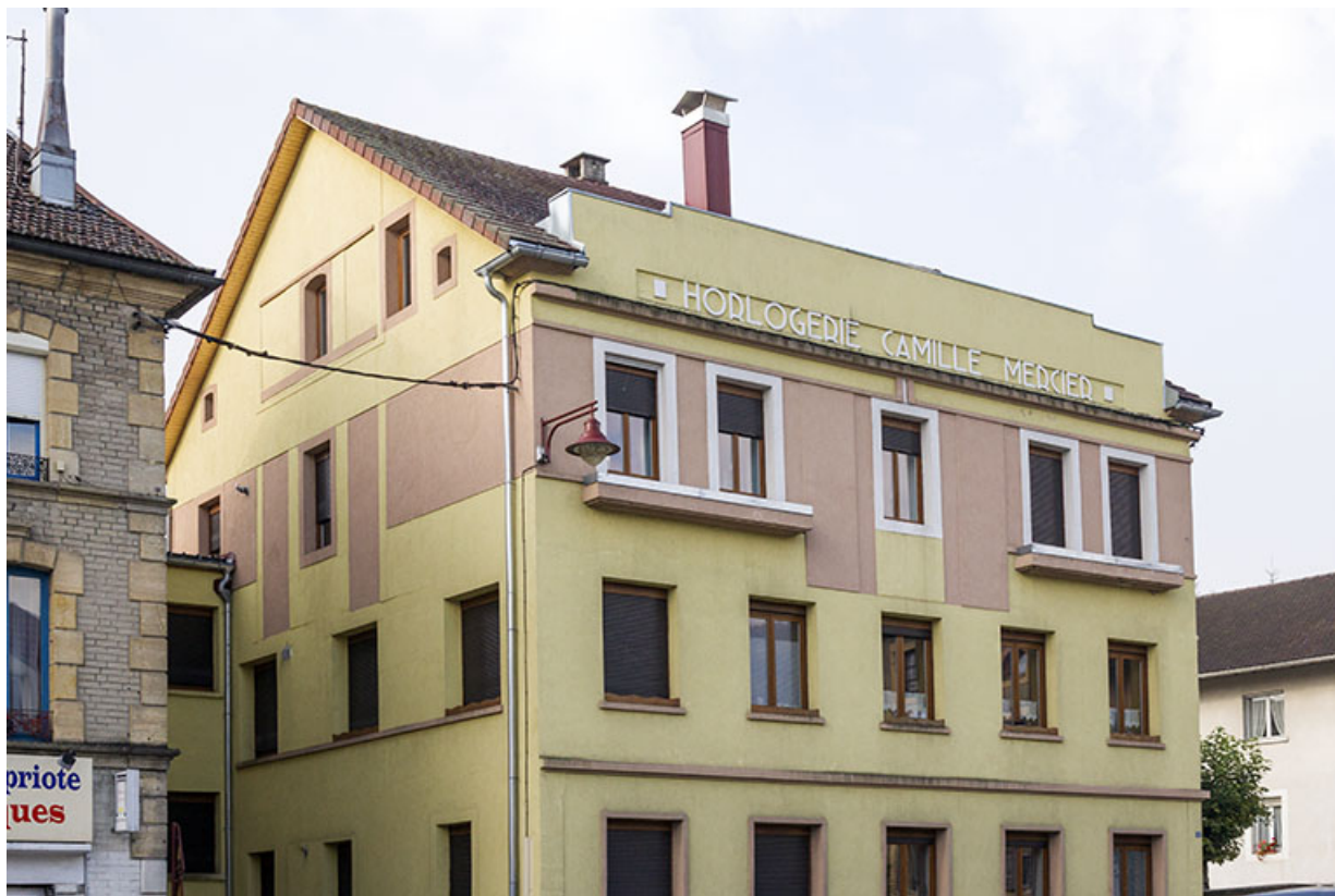
Immeuble : façades antérieure et latérale gauche.
