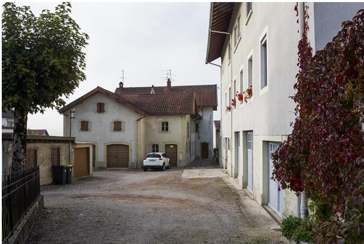
Corps de bâtiment en fond de cour, depuis le nord.
