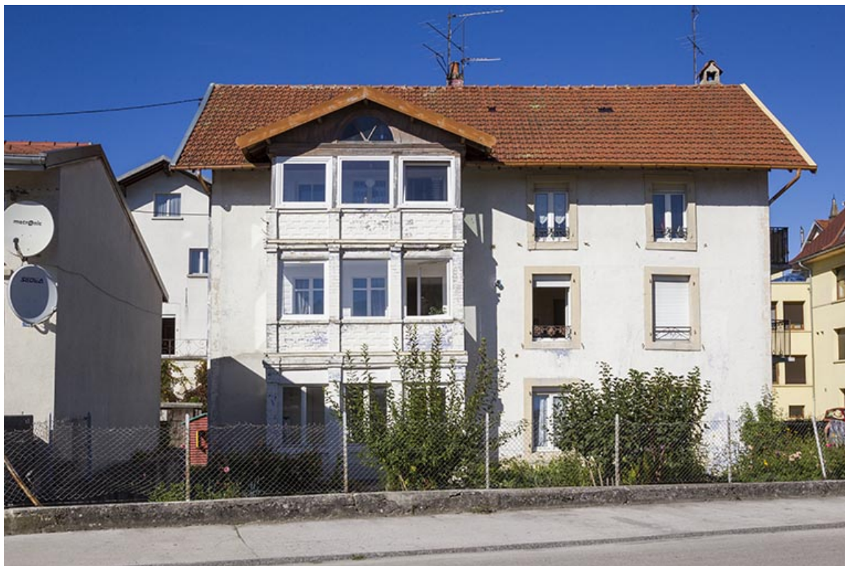
Corps de bâtiment en fond de cour : façade sud.
