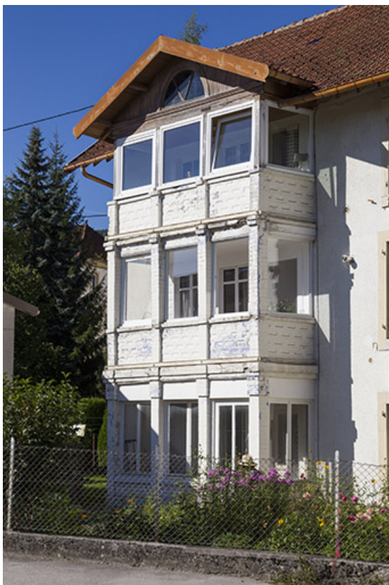
Corps de bâtiment en fond de cour : oriel montant de fond sur la façade sud. 25, Morteau, 4 rue de l' Helvétie
