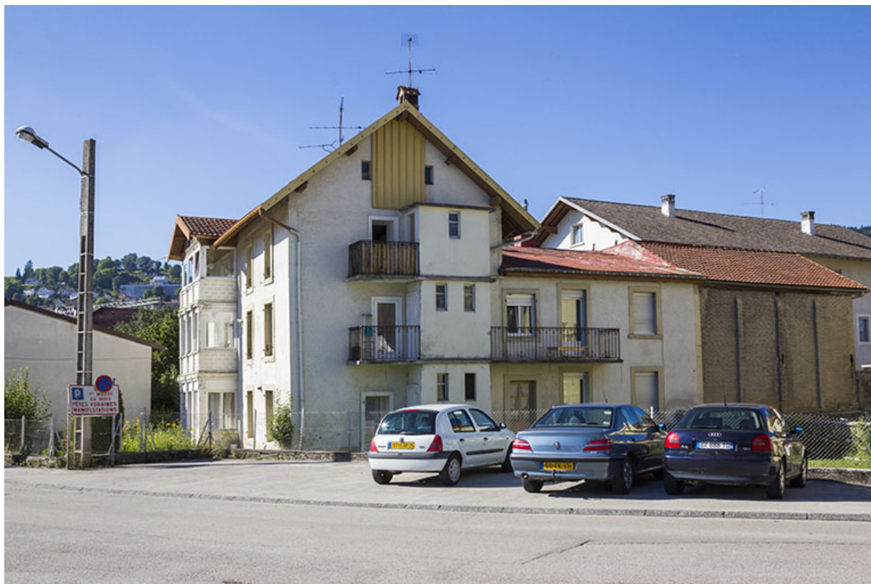
Corps de bâtiment en fond de cour, depuis l'est. 25, Morteau, 4 rue de l' Helvétie
