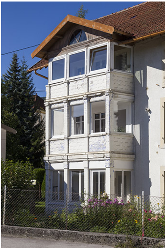
Corps de bâtiment en fond de cour : oriel montant de fond sur la façade sud. 25, Morteau, 4 rue de l' Helvétie
