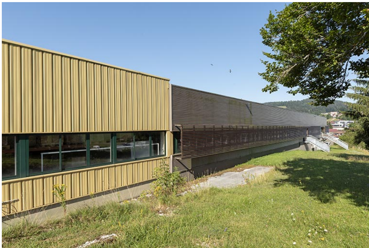
Façade postérieure, vue en enfilade.
