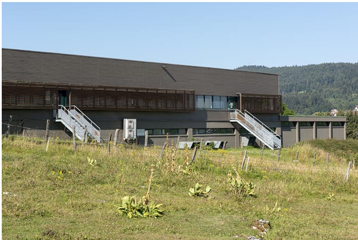
Façade postérieure : escaliers extérieurs vers l'angle nord-ouest.
