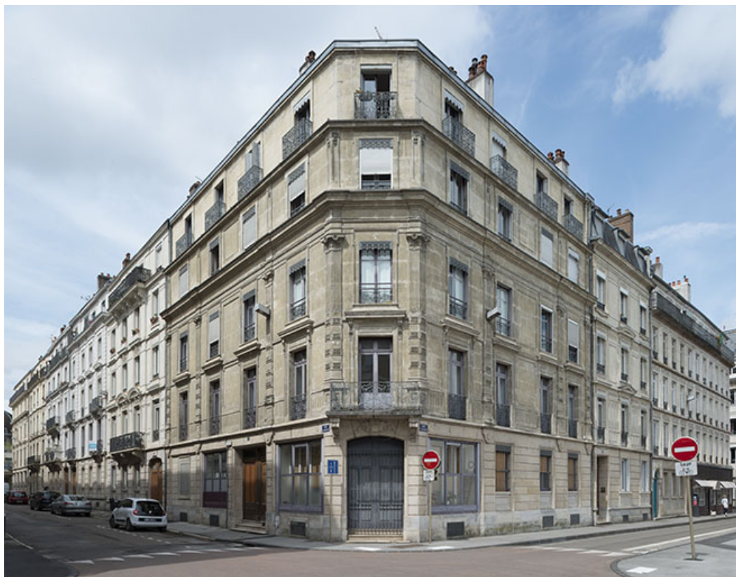
Vue de l'immeuble à l'intersection des rues d'Alsace et de Lorraine.
