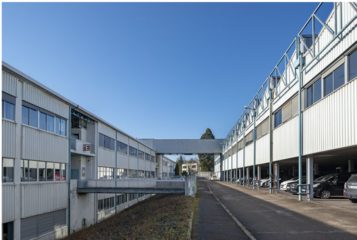
Passage entre le bâtiment administratif et l'atelier de fabrication. Vue rapprochée. 25, Besançon chemin de Palente
