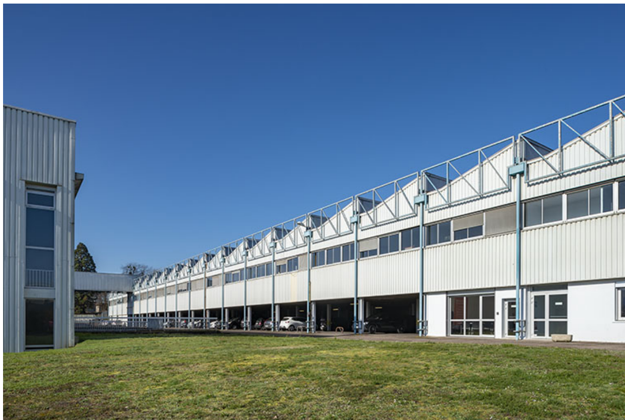
Façade est de l'atelier principal de fabrication.
