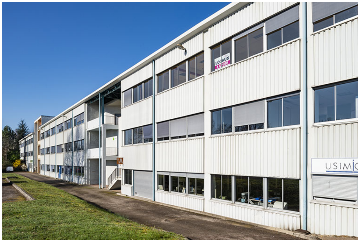
Élévation du bâtiment abritant les services administratifs, le service après-vente et les ateliers de montage. 25, Besançon chemin de Palente
