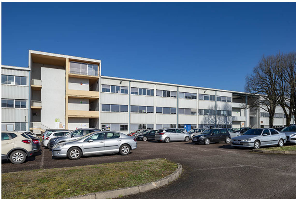
Façade est du bâtiment abritant l'atelier de montage et le service après-vente 25, Besançon chemin de Palente
