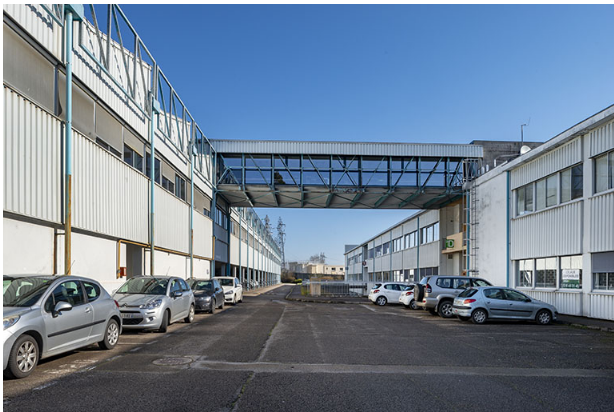
Passage entre l'atelier de fabrication et le bâtiment administratif. Vue depuis le sud. 25, Besançon chemin de Palente
