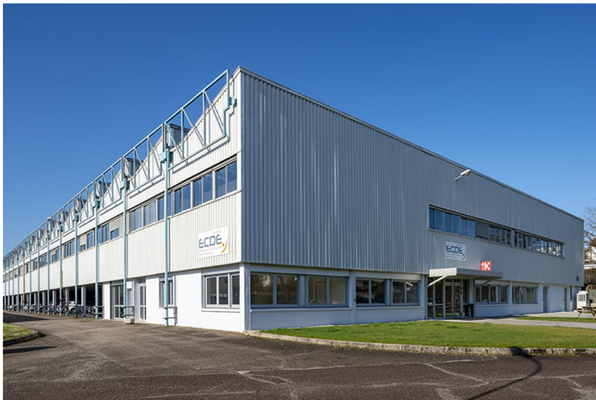
Atelier de fabrication vu depuis le nord-est. 25, Besançon chemin de Palente
