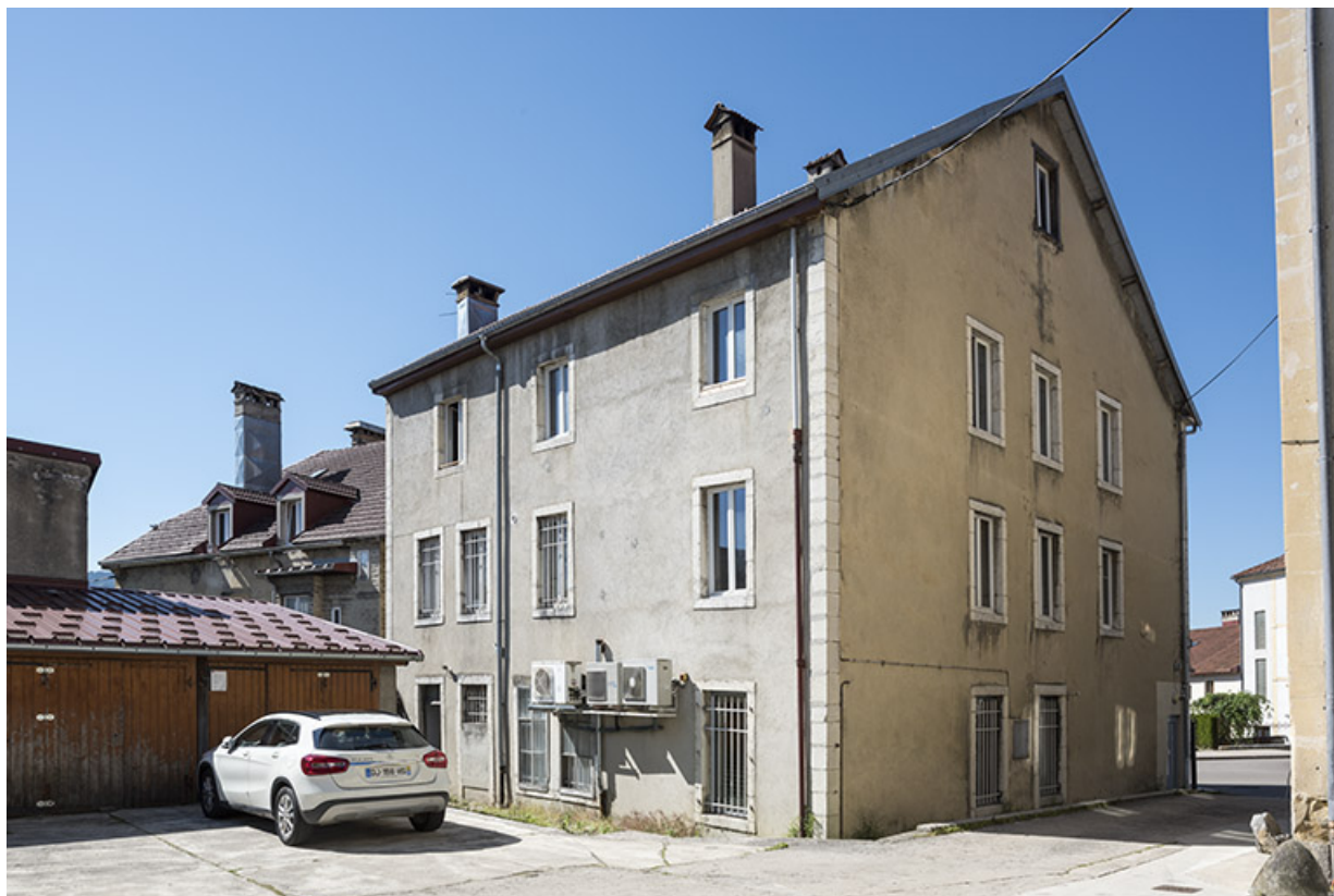
Façades postérieure et latérale gauche.
