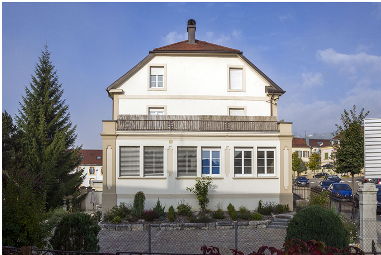
Façade latérale gauche, avec l'atelier.
