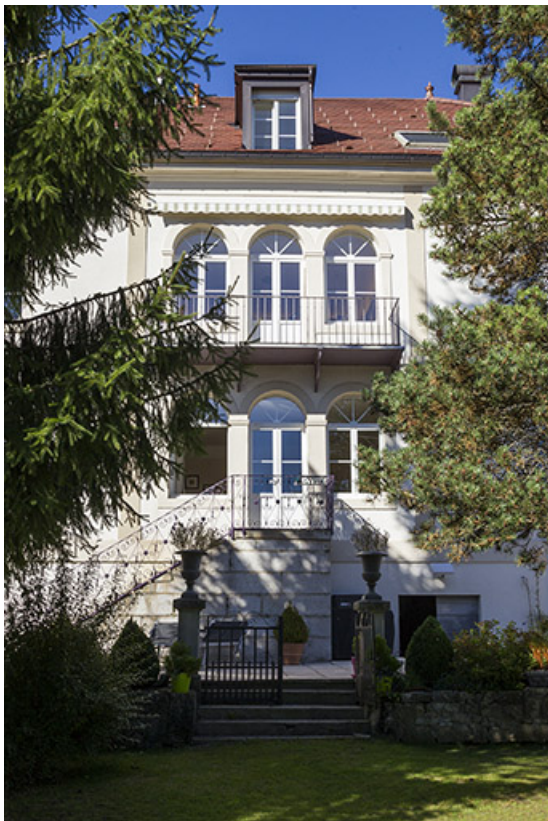
Façade postérieure : travée centrale.
