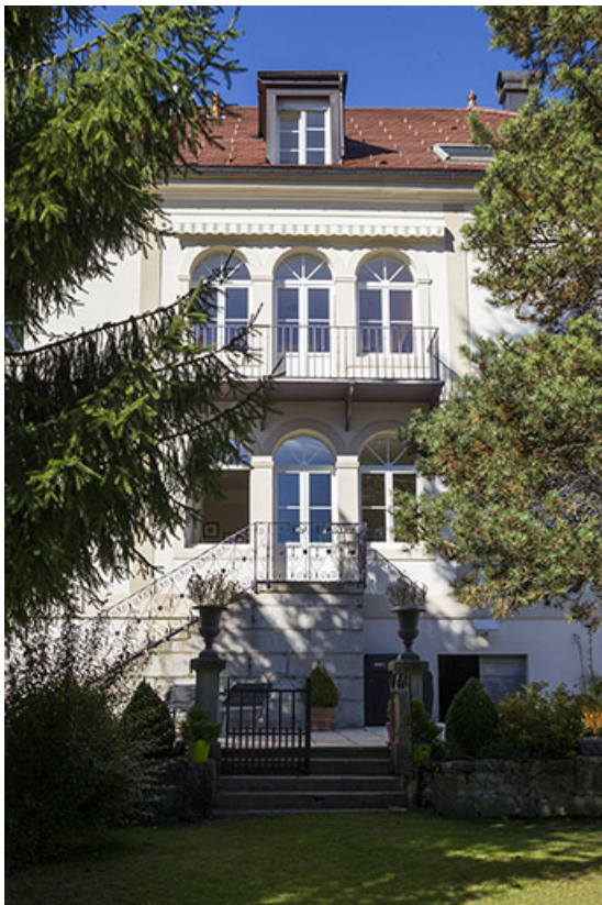
Façade postérieure : travée centrale.
