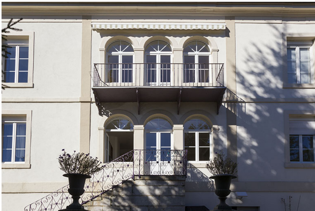
Façade postérieure : baies de la travée centrale.
