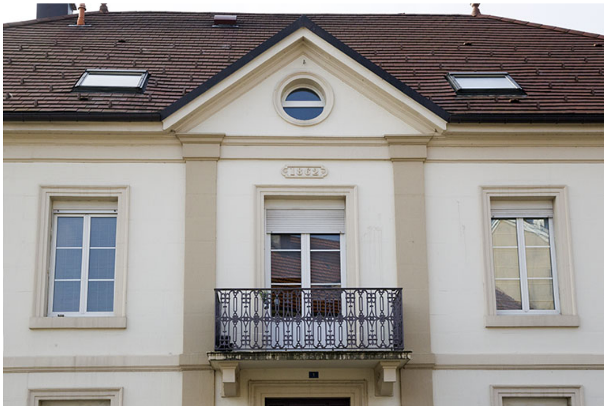
Façade antérieure : premier étage.
