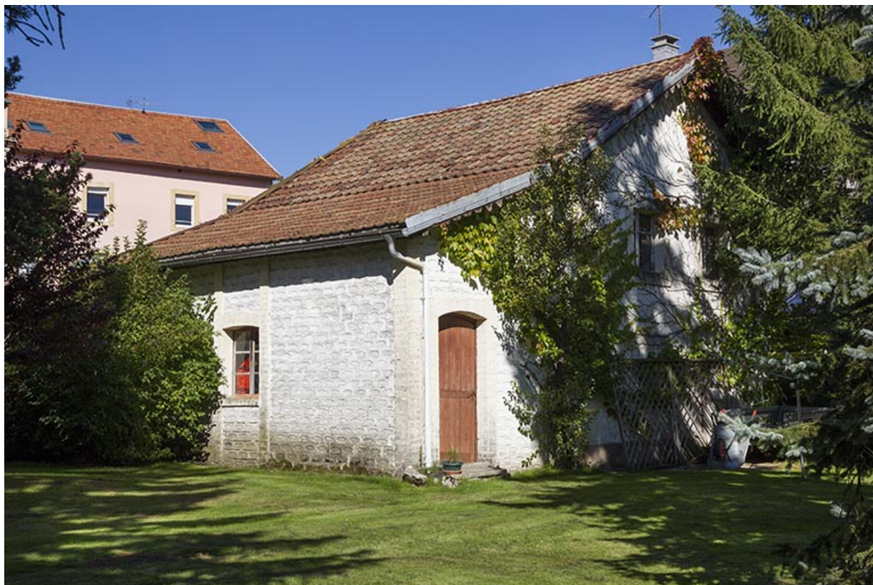
Dépendance (autrefois écurie, remise et logement du cocher).
