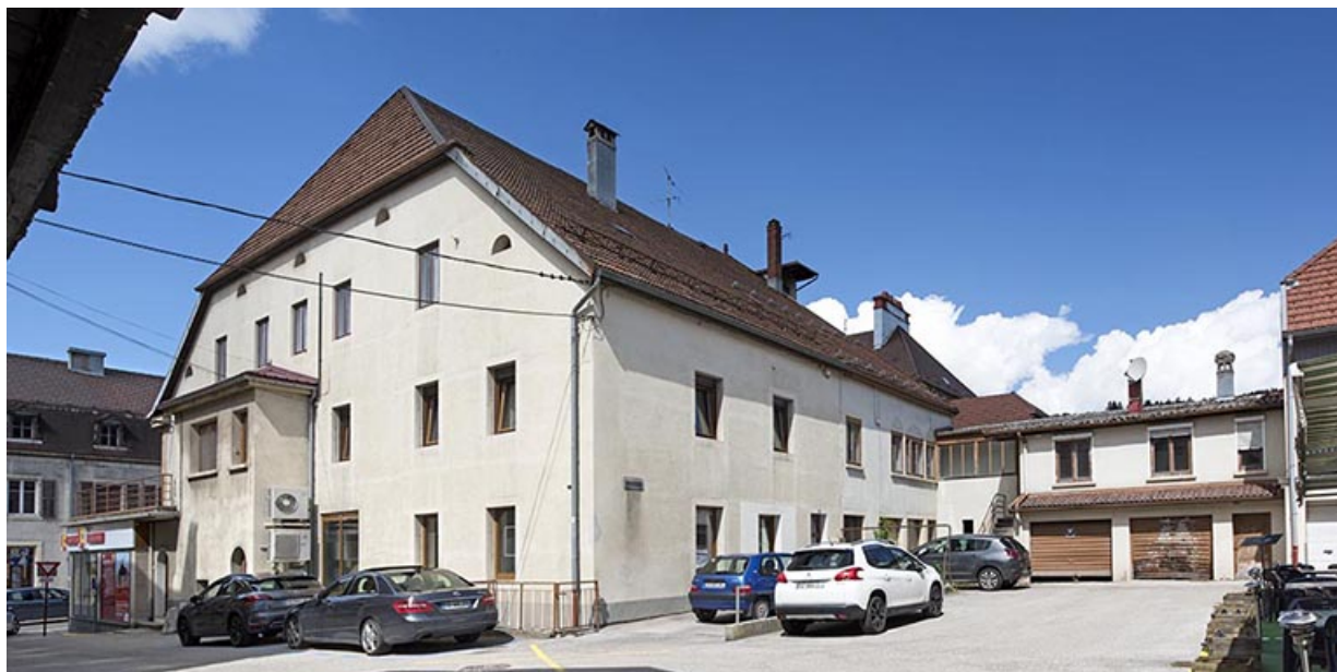
Maison : façades latérale droite et postérieure.
