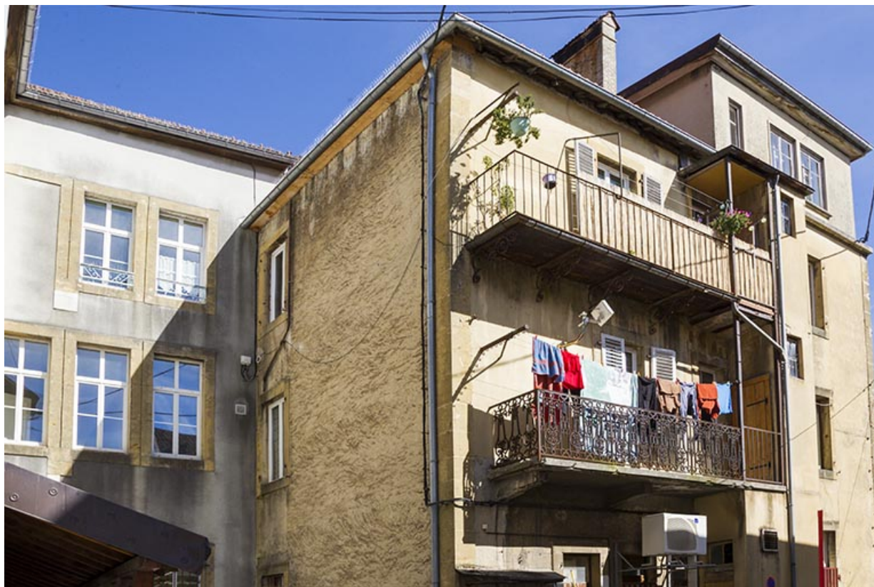
Façades postérieure et latérale droite.
