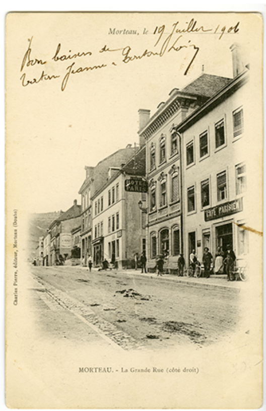
Morteau. - La Grande Rue (côté droit), 4e quart 19e siècle. Le bâtiment ne compte que deux étages. 25, Morteau, 14 et 14 bis Grande Rue
