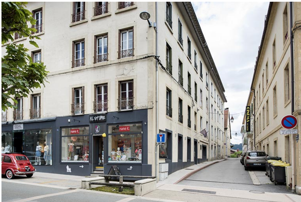
Façade latérale droite, vue en enfilade depuis la Grande Rue.
