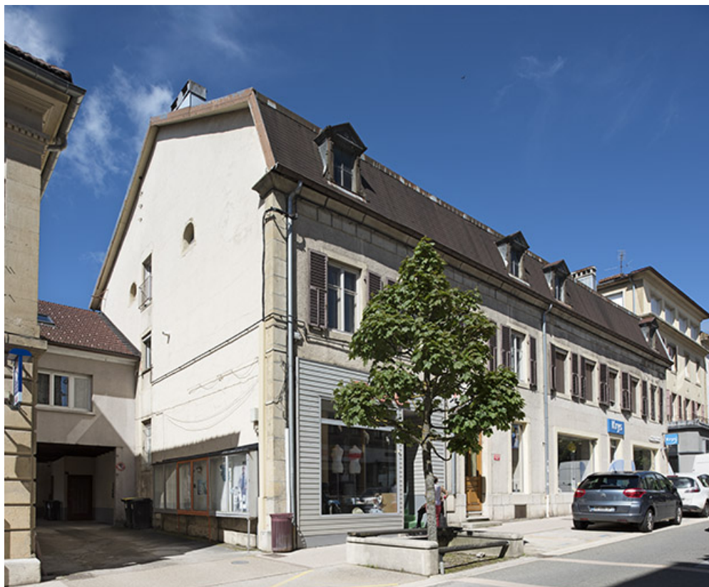
Façade antérieure, de trois quarts gauche. 25, Morteau, 13 Grande Rue
