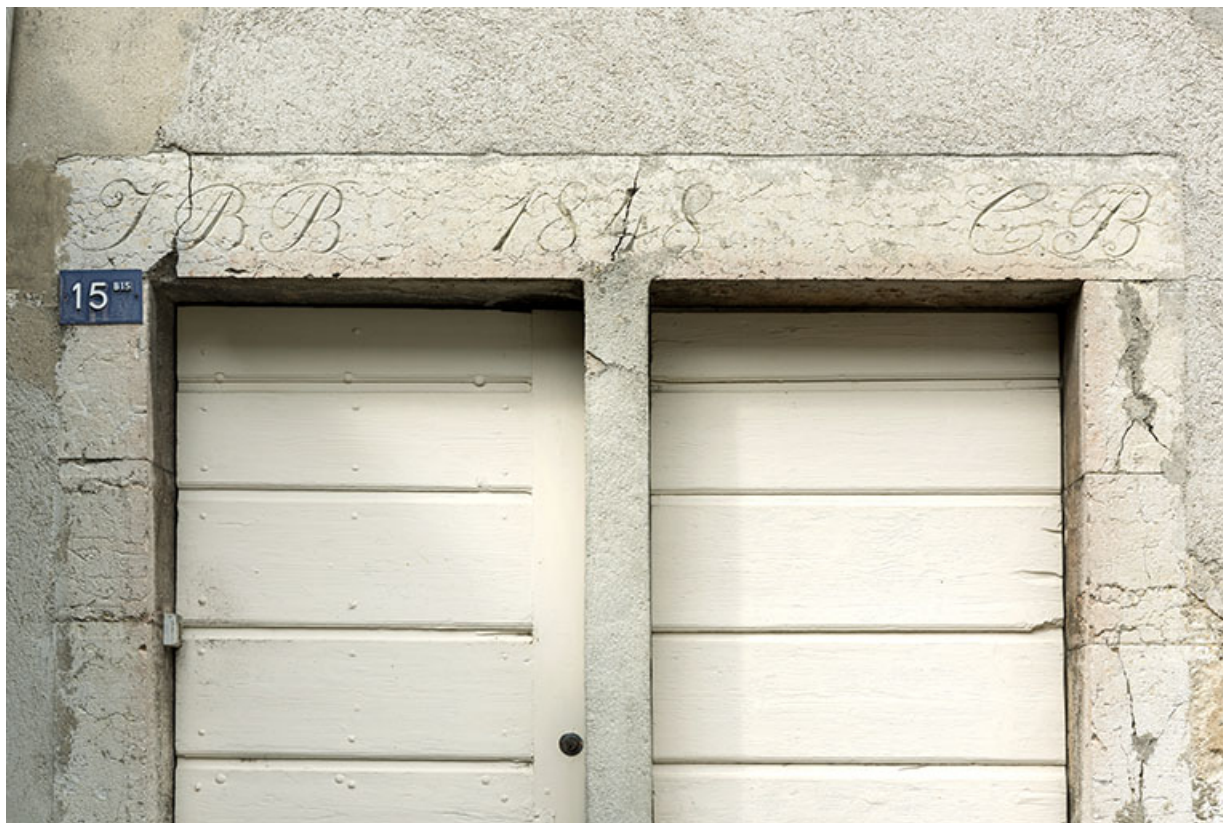
Maison côté cour : linteau daté 1848.
